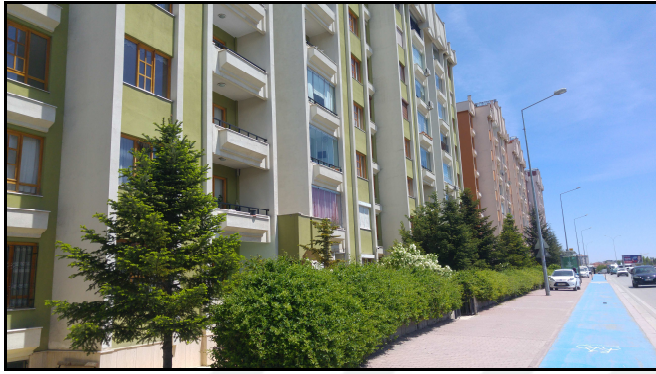
e)Yapı düzeni genel görünüm
