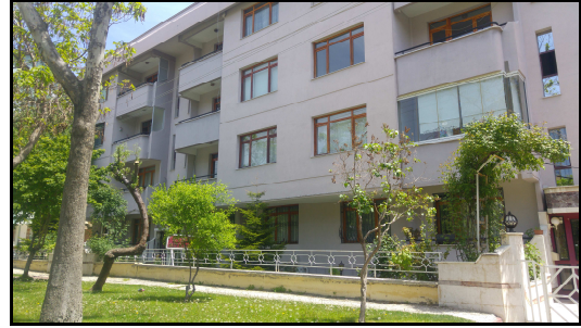
b) Konut cephesi
