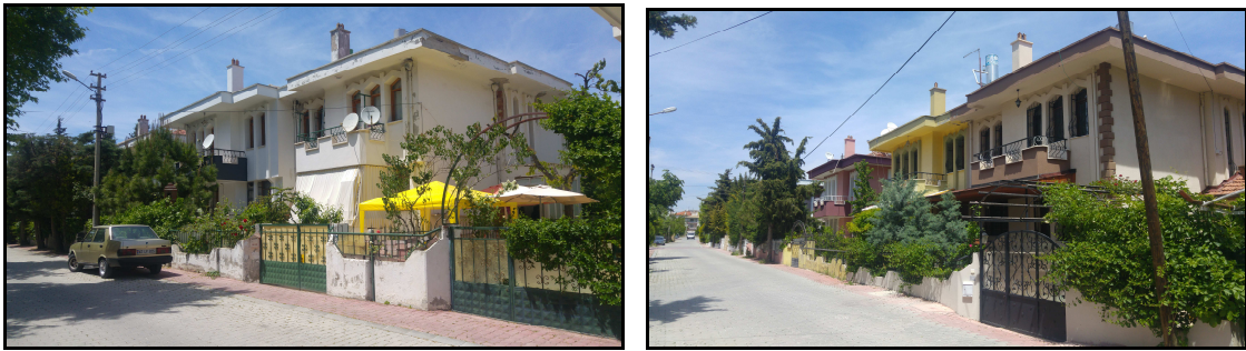
a) Yapı Nizamı - İki Farklı Cepheden Görünüm
