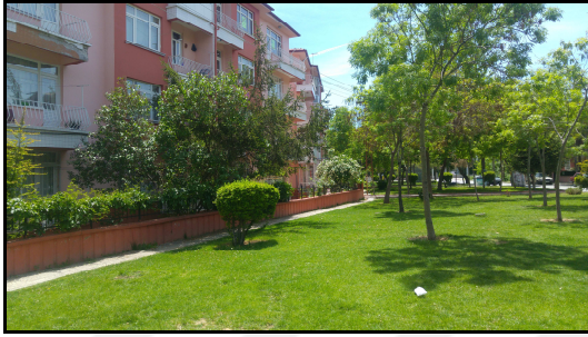
a) Konutların ön cephesi
