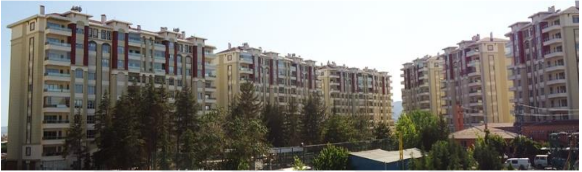
Şekil 4.2. Altınkoza Konakları Genel Yerleşim Görünümü
