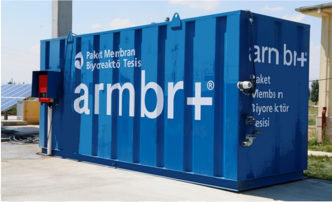
Şekil 3.9. Paket MBR sistemi genel görünüşü
