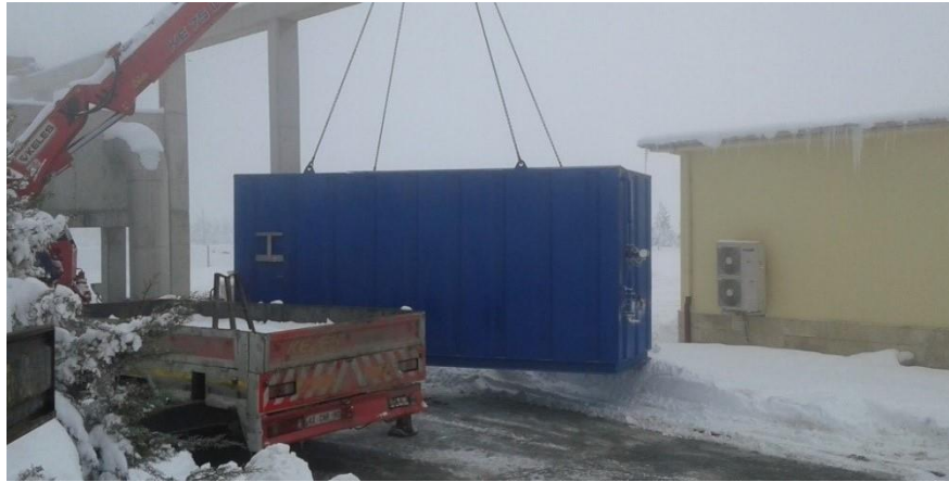
Şekil 3.1. Paket MBR sisteminin Konya AAT'ne nakliyesi
