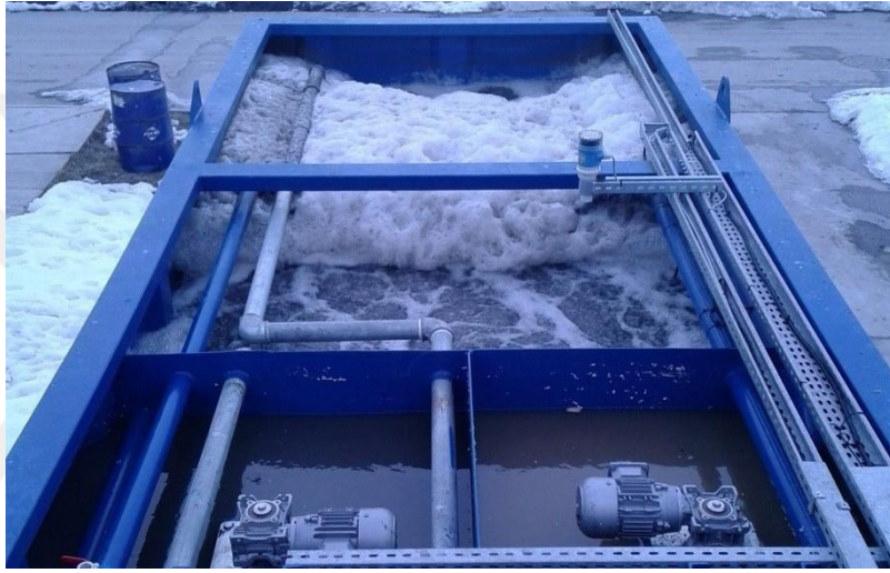
Şekil 3.3. Paket MBR sisteminin devreye alınması
