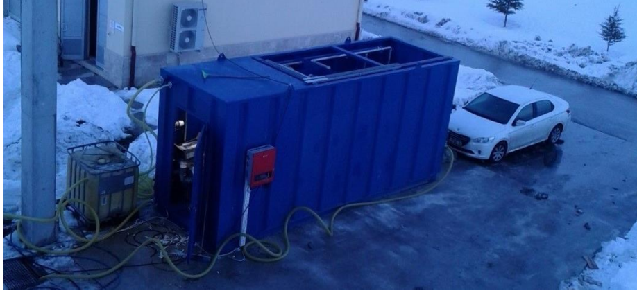
Şekil 3.2. Paket MBR sisteminin boru bağlantılarının yapılması
