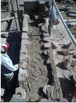
Rekonstrüksiyon olan kısmın duvar örülme tekniği
