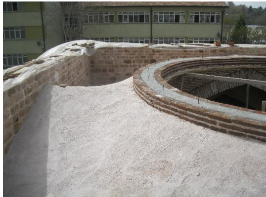
Avlu üst örtüsünün yapım tekniği
