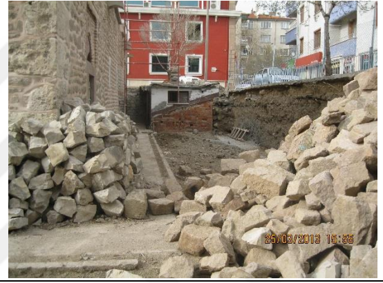
Restorasyon sırasında mevcut ek yapının yenilenmesi
