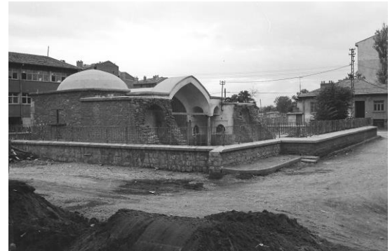
Kuzeybatı yönünden Medrese'nin Görünüşü (1988)
