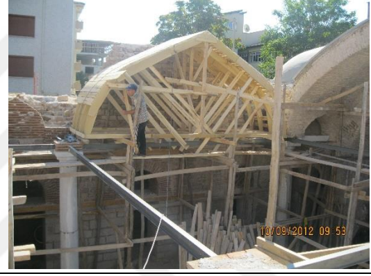
Rekonstrüksiyon olan kısmın üst örtü kalıbı
