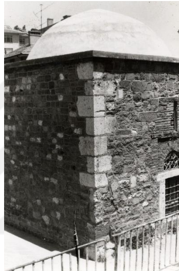
Restorasyon öncesinde kubbeli odaların görünüşü (1980'ler)
