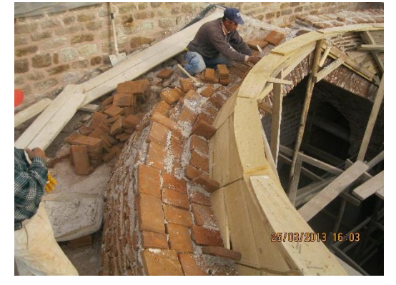
Avlu üst örtüsünün yapım tekniği
