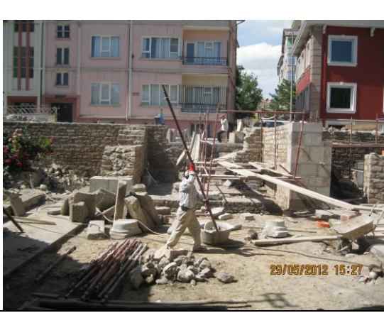
Restorasyon sırasında bahçe kısmına doğru bakış
