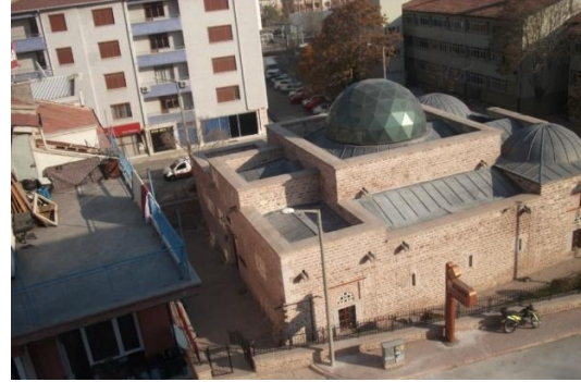
Şekil 3.18. Medresenin 2013 Yılı Restorasyonunun Sonraki Hali (AynurYılmazArşivinden)
