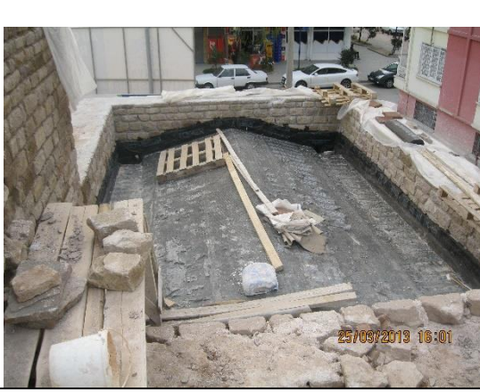
Türbe odasının üst örtü yapım tekniği
