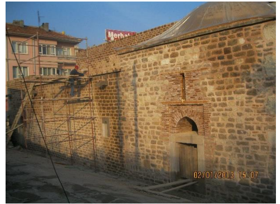
Batı cephesi restorasyon sonuna doğru
