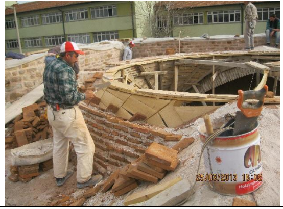
Kubbeli odaların üst örtü yapım tekniği
