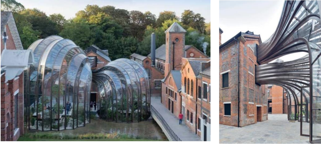
Şekil 3.2. Bombay Sapphire İçki Üretim Tesisi (Gençoğlu, 2018)
