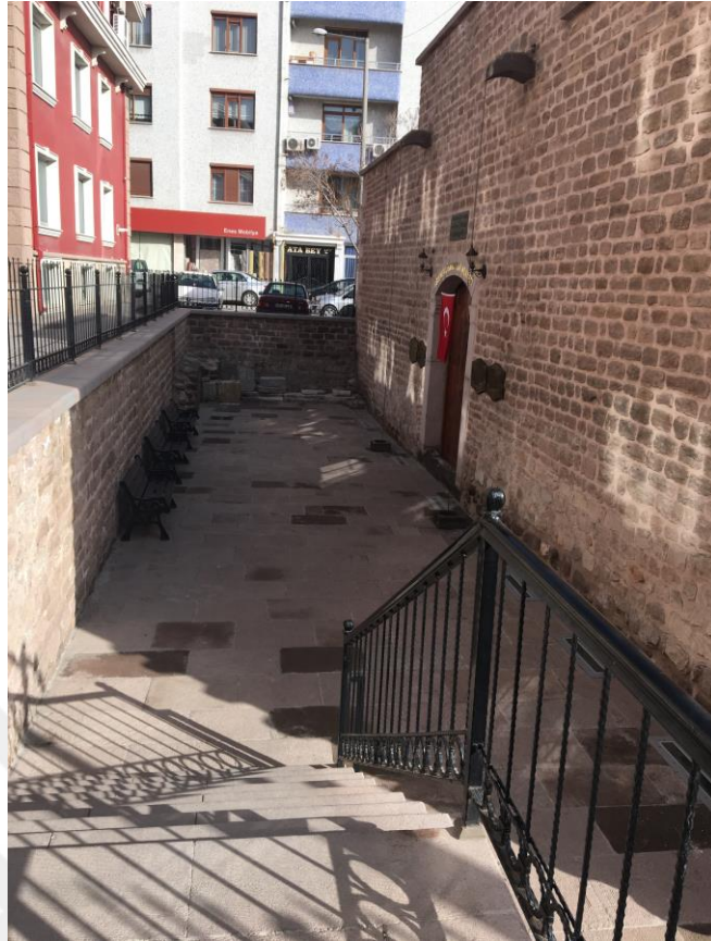
Şekil 3.11. Yapının Giriş Kotuna İniş
