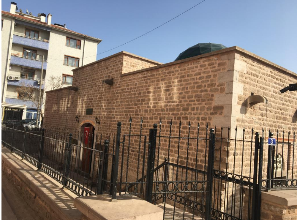
Şekil 3.41. Yapının Kuzey Cephesi
