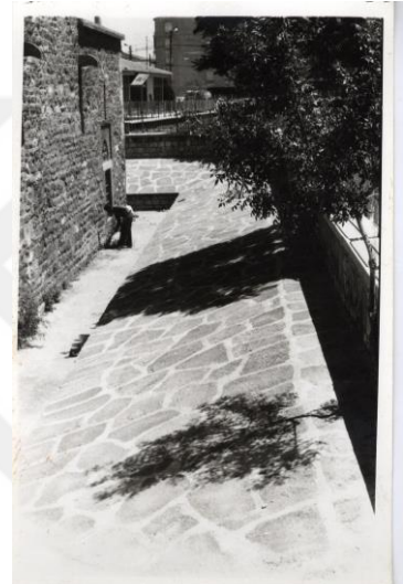
Restorasyondan önce bahçe zemininin görünümü (1980'ler)
