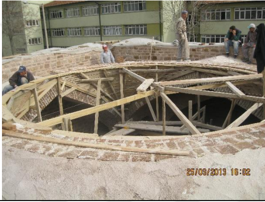
Kubbeli odaların üst örtü yapım tekniği
