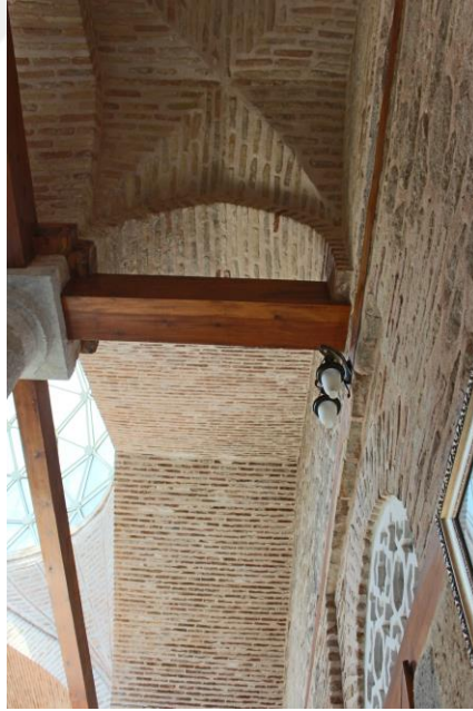
Şekil 3.23. Avlu revaklı kısım üst örtüsü
