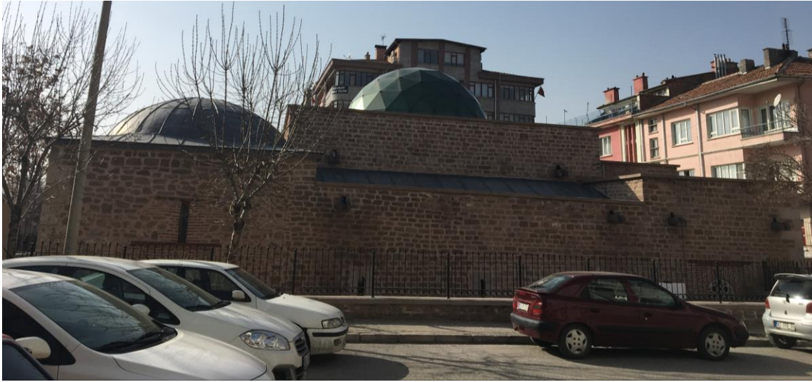
Şekil 3.42. Yapının Doğu Cephesi
