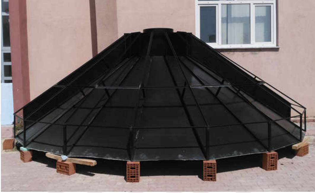
Şekil 3.12. Montajı Tamamlanan Kollektörün Önden Görünümü
