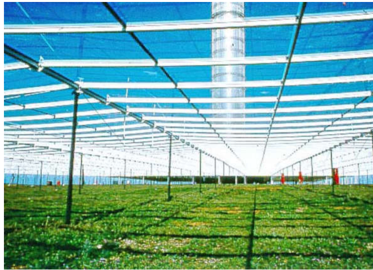
Şekil 2.7. Manzanares Prototipinin Kollektörünün Alt Kısmı (Schlaich ve ark., 2005)
