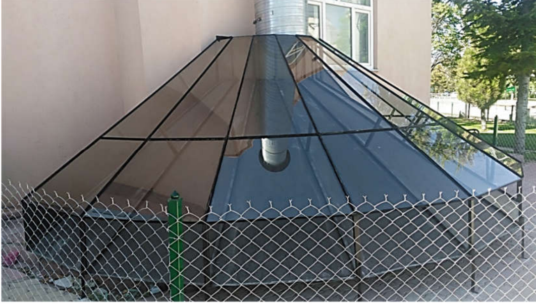
Şekil 3.16. Camların Montajı Sonrası Kollektörün Görünümü
