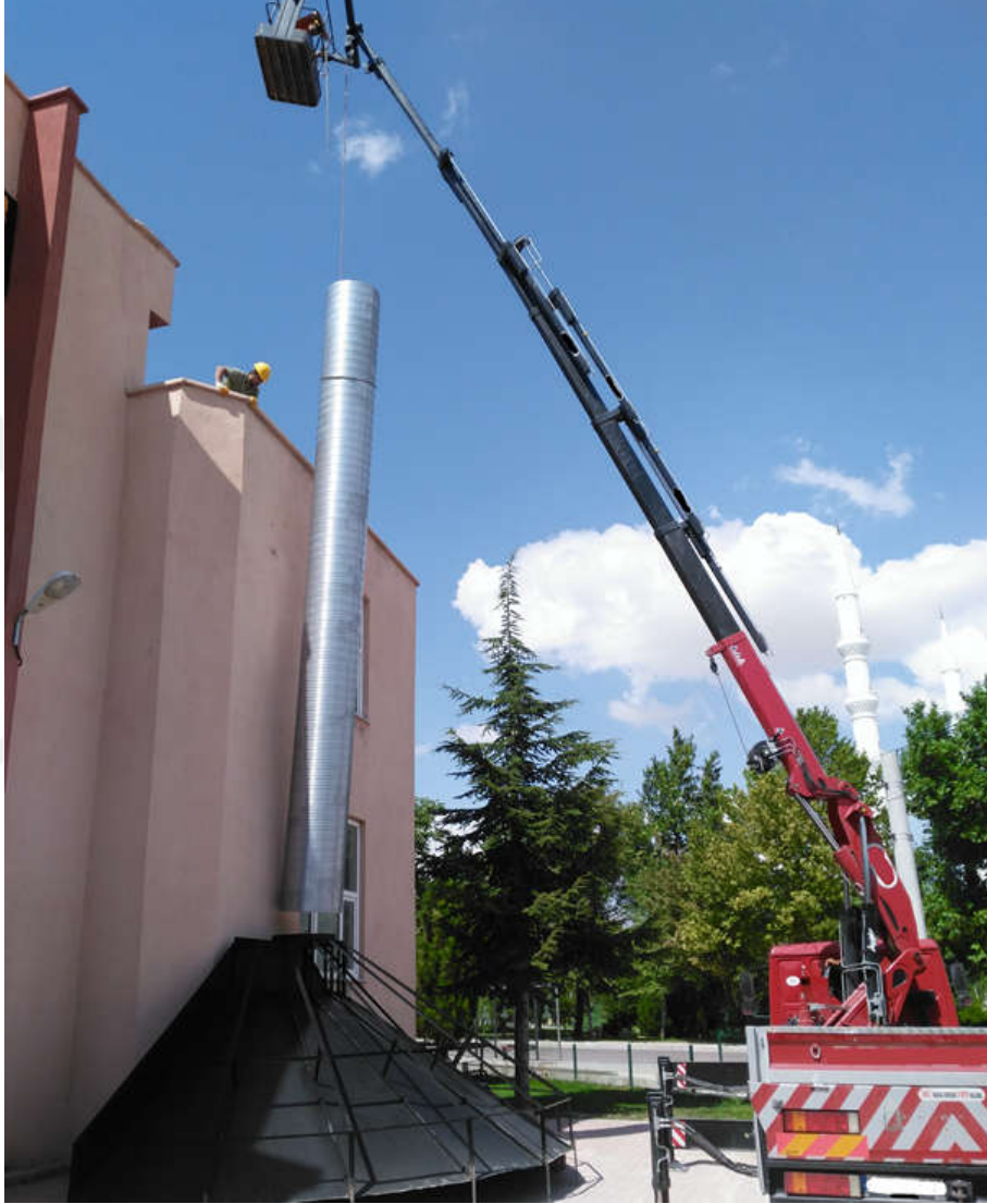
Şekil 3.14. Bacanın Montajı
