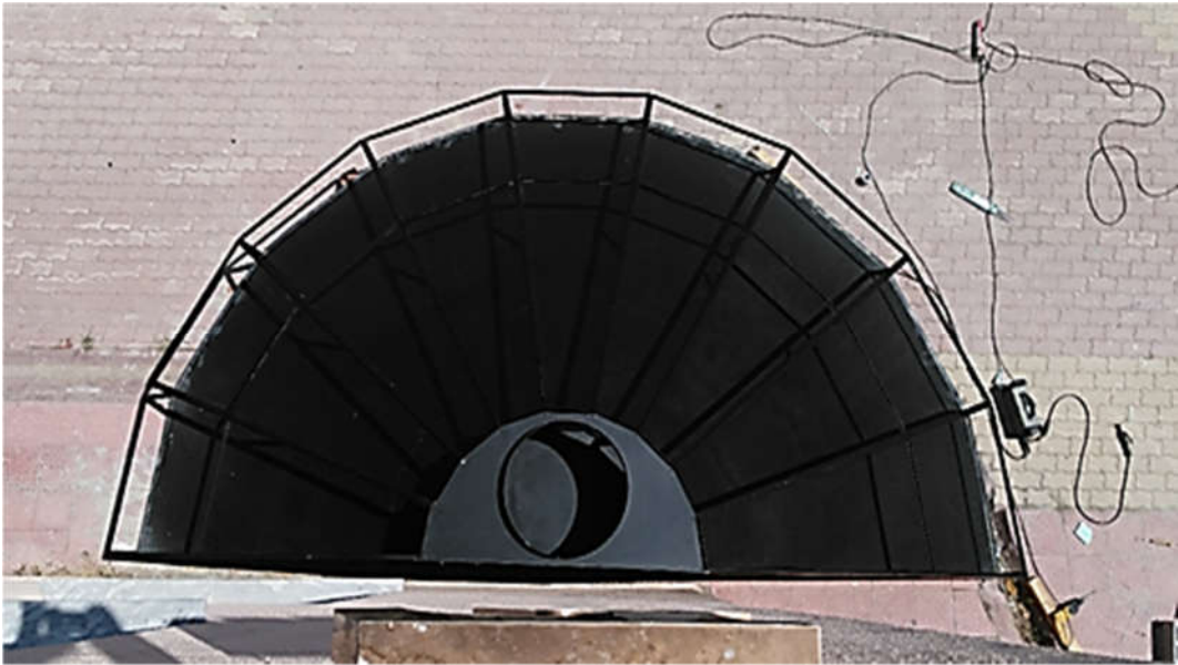
Şekil 3.13. Montajı Tamamlanan Kollektörün Üstten Görünümü
