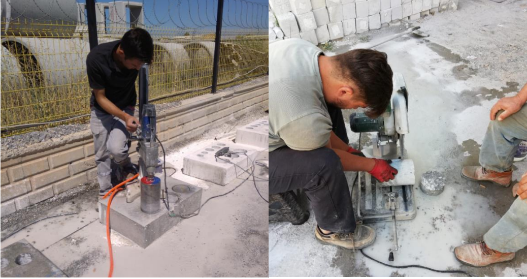
Şekil 4.16. Beton bloklardan karot alınması ve alınan karot numunelerinin kesilmesi
