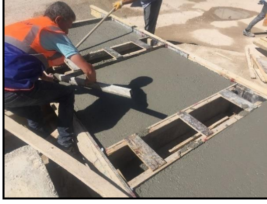
Şekil 5. 8. Beton yüzeyine master uygulaması
