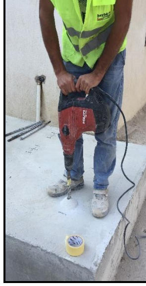
Şekil 5. 14. Ankraj deliklerinin hazırlanması
