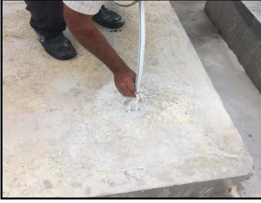
Şekil 5. 16. Ankraj deliklerinin su ile temizlenmesi
