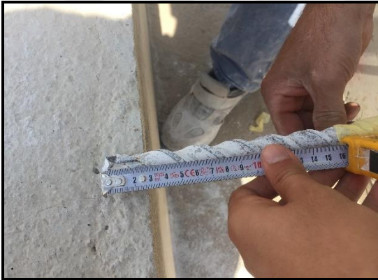
Şekil 5. 13. Ankraj derinliklerinin matkap ucu üzerinde işaretlenmesi
