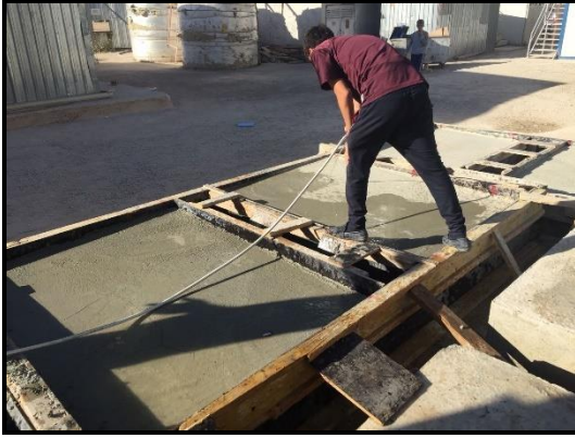
Şekil 5. 9. Dökülen betonlarda kür uygulaması
