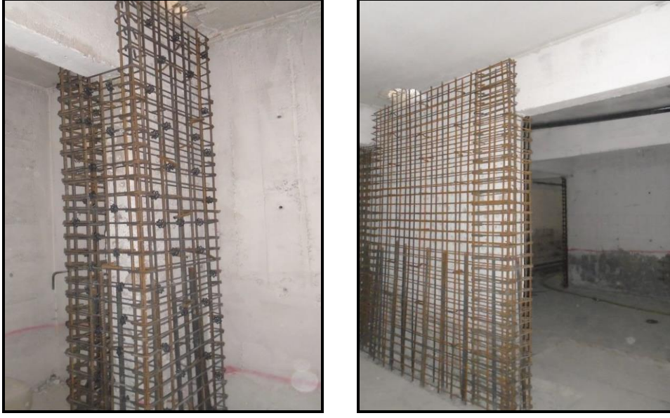
Şekil 1.1. Mevcut taşıyıcı elemanda kesit genişletilmesi
