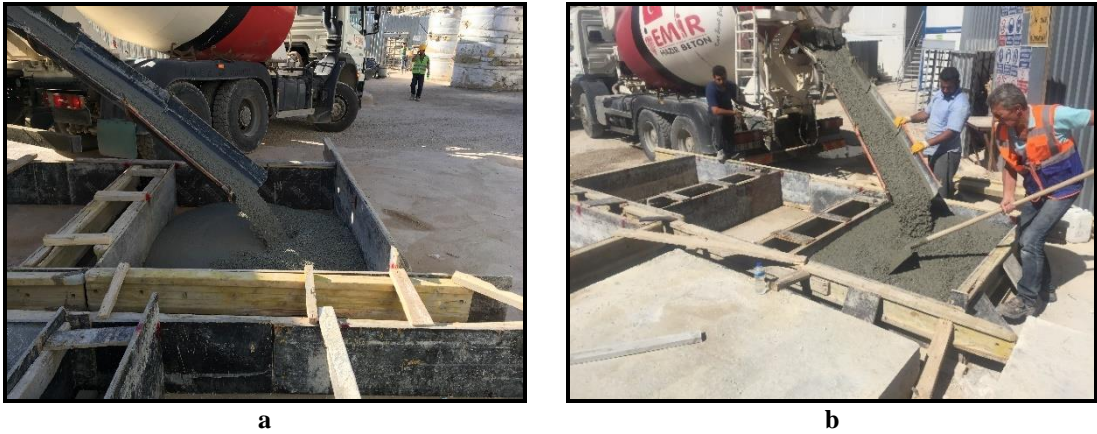
Şekil 5. 7. a, b: C10 beton dökümü, C30 beton dökümü
