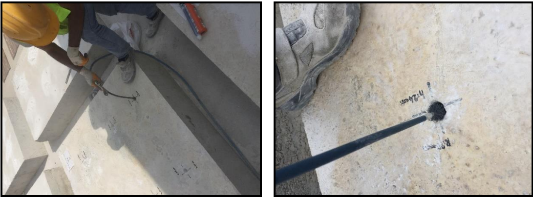
Şekil 5. 15. Ankraj deliklerinin hava ile temizlenmesi
