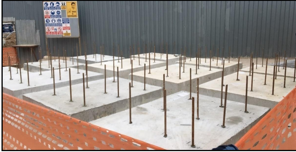
Şekil 5. 18. a1, a2, b: Ankrāj donatılarının ekilmesi, Ekilen donatıların genel görünümü
