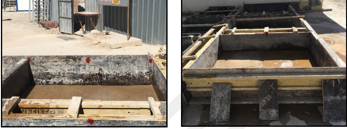
Şekil 5. 6. Beton üst kotunun belirlenmesi ve kalıpların temizliği
