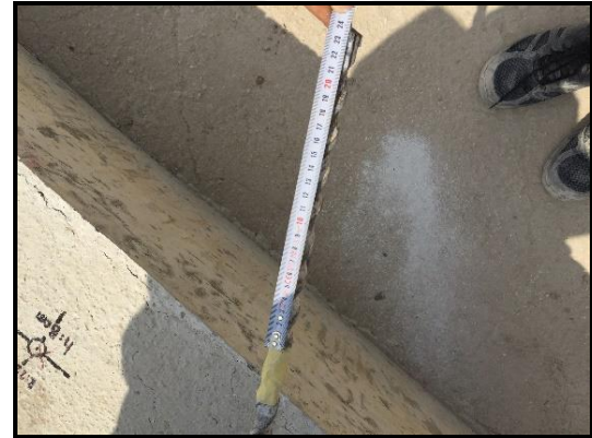
Şekil 5. 13. Ankraj derinliklerinin matkap ucu üzerinde işaretlenmesi
