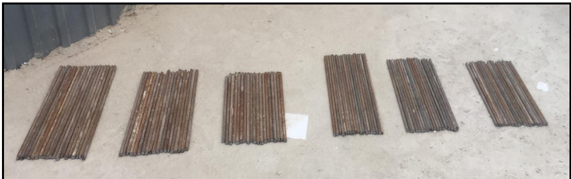
Şekil 5. 3. Hazırlanan ankraj donatıları
