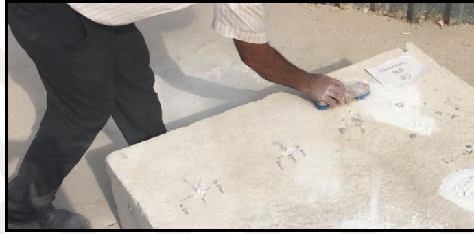
Şekil 5. 17. Temizlenmemiş numunelerde ankraj deliklerin etrafındaki tozun temizlenmesi
