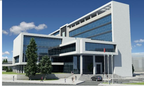
Resim 17 Manisa Belediye Binası 2011, Erhun Uğur, Manisa
