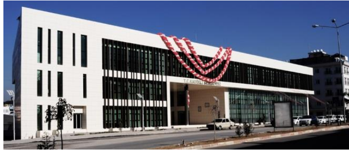
Şekil 2. 20. Kadırlı Belediyesi Hizmet Binası (2009 yılında yarışmayla yapılan Kadırlı Belediye Hizmet Binası cephne Resimleri ve Kat planı) (Url-19).
