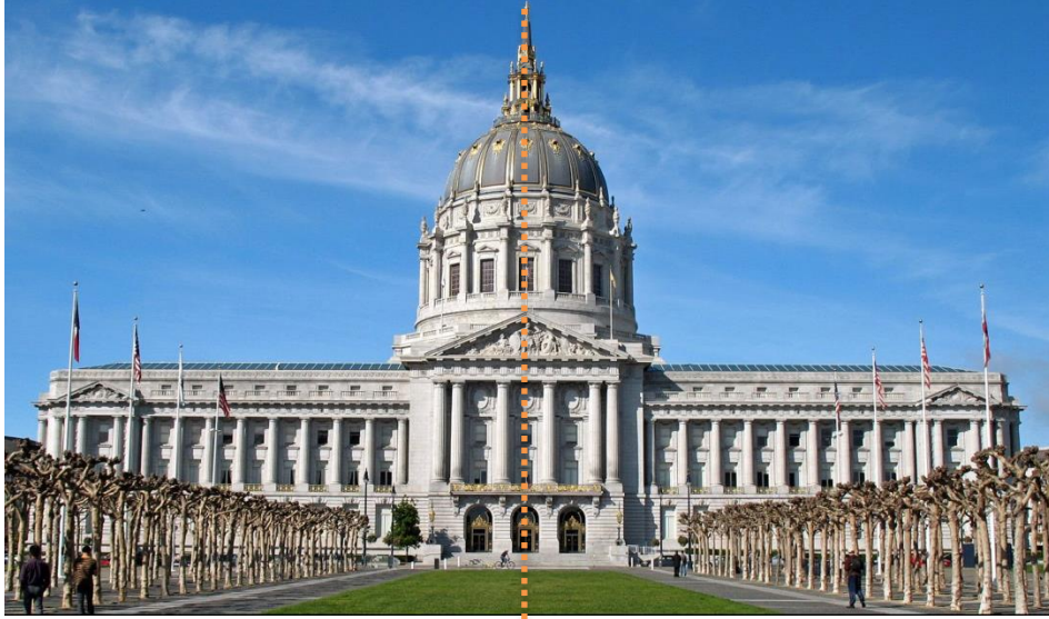
Şekil 2. 14. San Francisco Belediye Hizmet Binası (Url-13)
