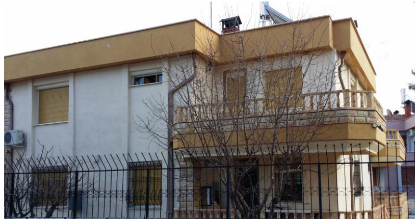
Şekil 4.23. Akif Şenyıl Evi doğu cephesi (Doğan, 2019)
