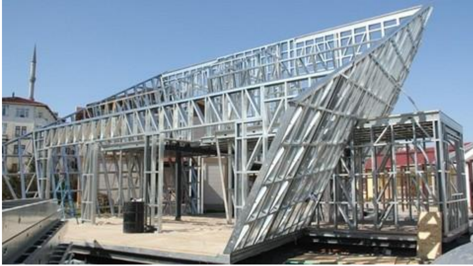
Şekil 2.12. Çelik Konstrüksiyon Yapı, (www.yapi.com.tr, 2018)
