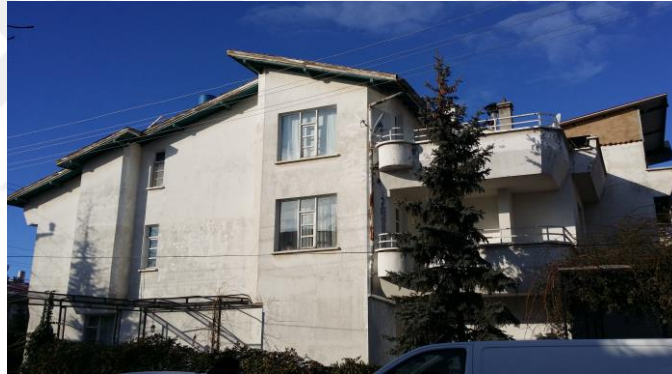
Şekil 4.9. S.S. Sedefköy Villa Yapı Kooperatifi güneydoğu cephesi (Doğan, 2019)
