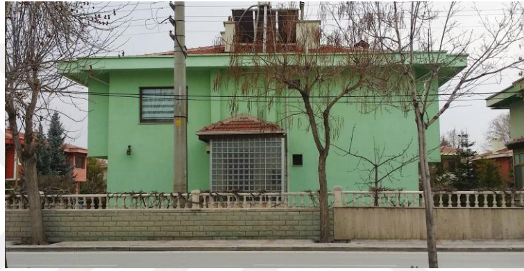
Şekil 4.11. S.S. Irmak Konut Yapı Kooperatifi Batı cephesi (Doğan, 2018)
