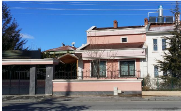
Şekil 4.20. Ali Tetikçok Evi güney cephesi (Doğan, 2019)
