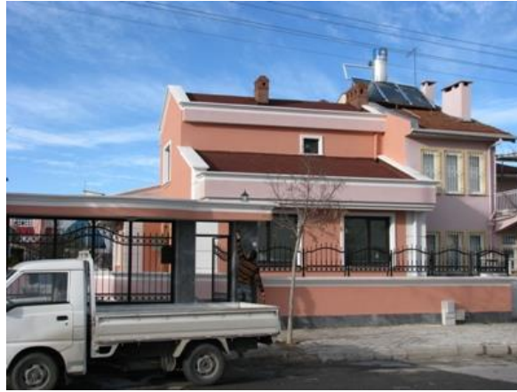
Şekil 4.21. Ali Tetikçok Evi güneybatı cephesi (www.kentrehberi.konya.bel.tr, 2018)
