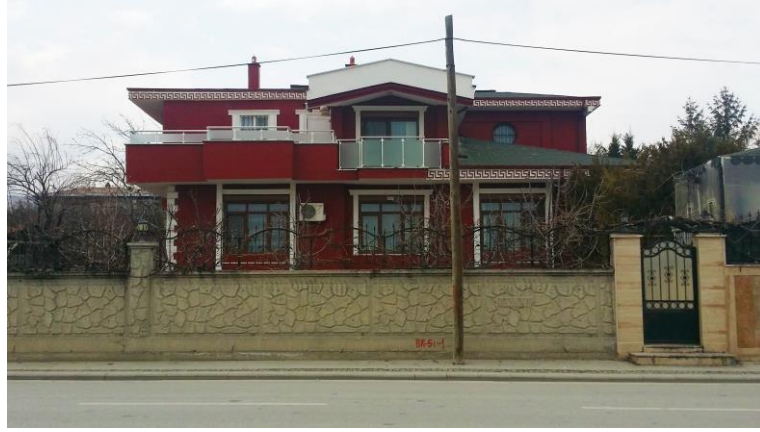
Şekil 4.31. Kübra Ergün Evi güneydoğu cephesi (Doğan, 2019)
