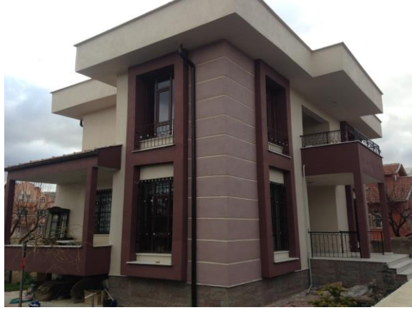
Şekil 4.19. Nuran Bağcı Evi güney cephesi (Ceran Yapı Denetim, 2014)
