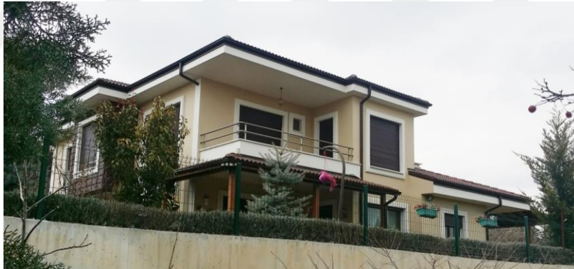
Şekil 4.37. Nejdet Güz Evi doğu cephesi (Doğan, 2019)
