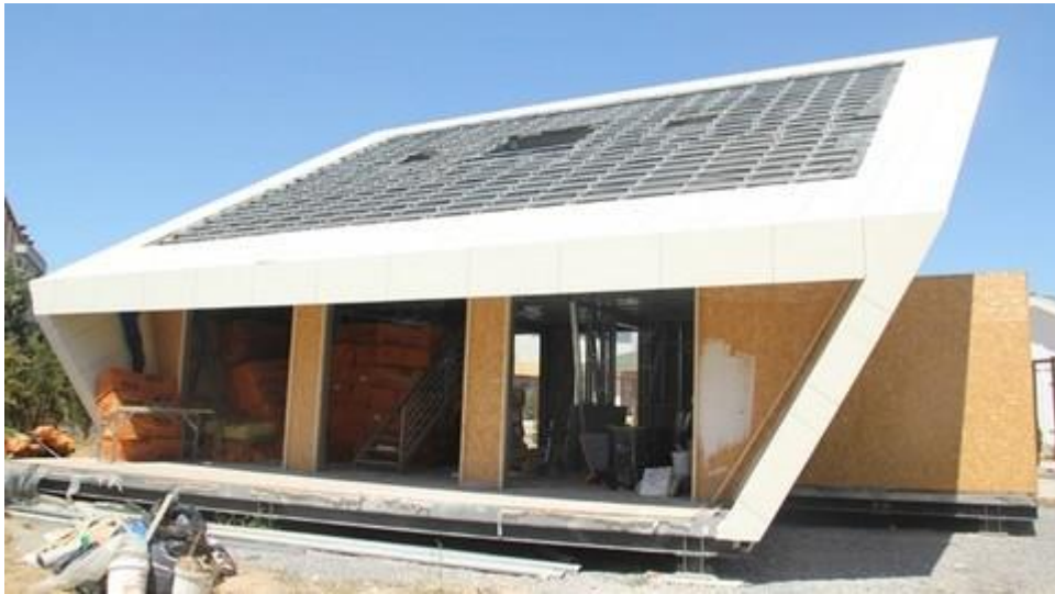
Şekil 2.13. Üst örtü üzerinde fotovoltaik paneller kullanılmış konut yapısı, (www.yapi.com.tr, 2018)
