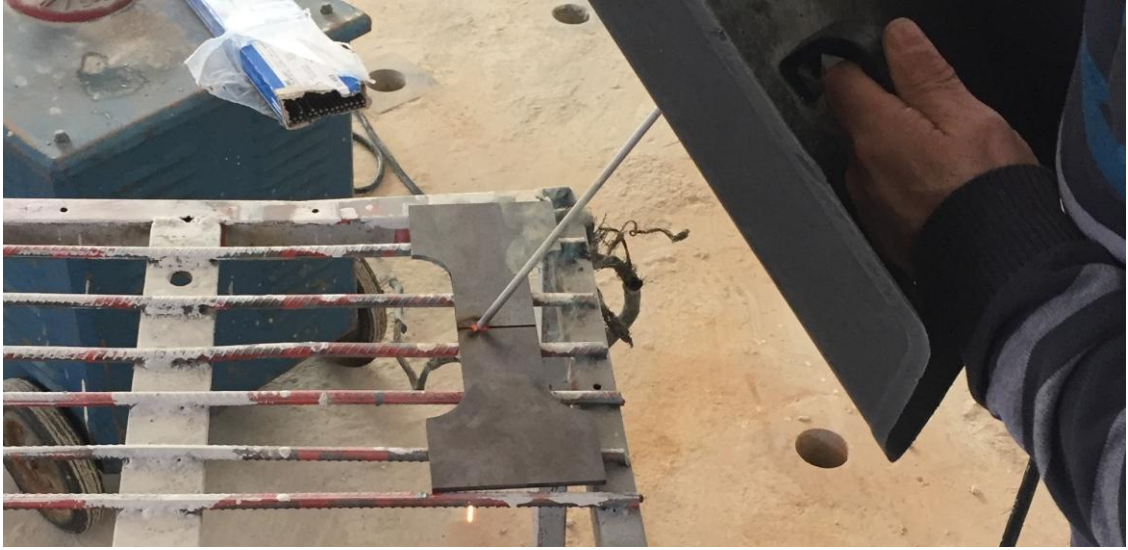
Şekil 4.8. Küt kaynak uygulama işlemi
