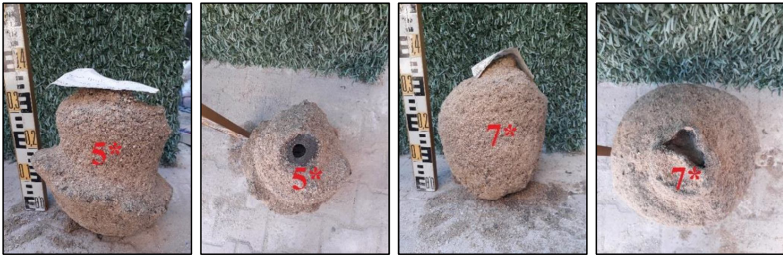
Şekil 4.5. 5 ve 7 nolu kolonlarda hatalı ve hatasız oluşan kolonlar
