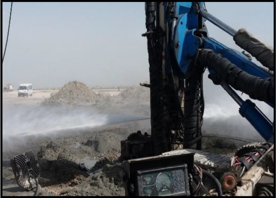
Şekil 3.5. Enjeksiyon uygulamasında nozûlden su çıkışı
