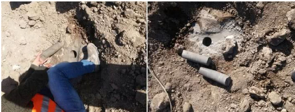
Şekil 3.15 Arazide Jet Grout Kolonundan Karot Numune Alınması ( https://www.insaatofis.com/jet-grouting-jet-grout-imalati-asamalari.html )
