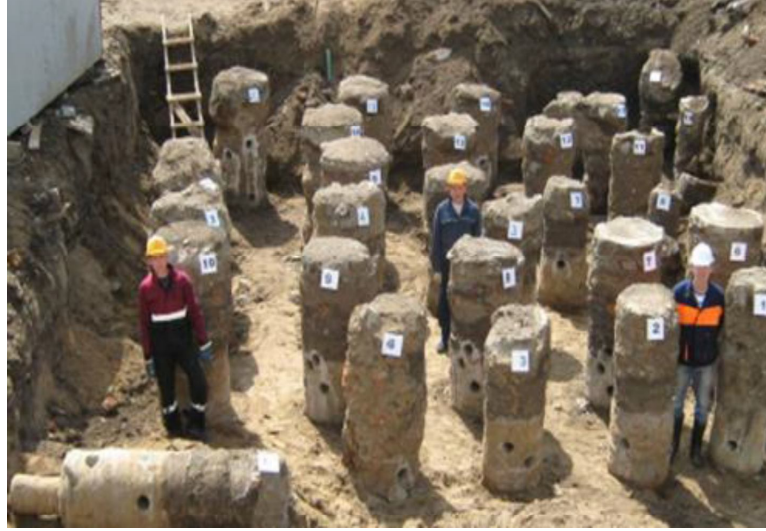
Şekil 3.17. Jet grout kolonlarından alınan karot numuneleri (Kimpritis,2013)
