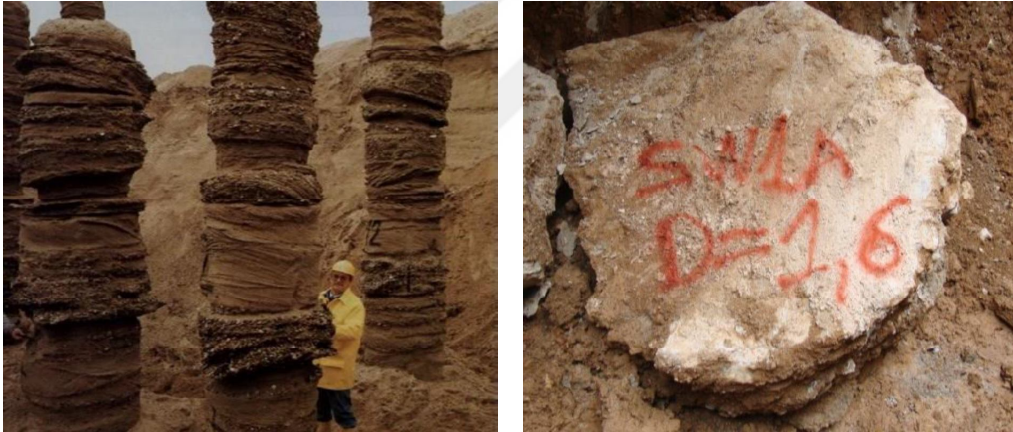
Şekil 3.16. Jet grout kolonların çap kontrolü (Kimpritis,2013)
