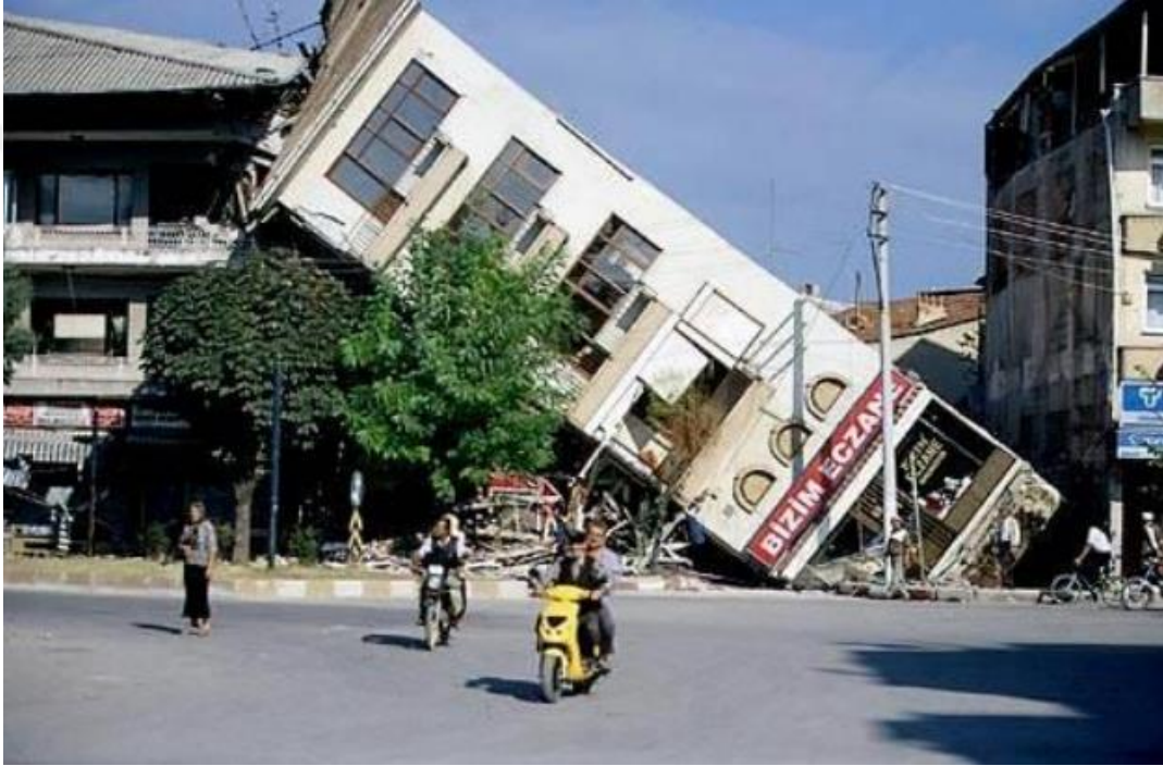
Şekil 3.7.17 Ağustos 1999 Depreminde görülen zemin sıvılaşması (Web iletisi 4)
