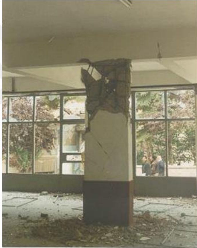
Şekil 3.6.Kolonda basınç kırılması (Web iletisi 4)
