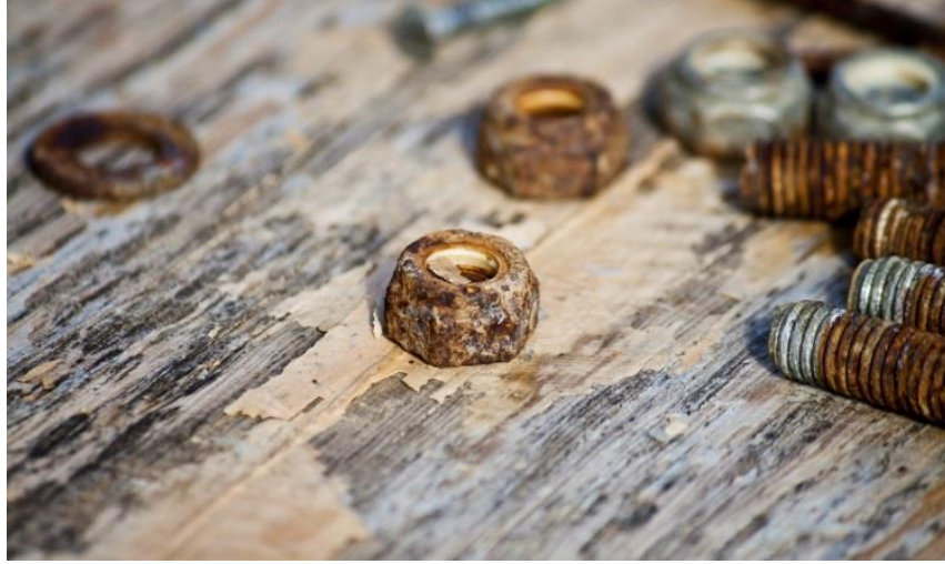
Şekil 1.31. Vidada oluşan aralık korozyonu
