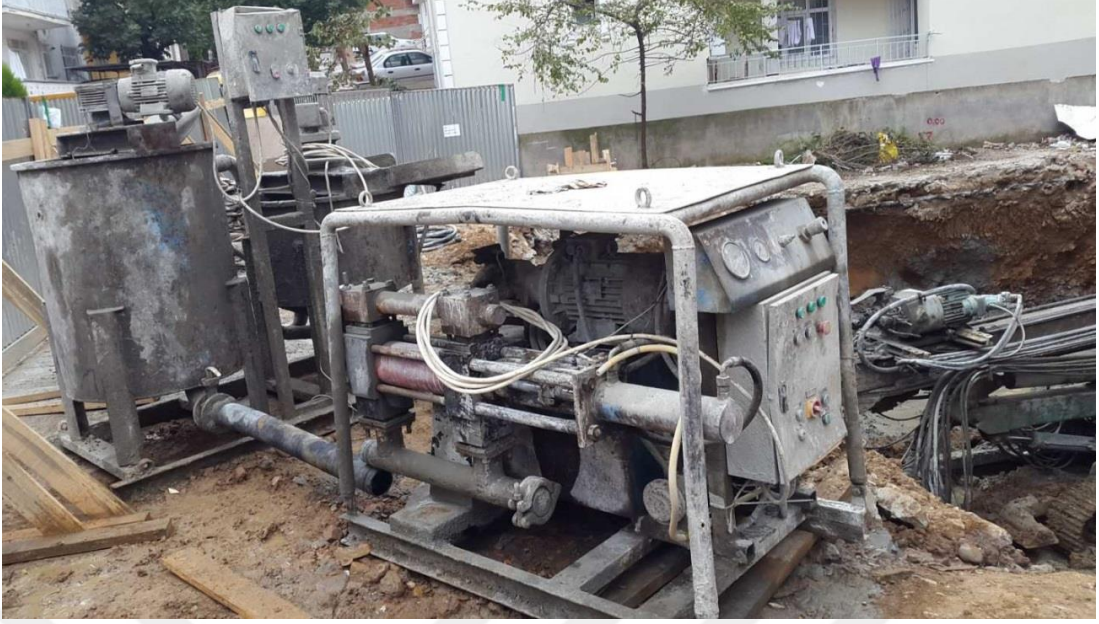
Şekil 2.6. Yüksek basınçlı enjeksiyon pompası (zeminarastirma-url)
