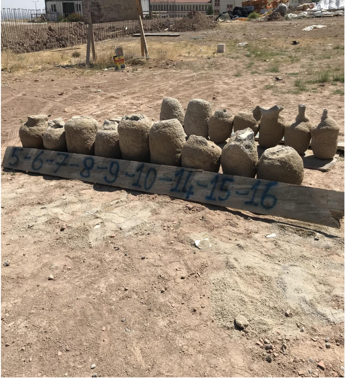
Şekil 4.5. Jet grout kolonlarının görünümü (5-6-7-8-9-10-11-12-13-14-15-16 nolu)
