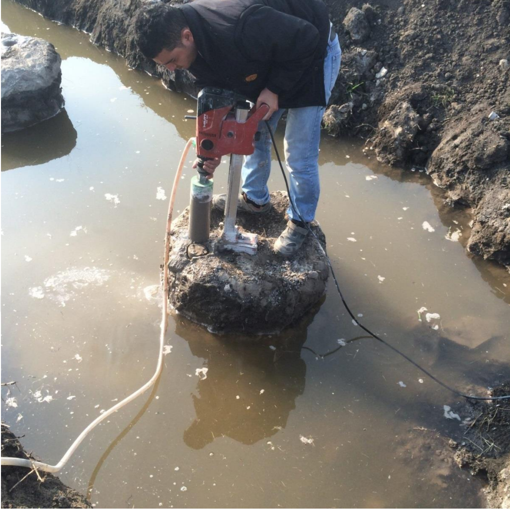
Şekil 2.31. Jet grout kolonundan karot alımı (cantem-url)
