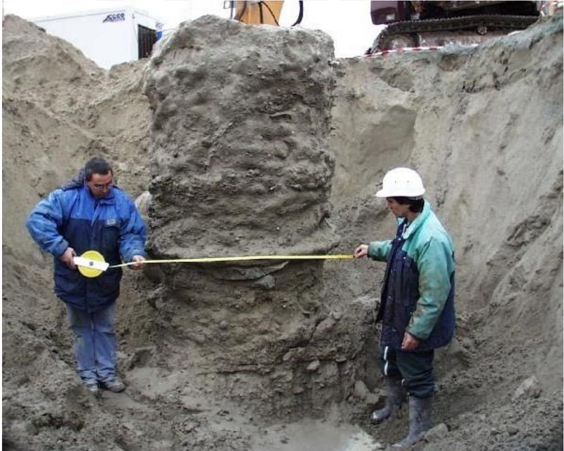
Şekil 2.28. Jet grout kolon boyut ölçümü (geozerezmin-ur1)
