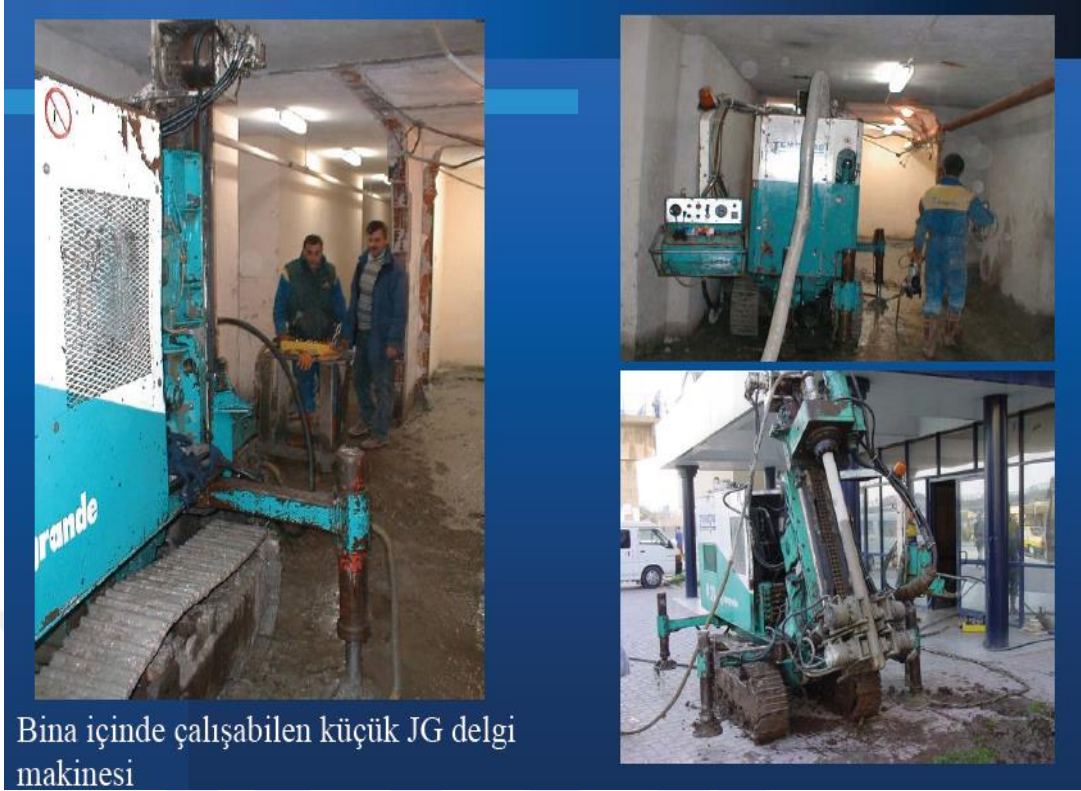
Şekil 2.21. Kedaş Genel Müdürlük Binası İzmit bina içinden temel takviyesinde kullanımı
