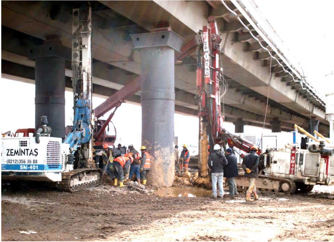
Şekil 2.16. Bogenbay Köprüsü, köprü ayağı iyileştirme (zakladini-url)
