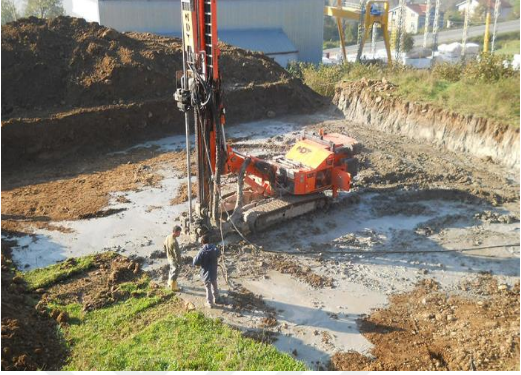
Şekil 2.11. Ereğli Turckel Santral Binası temel zemini iyileştirilmesinde kullanımı (geodata-url)
