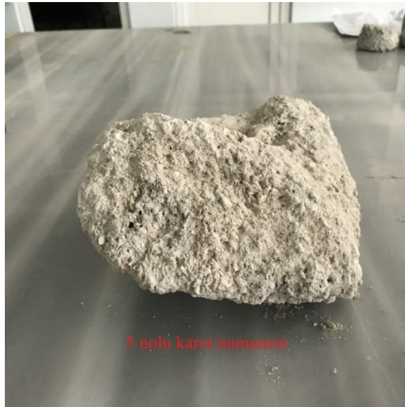
Şekil 4.58. 5 nolu kolon karot görünümü
