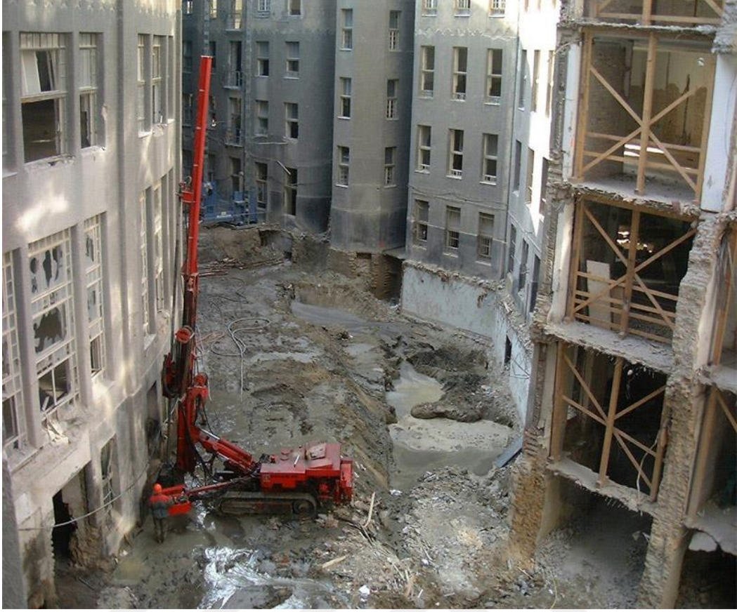
Şekil 2.15. Komşu bina temeli desteklenmesinde kullanımı (zakladini-url)
