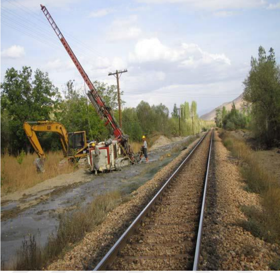
Şekil 2.13. Ulukışla-Gümüş Hattı Demiryolu zemin iyileştirilmesinde kullanımı
