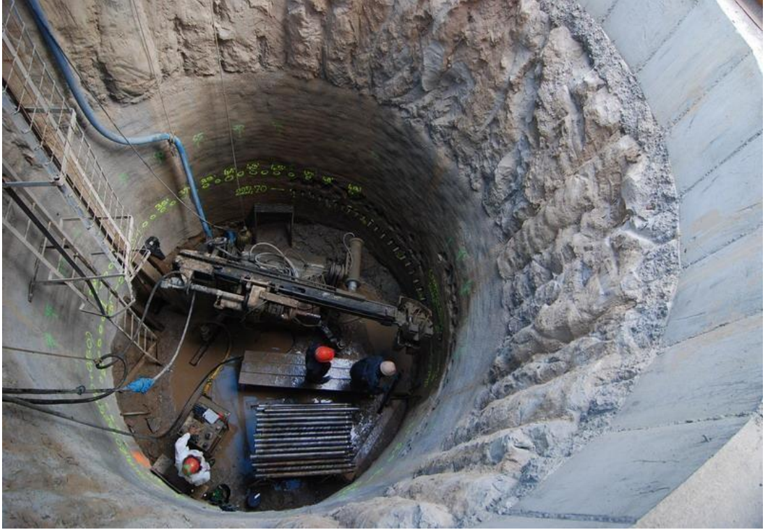
Şekil 2.20. Şaft kazılarında kullanımı (zakladini-url)
