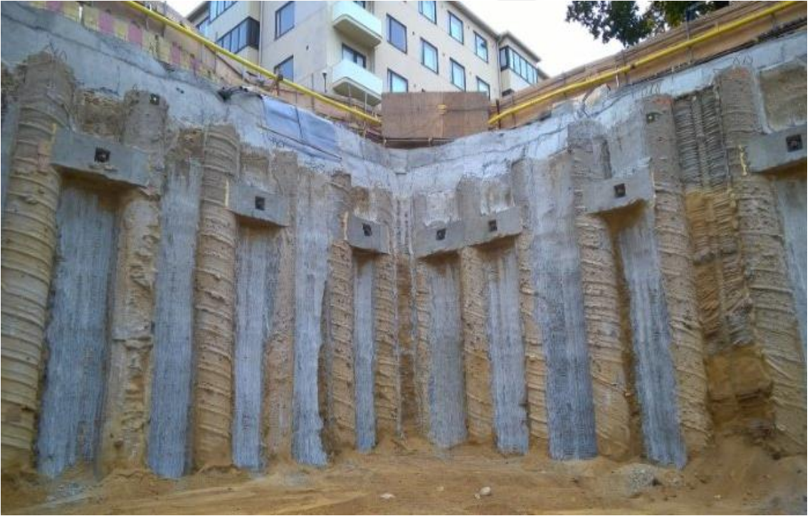
Şekil 2.12. Kazı yüzeyinin desteklenmesi ve iksa sisteminde kullanılması
