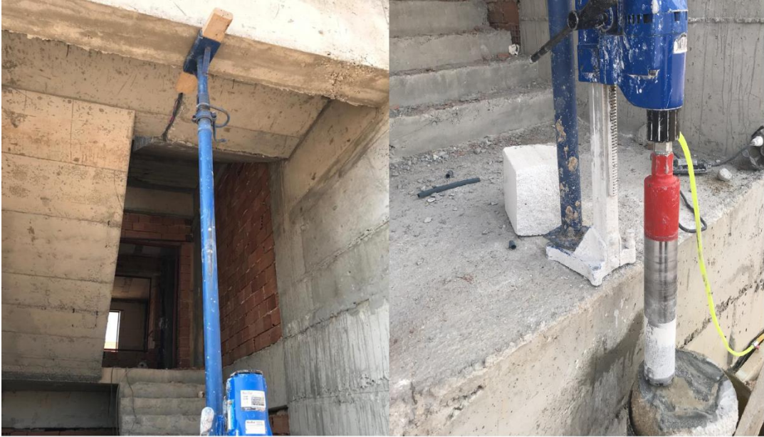
Şekil 4.28. Karot delgi makinasının sabitlenmesi
