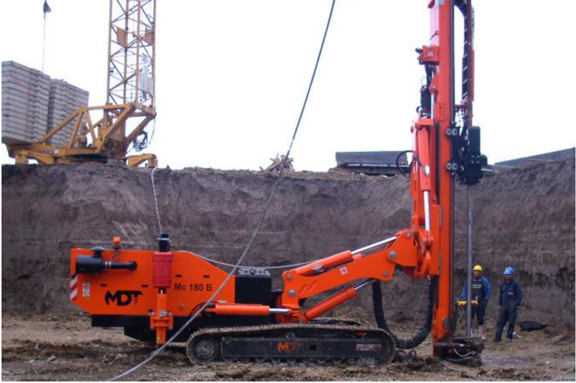
Şekil 2.5. Delgi makinası (AG Zemin İnşaat)
