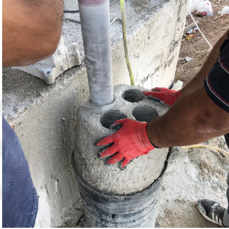
Şekil 4.29. Kolonlardan karot alma işlemi
