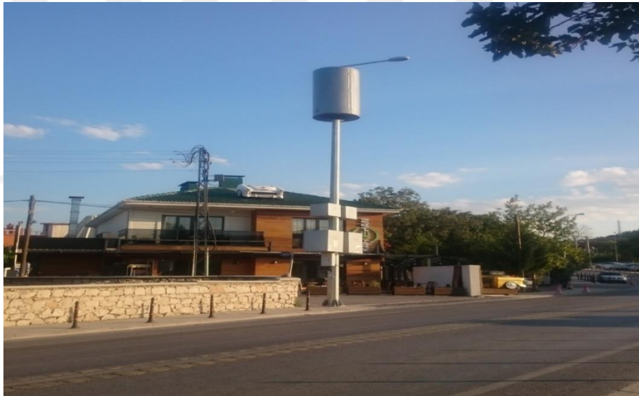
Şekil 7.16 Aydınlatma Direği Görünümü Verilmiş Bir Baz İstasyonu Görüntüsü
