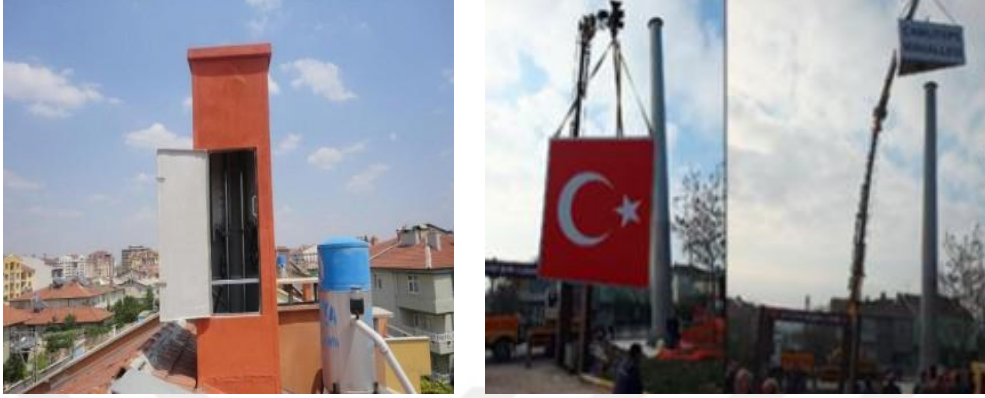
Şekil 7.17 Baca ve Türk bayrağı görünümü verilmiş baz istasyonlarının görüntüleri
