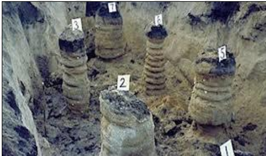
Şekil.3.19 Jet Grout Kolonlorunda Çap Kontrolü
