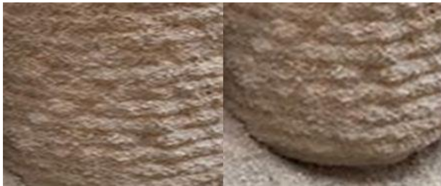
Şekil 4.2 KÇ-SYS (1 Ay) kullanılarak hazırlanan kolonun yüzeyinde oluşan spirallenme
