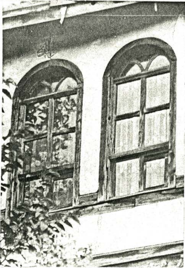
Resim 161. Müftüler Evi pencereleri görünüşü.
