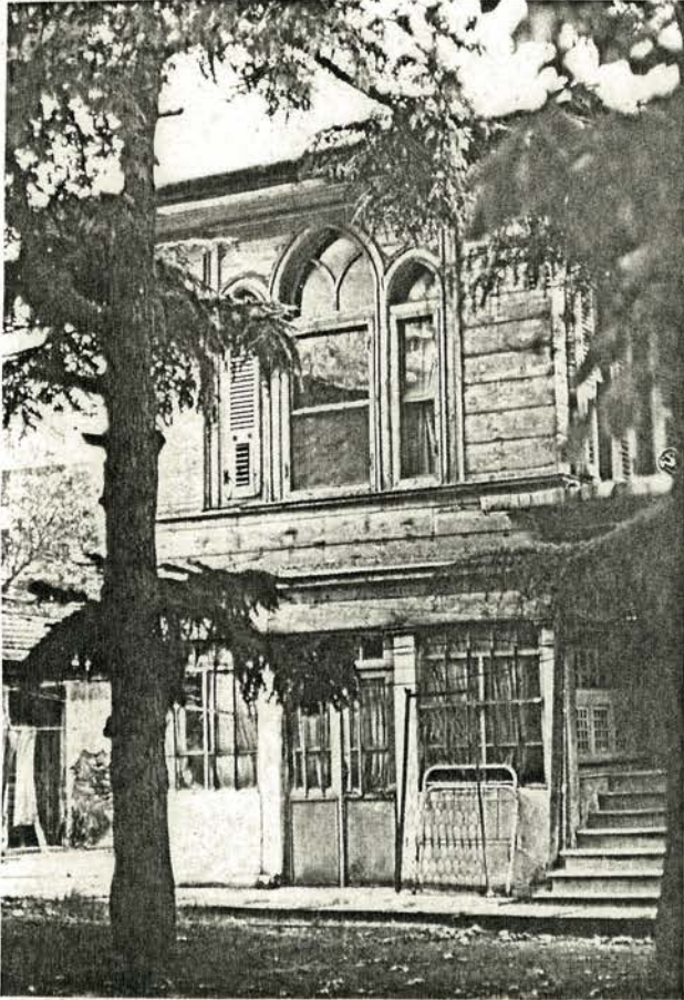
Resim 208. Selamlığın görünüşü ve sol taraftaki girişi.
