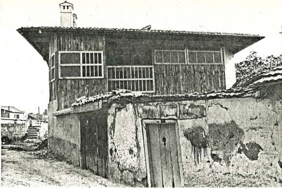
Resim 130. Kütahya, Macar Evi genel görünüşü.
