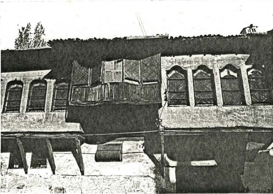
Resim 151. Defterdar Konağı pencereleri
