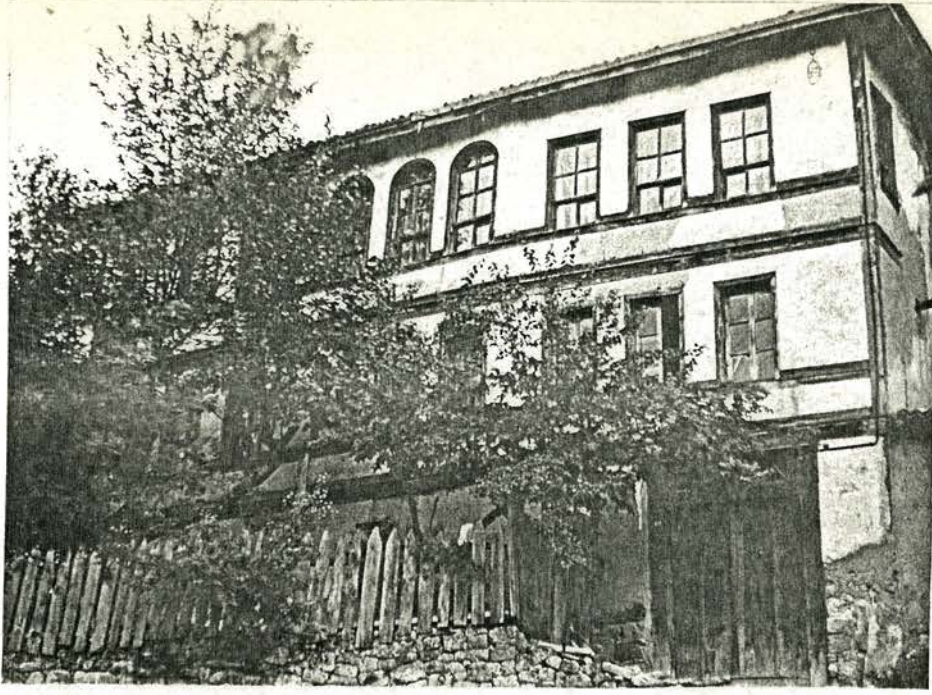
Resim 160. Göynük, Müftüler Evi genel görünüşü.
