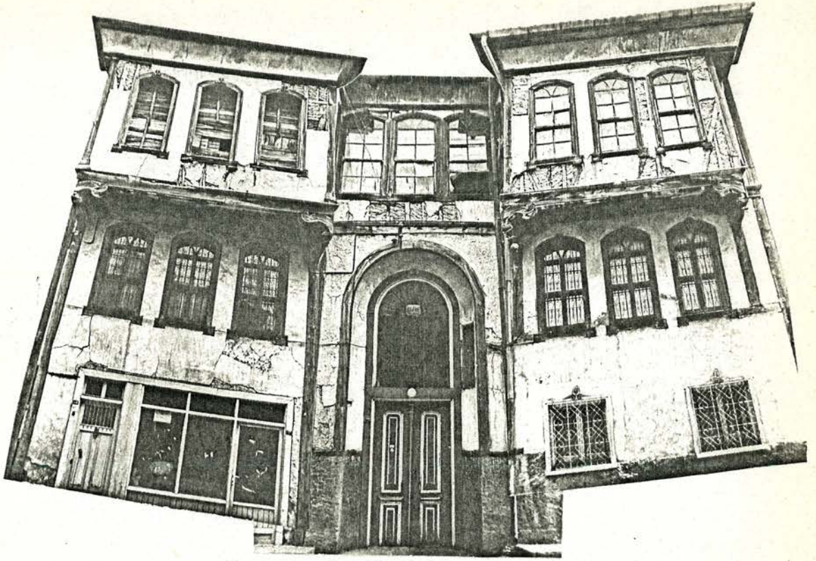
Resim 166. Kütahya Memnut Konağı cephesi genel görünüşü.
