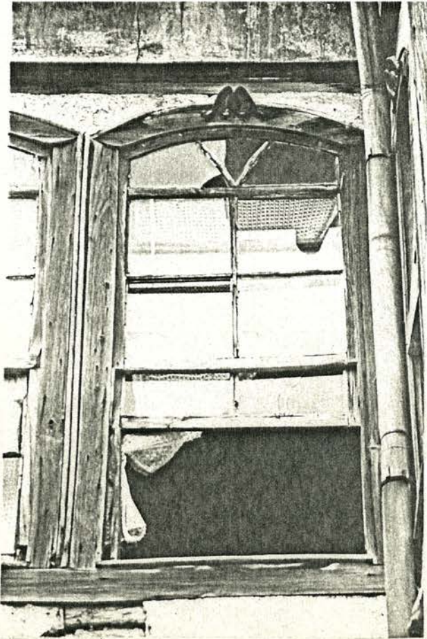
Resim 167. Memnut Konağı sofa penceresi görünüşü.
