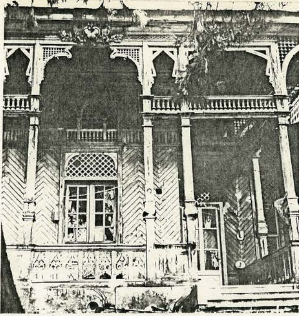
Resim 204. Kütüphane-Müzik Salonu binası penceresi görünüşü.
