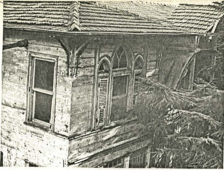
Resim 207. Rıdvan Paşa Köşkü Selamlık Binası görünüşü.
