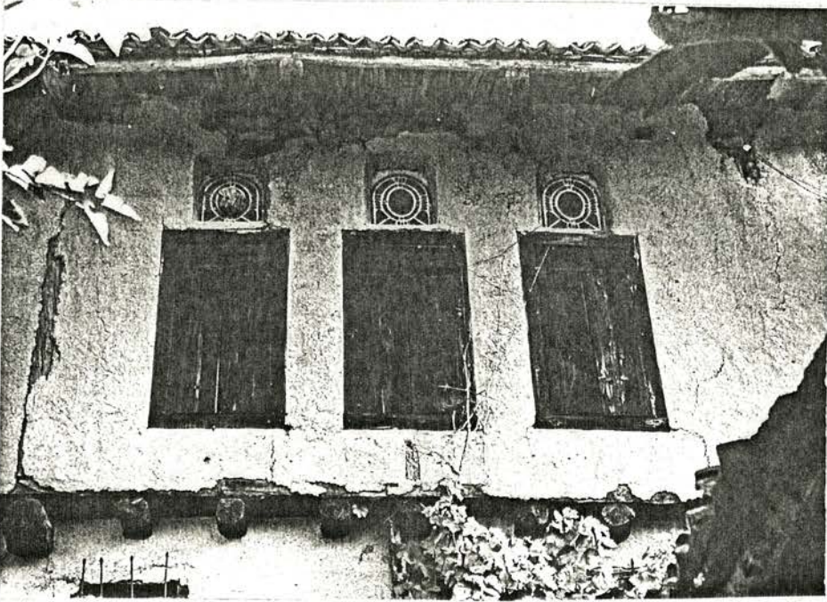
Resim 142. Göynük, Necati Yücel Evi dış görünüşü.
