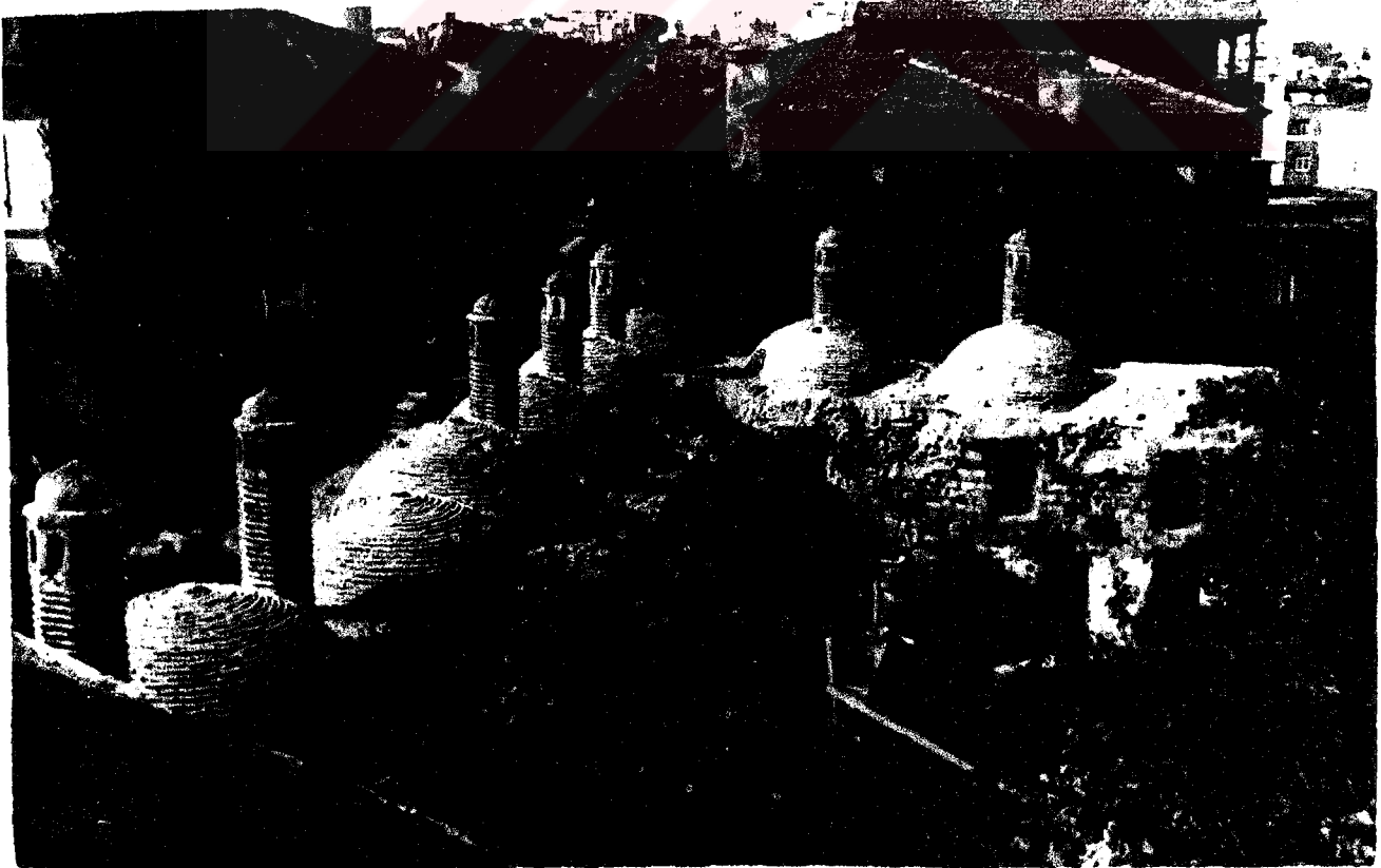
FOTO 54-Ekmekçioglu Ahmet Paşa Külliyesi medrese odaları. Restorasyon sırasında (1968) Kaynak: İstanbul Vakıflar Baş Md.
