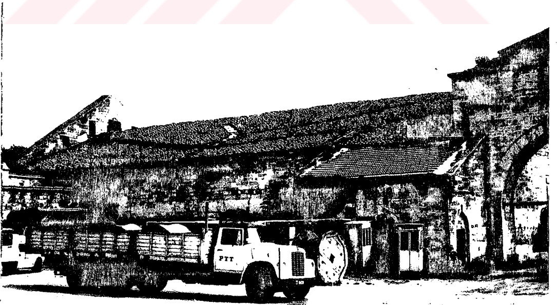
FOTO 96- Ayşekadın Camii minaresinden sol yan görünüş (1986) Muhdes çatı müteahhit Ali Osman Soygel tarafından 1950 senelerinde bu şekle sokulmuştur. Orijinali daha yüksek ve kurşun kaplamadır. 1950 restorasyonu sırasında üçgen alınlığın üzeri koruyucu şap ile kaplanmıştır.
