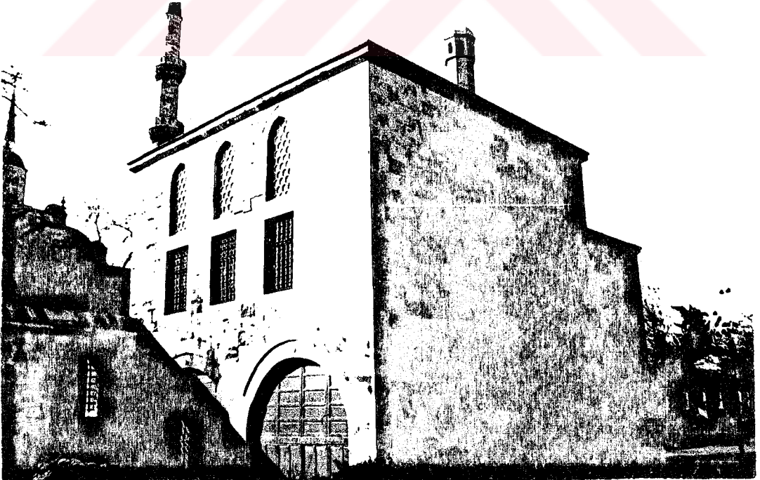
FOTO 46- Sibyan mektebi arka cephe ve yan cephe yapı kalınlığı
