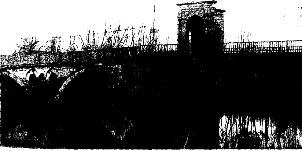
FOTO 109- Ekmekçiogluahmetpaşa kitabe köşkü
