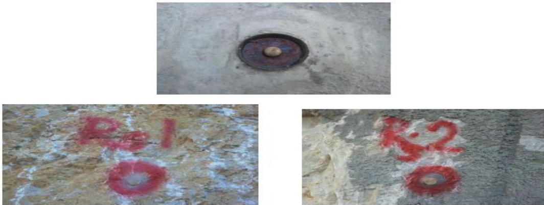
Şekil 6.13. Kret üstünde muhafazalı obje noktası ile yerleşik kayada tesisli R1 ve R2 referans noktaları
