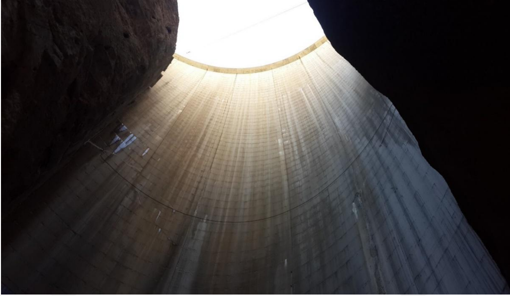
Şekil 6.5. Baraj gövdesi mansap tarafı zeminden görünümü
