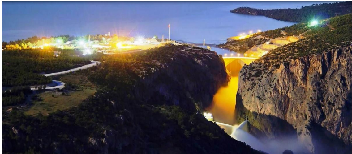
Şekil 6.3. Baraj inşaatı şantiye alanı ve baraj gövdesi genel görünümü
