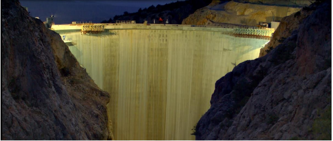
Şekil 6.4. Baraj gövde inşaatının mansap tarafından görünümü
