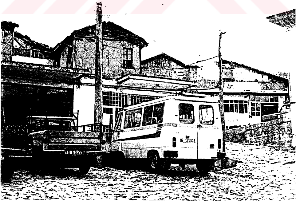
Fotoğraf 60 Caminin karşısında 41 ve 42 no'lu parsele ait yapı
