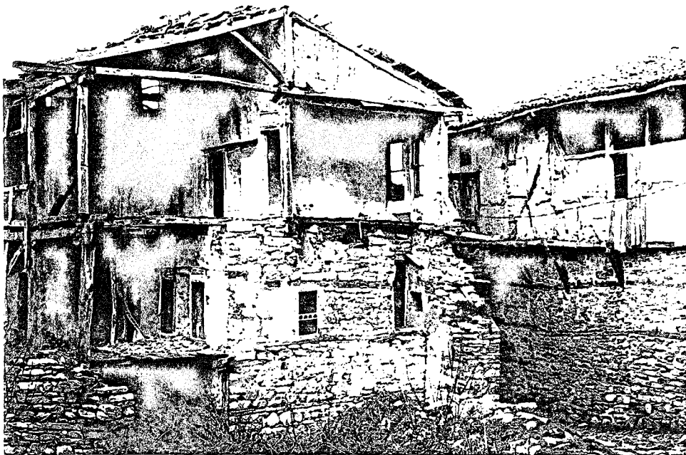
Fotoğraf 48 . Levent Sokağında yıkılmakta olan evin yapı sistemi (95 no'lu parsel)
