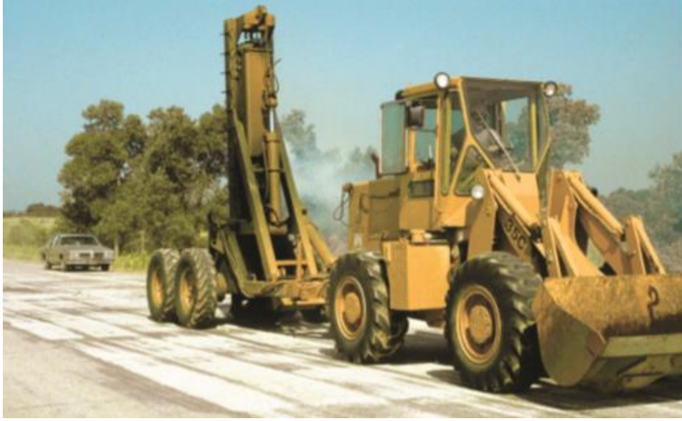
Şekil 1.2. Beton kaplamanın parçalanmasına yarayan darbeli kırıcı (TS043.2P, 2009)
