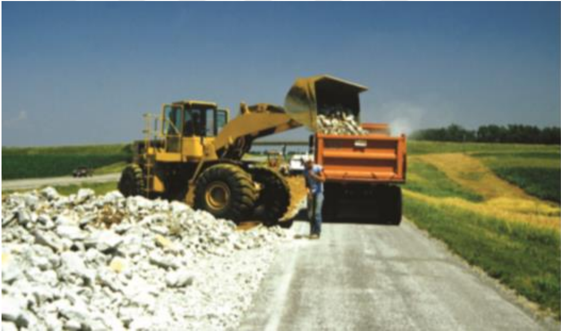
Şekil 1.3. Parçalanmış beton bloklarının kamyonu yüklenmesi (TS043.2P, 2009)
