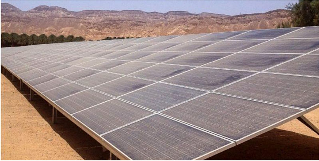
Şekil 3.12. Toza maruz kalmış PV diziler (Anonim, 2019n).
