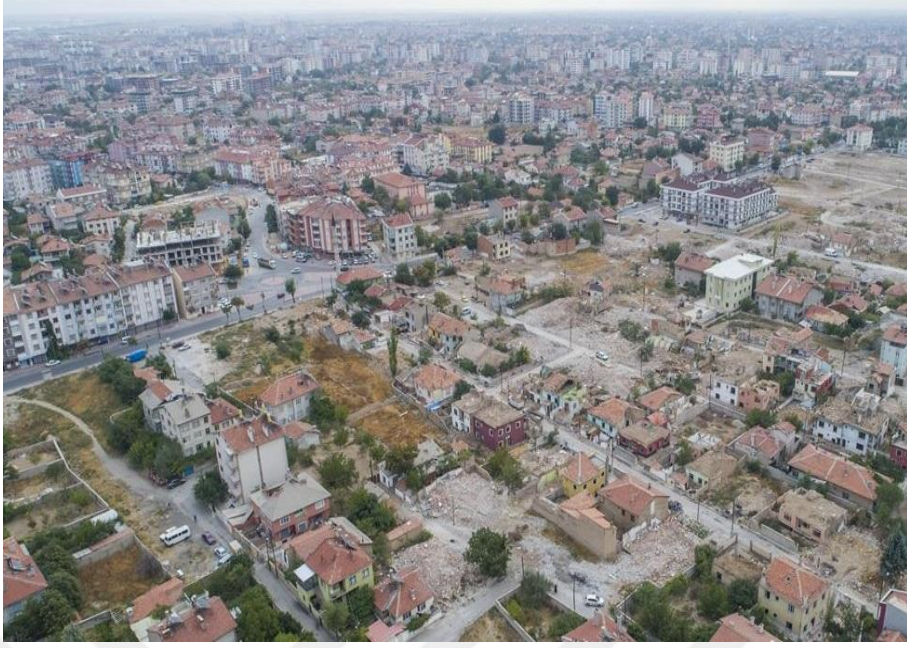
Resim 4.1.Yıkım ve tahliye öncesi kentsel dönüşüm bölgesi
