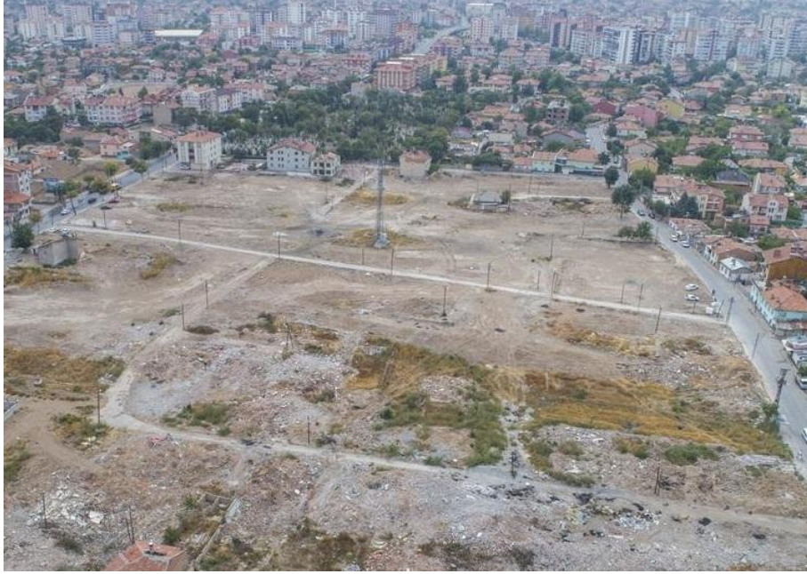
Resim 4.2.Yıkım ve tahliye sonrası kentsel dönüşüm bölgesi
