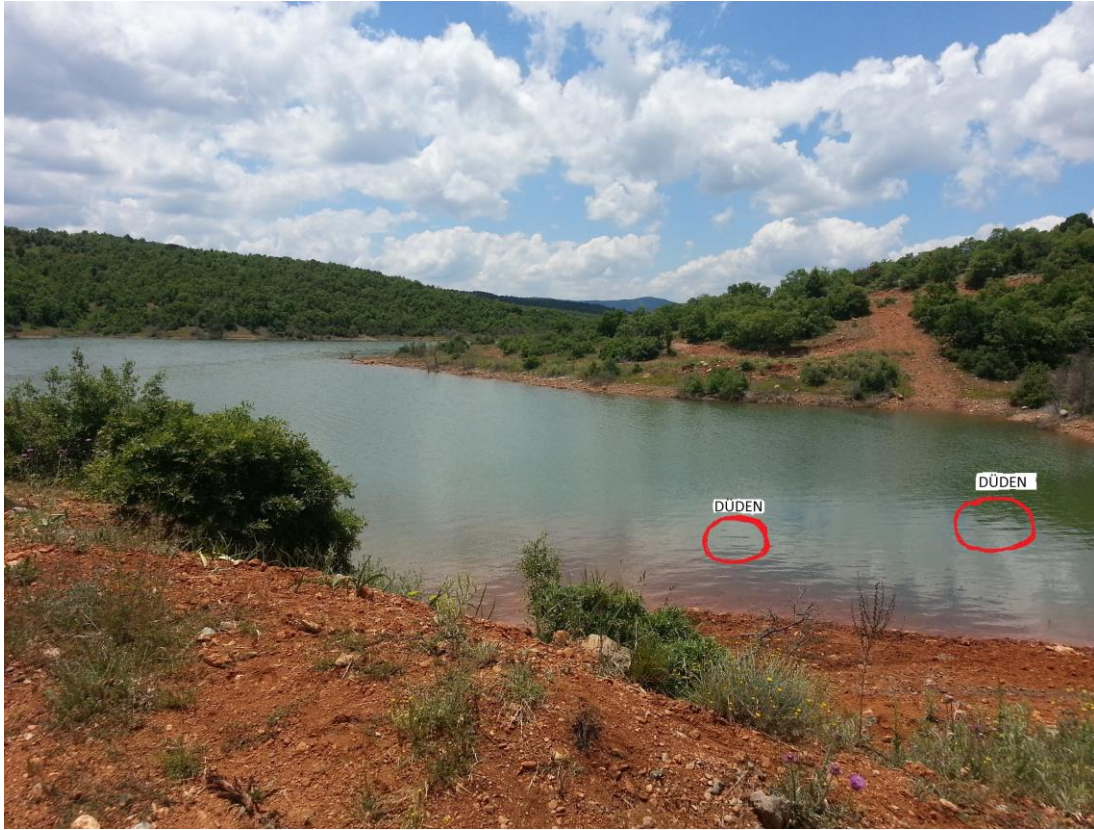
Foto 8.14 Üzümlü sulama göleti su kaçak yerlerinde oluşan düdenler (Nisan-2010)
