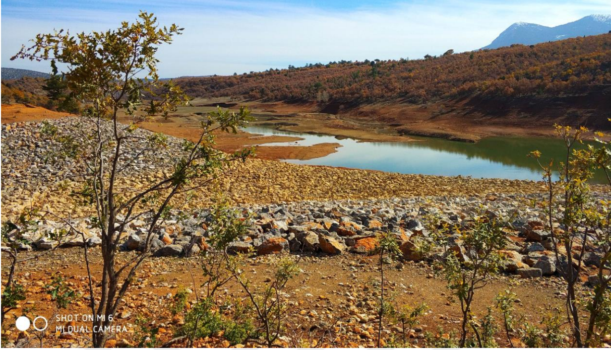
Foto 8.28 Rip-Rap malzeme döşendikten bir yağış mevsimi geçtikten sonraki görünüm
