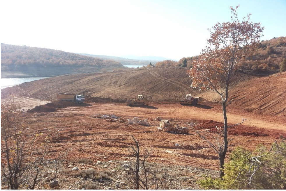
Foto 8.22 Kil serilmesi ve sıkıştırma
