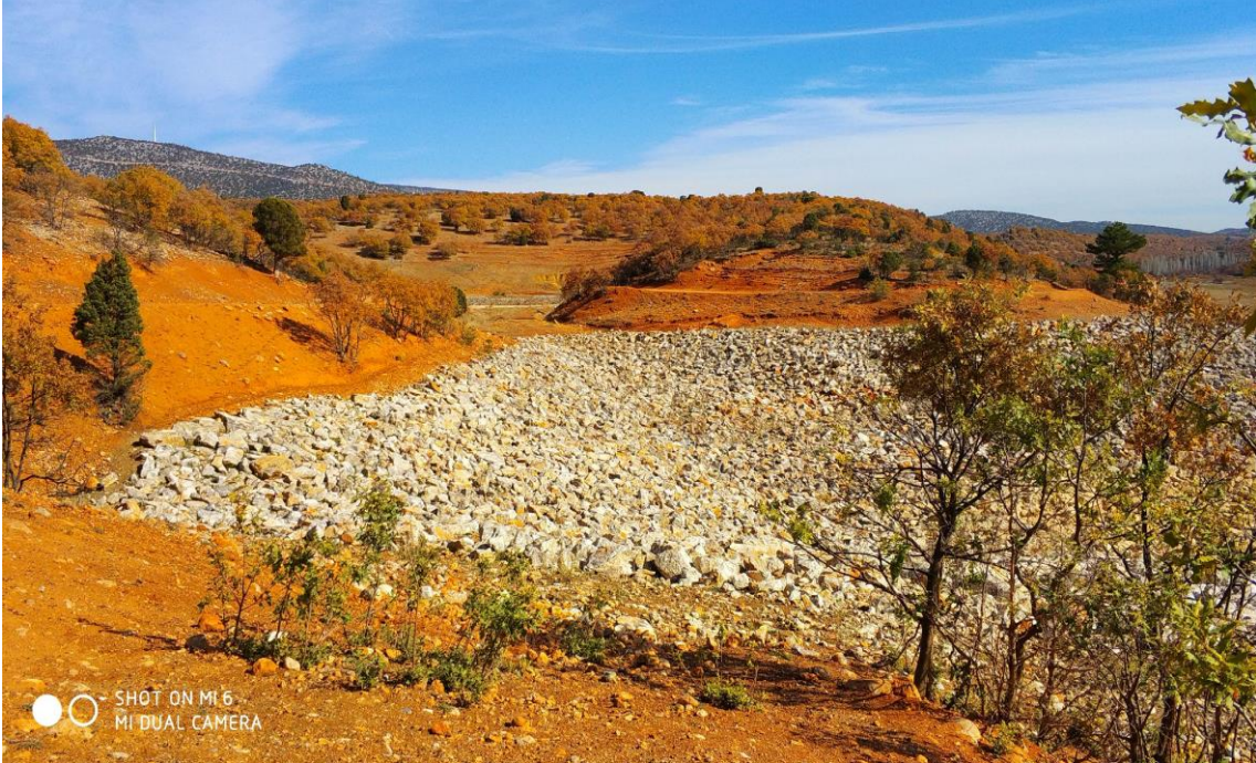
Foto 8.27 Rip-Rap malzemenin döşenmesinden sonraki görünüm
