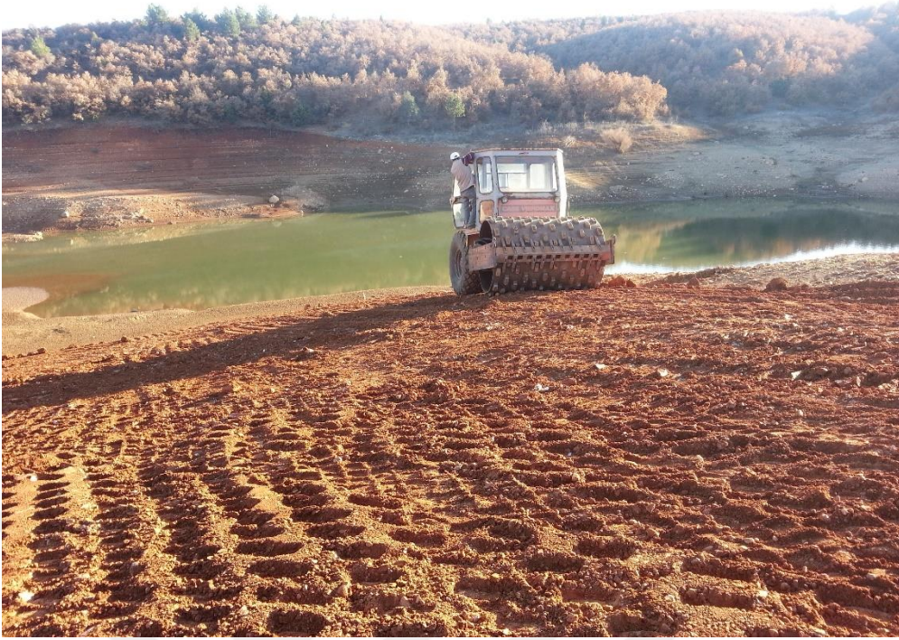
Foto 8.24 Serilen kil malzemenin darbeli silindir (keçi ayağı) ile sıkıştırılması
