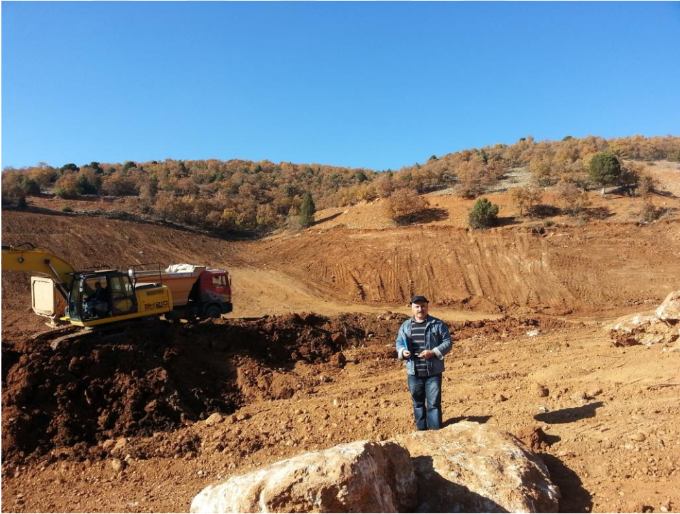
Foto 8.17 Dondurmakuyu vadisinde geçirimli malzemenin sıyrılması
