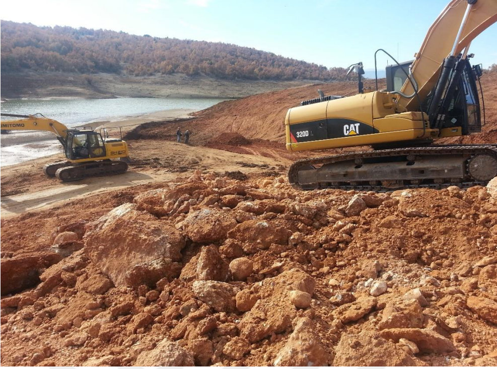
Foto 8.15 Geçirimli malzemenin kırılarak düden bölgesinden uzaklaştırılması
