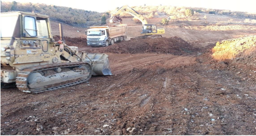
Foto 8.18 Sıyrılan balçık malzemenin taşınması
