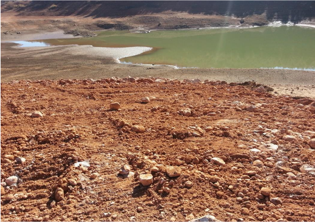
Foto 8.25 Sıkıştırılmış kil üzerine yarı geçirimli malzemenin serilmesi
