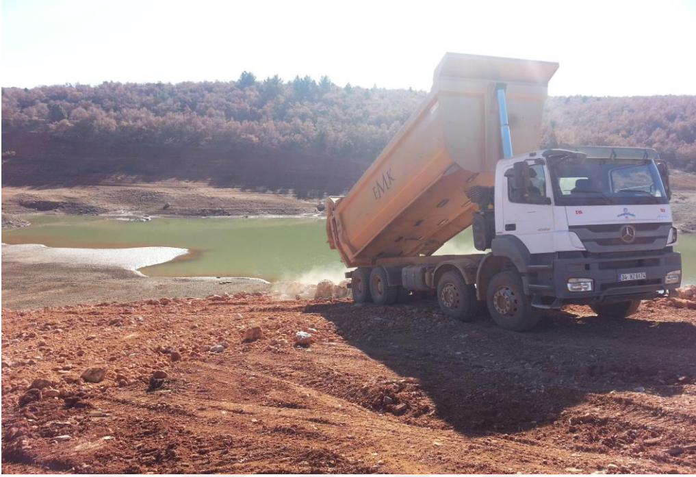
Foto 8.26 Yarı geçirimli malzeme üzerine rip-rap malzeme döşenmesi
