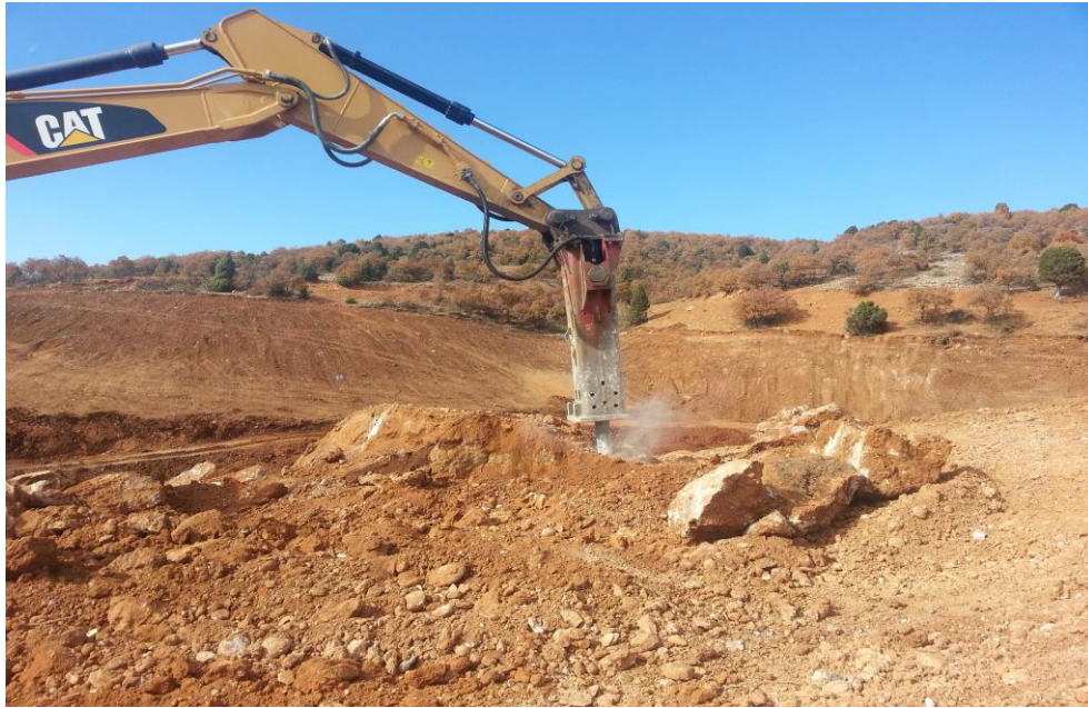
Foto 8.19 Pekişmemiş konglomeratik yapıların kırılarak temizlenmesi
