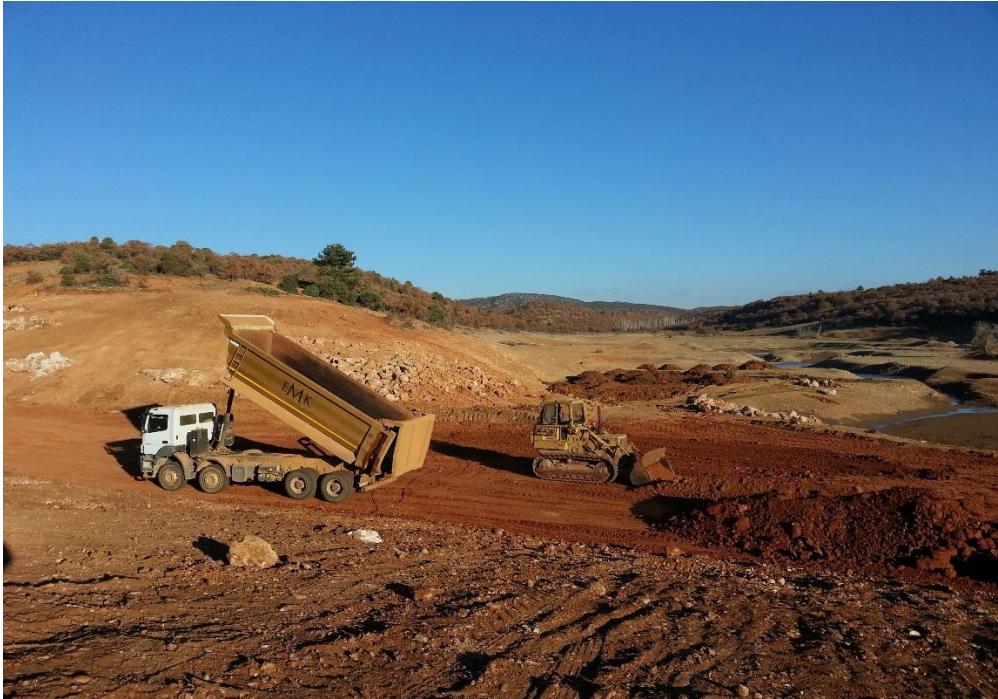
Foto 8.23 Geçirimsiz kil malzemenin serilmesi
