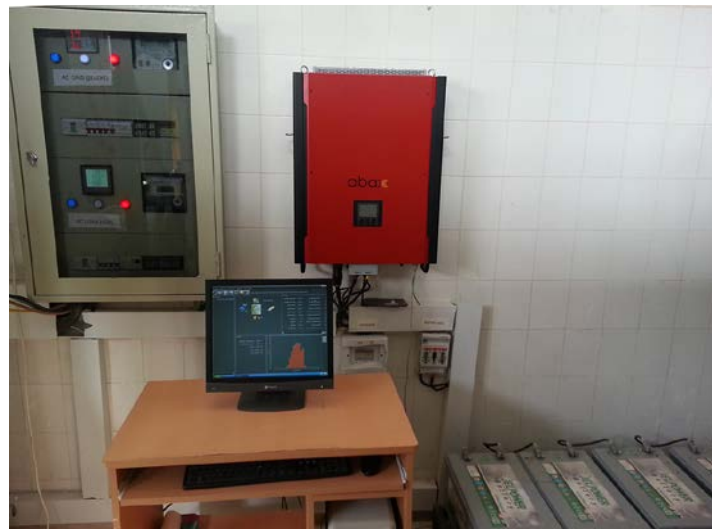
Şekil 5.2. Şebeke bağlantılı fotovoltaik tesisin güç sistem bileşenleri
