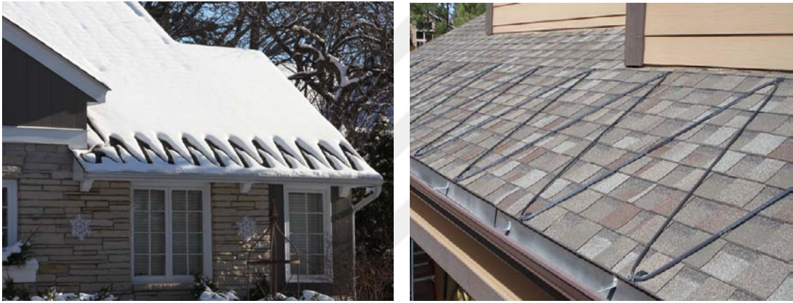
Şekil 4.3. Çatılarda kar ve buzlanmaya karşı ısıtma kabloları 4
