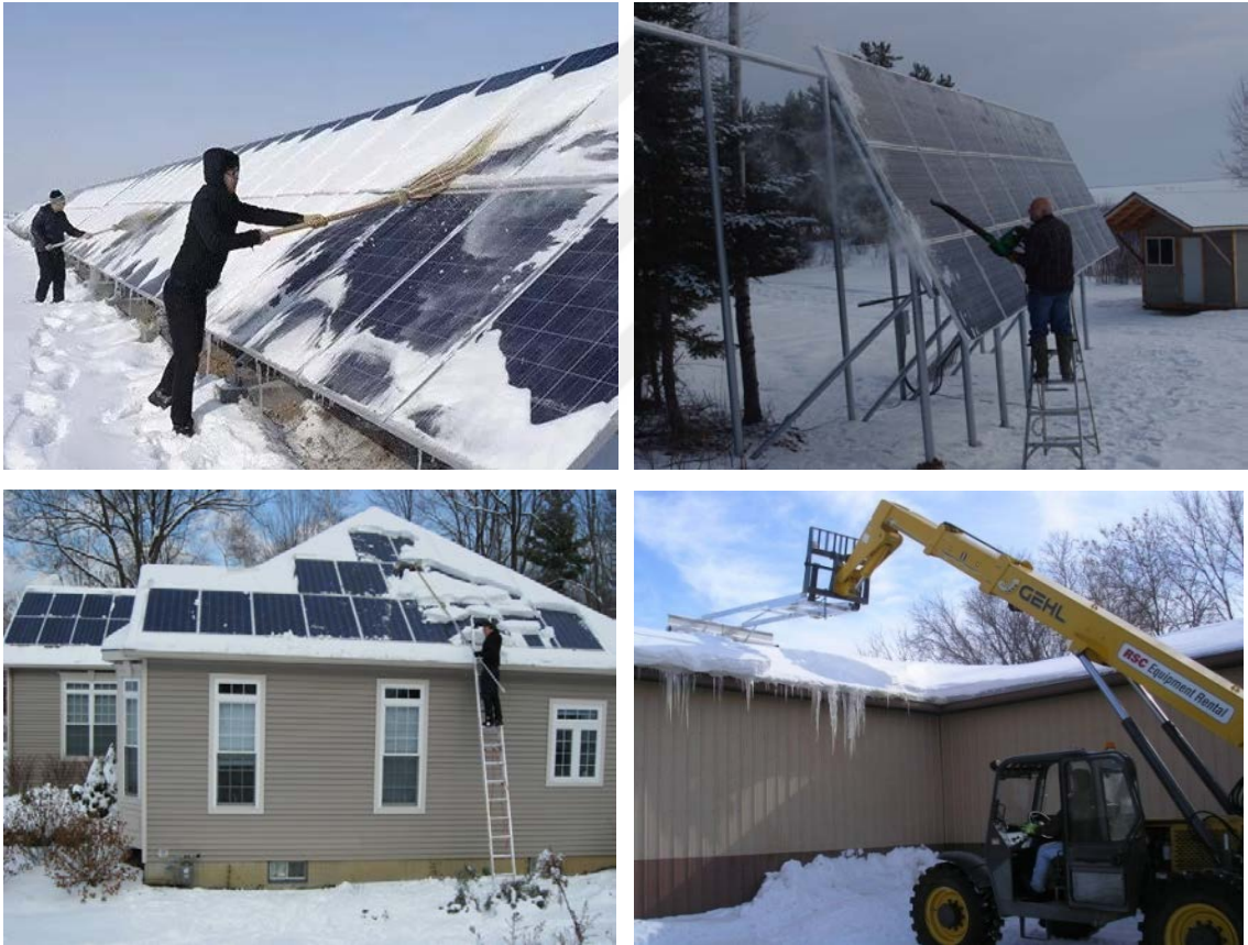
Şekil 4.7. Mekanik ve el ile güneş enerji sistemlerinin temizlenmesine ait örnekler 8
