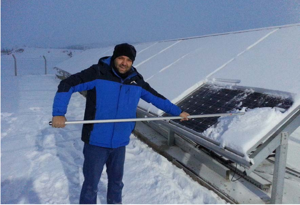
Şekil 5.4. Fotovoltaik dizelerin çek-çek ile temizlenmesi
