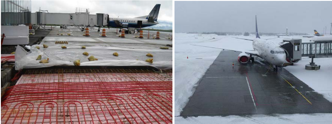
Şekil 4.2. Isıtılmış uçak pisti kaplaması 3
