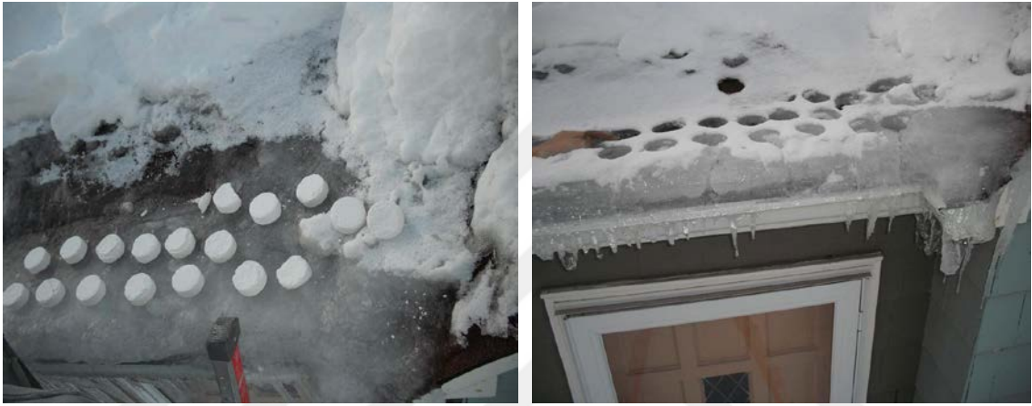
Şekil 4.9. Çatılarda kar ve buzlanmaya karşı tuz tabletleri 10
