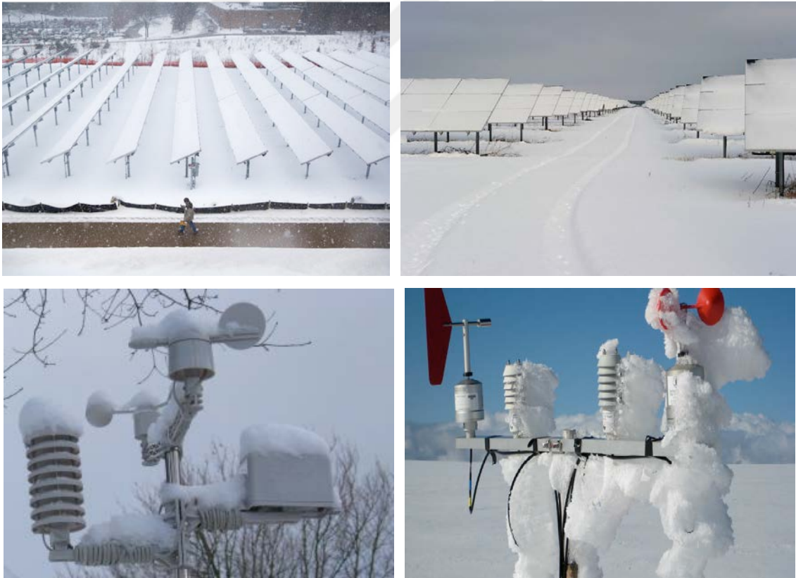
Şekil 4.1. Kar yağışının FV tesisler ve meteorolojik ölçüm cihazları üzerindeki olumsuz etkisi 2
