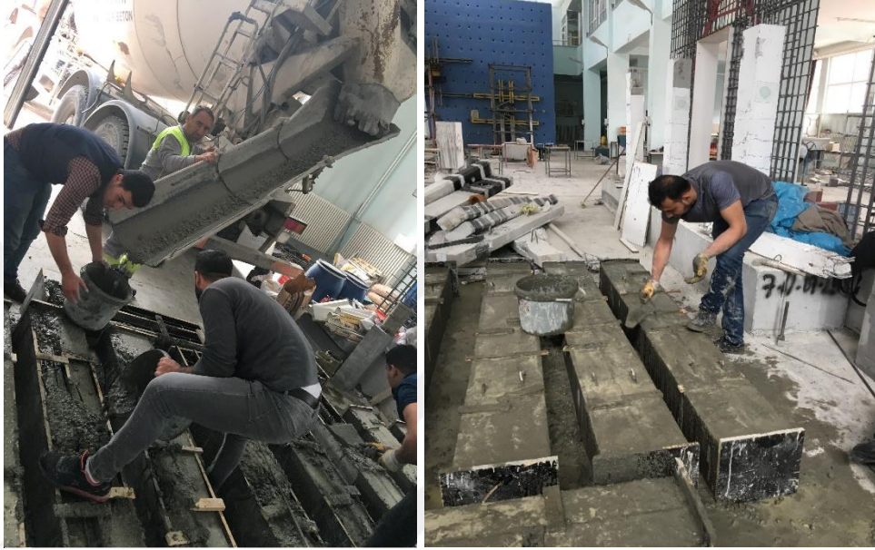
Şekil 3.19. Kiriş numunelerin beton döküm aşaması
