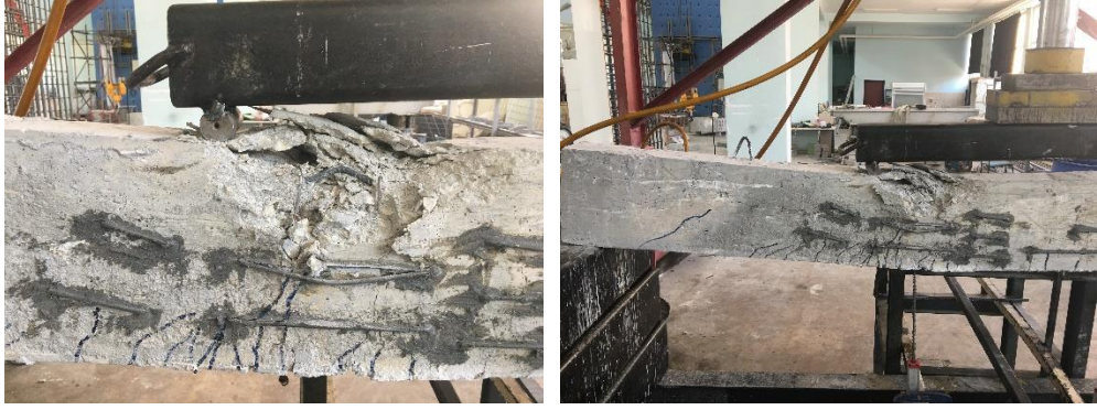
Şekil 4.34. Göçme anındaki ( BBS40mm-M ) nolu kiriş numune
