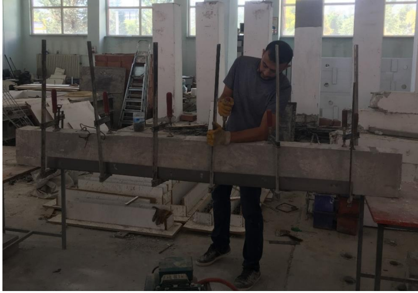
Şekil 3.28. Eğilme kirişlerde kullanılan çelik plakası uygulaması (Şen, 2019)
