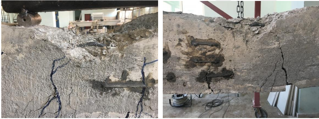
Şekil 4.10. Göçme anındaki ( BBS14mm-M ) nolu kiriş numune
