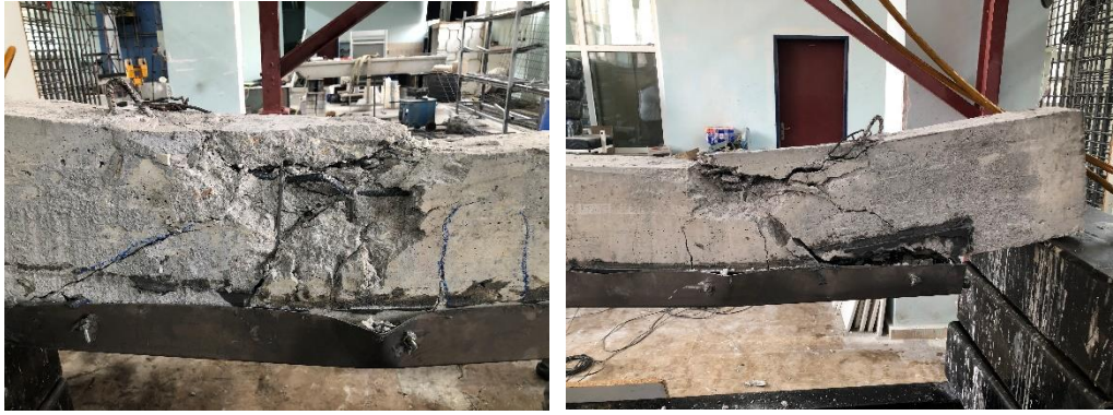
Şekil 4.18. Göçme anındaki ( BBS28mm-S ) nolu kiriş numune
