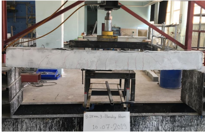
Şekil 4.24. ( PDB28mm-M ) Nolu hasarlı kiriş numunesi
