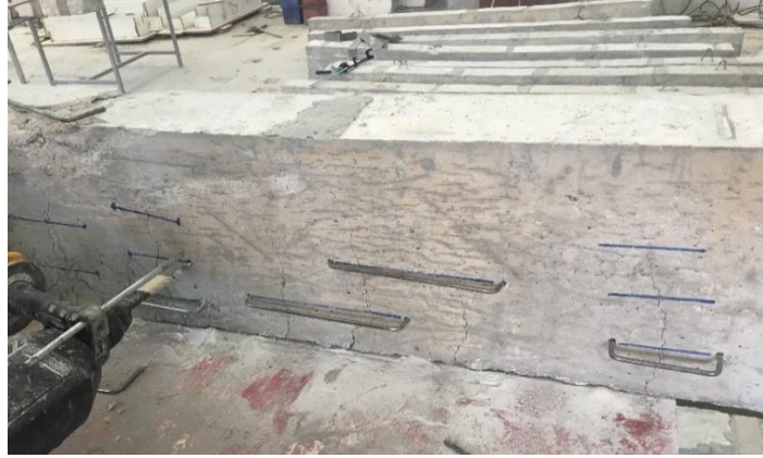
Şekil 3.29. Kiriş numuneler kullanılan mekanik bağlayıcılar uygulaması
