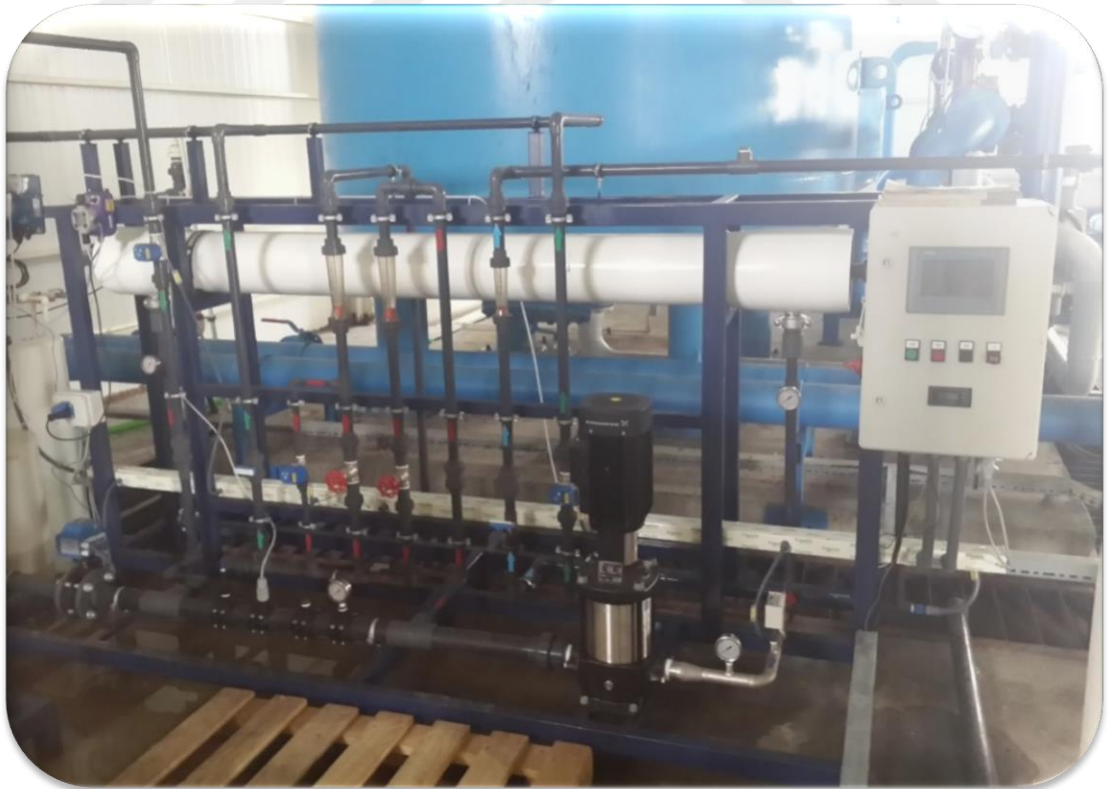
Şekil 3. 9. Pilot Tesis Nanofiltrasyon (NF) Membran
