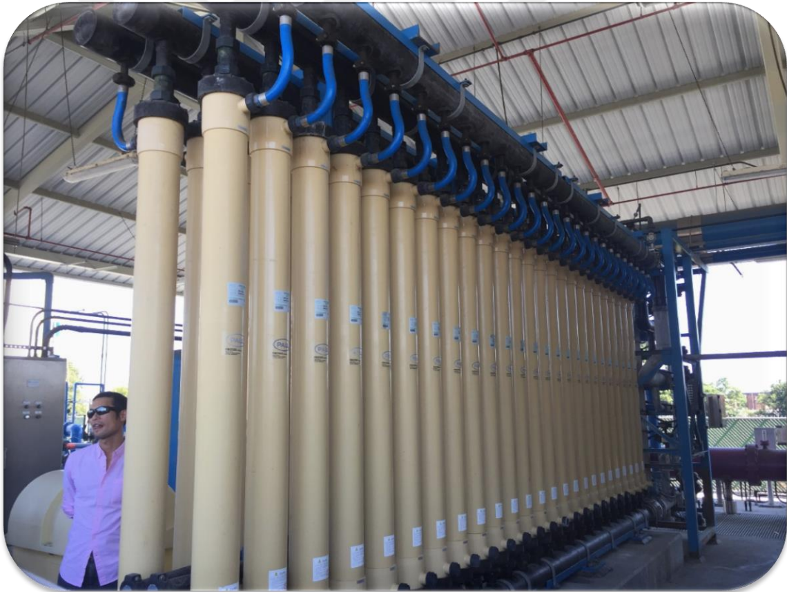
Şekil 2. 13. Vander Lans AAT Mikrofiltrasyon Prosesi (0,1 Mikron) (Long Beach, Amerika, 2017)
