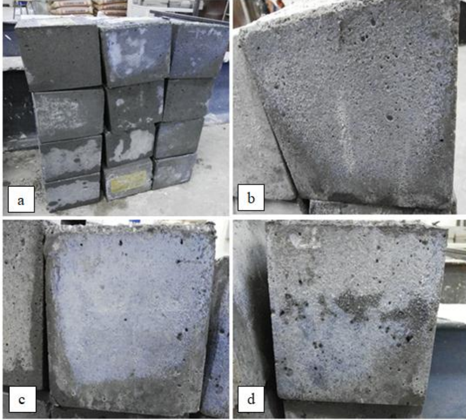
Şekil 4.6. Sülfat etkisi ile bozulma oluşan betonlar: (a) sülfat çözeltisinden çıkarılan beton numuneleri (b, c ve d) sülfat etkisi ile beton yüzeyinde oluşan beyaz lekeler ve köşelerinde meydana gelen hafif dökülmeler
