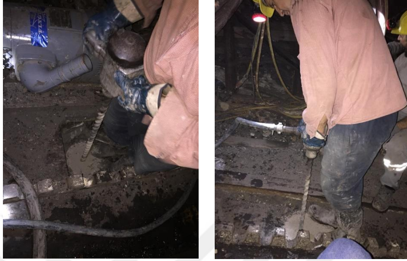
Şekil 3.26. Taban kabarması ölçüm istasyonu TKİ-GLİ Ömerler yeraltı ocağında kurulum çalışmaları
