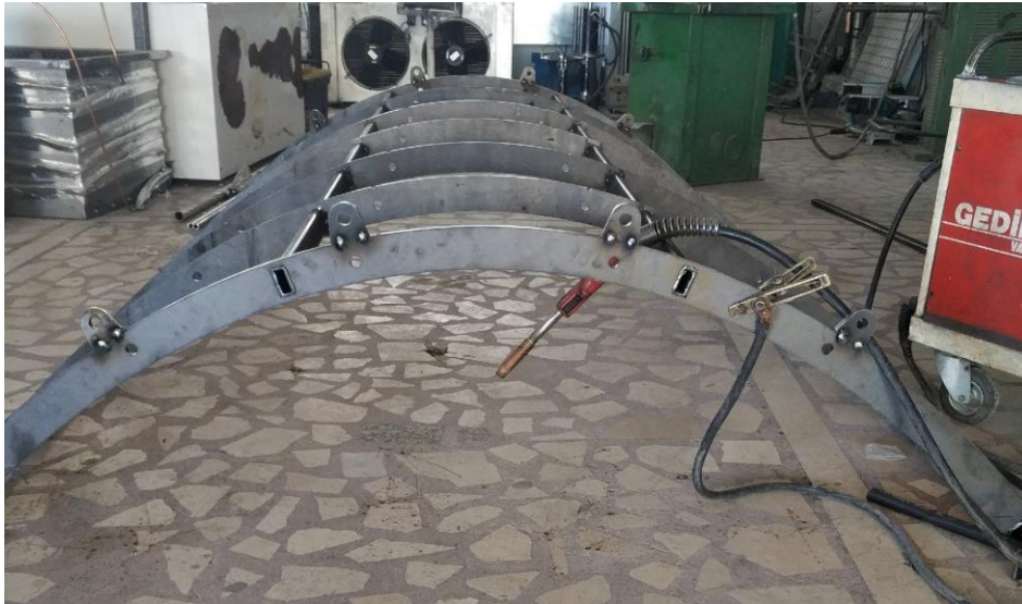
Şekil 2.3. Yansıtıcı yatağının teşkil edilmesi
