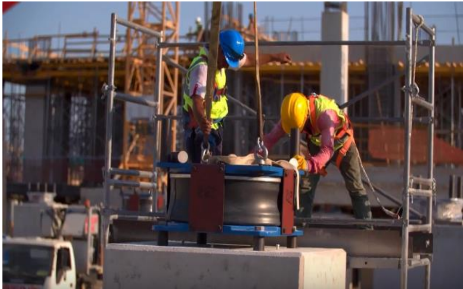
Şekil 3.6. Adana Entegre Sağlık Kampüsü sismik izolatör sistemleri uygulaması(Kaymaz,2017)
