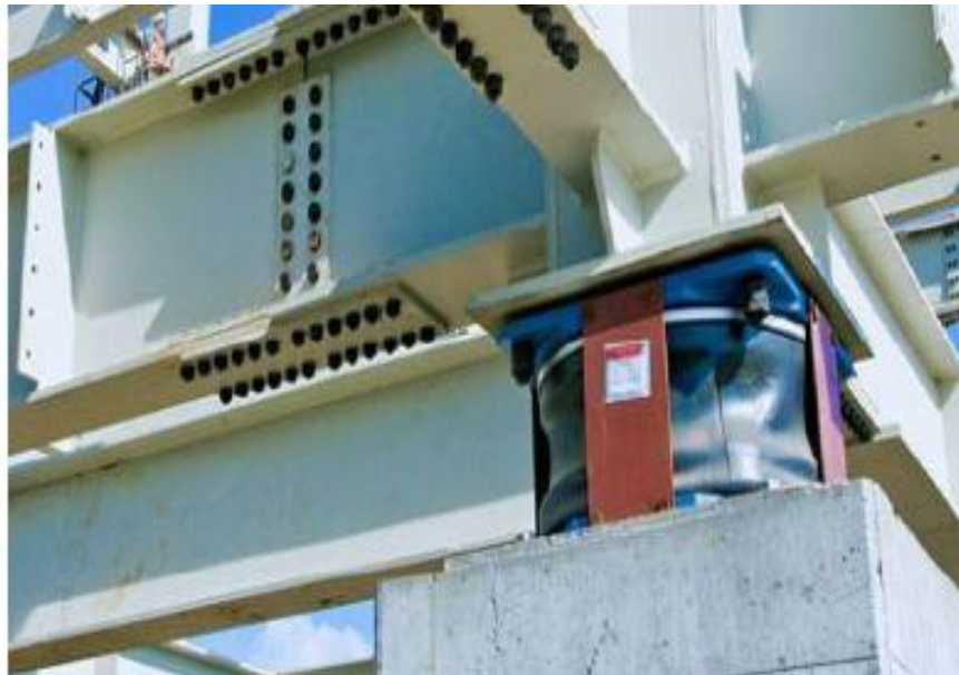
Şekil 3.4. Sabiha Gökçen Havalimanı İzolatör Örneği (Zekioğlu,2009)
