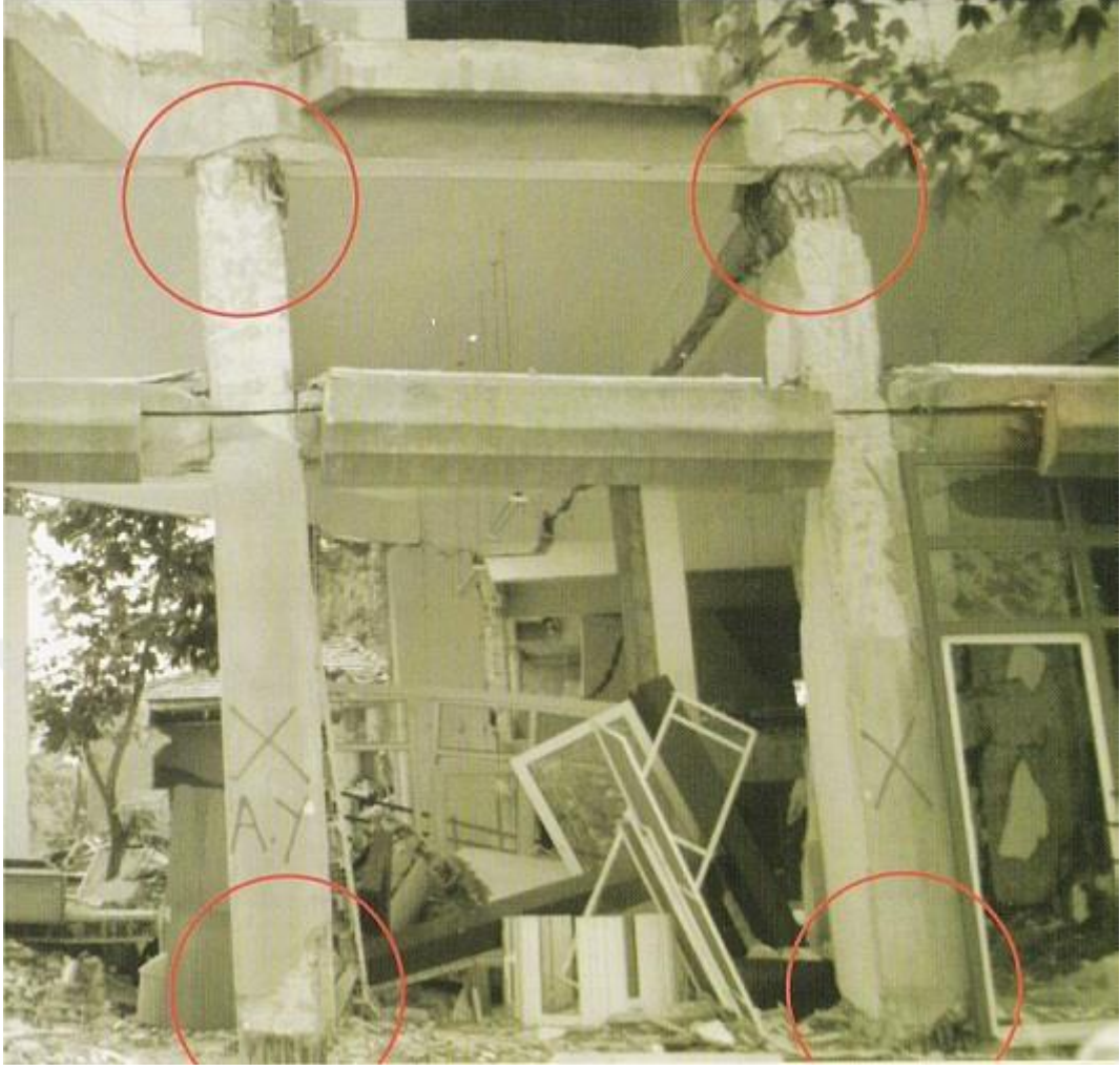
Şekil 2.7. Kolon Mafsallaşması (anonim)
