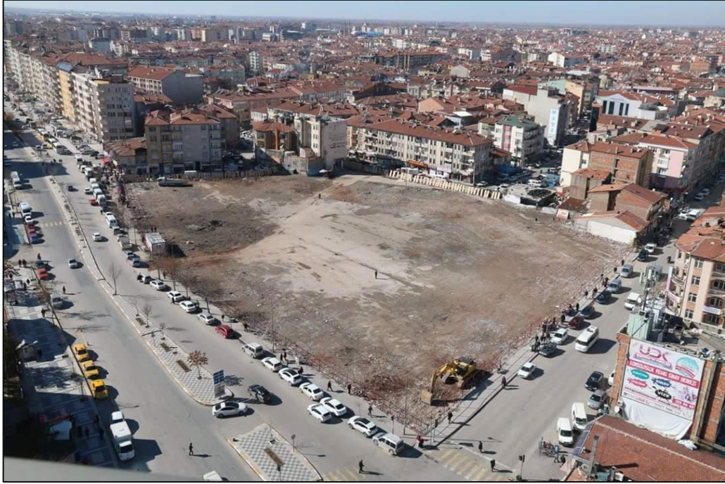
Şekil 6. 30. Dönüşüm Çalışmalarında Alanda Bulunan Yapıların Yıkılması Sonrası (Aksaray Belediye Arşivi)
