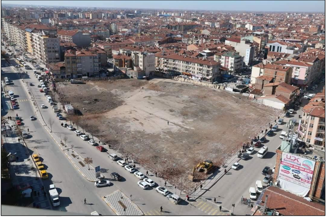
Şekil 6.13. Aksaray eski Terminal Binası Yıkım Sonrası (Aksaray Belediye Arşivi)
