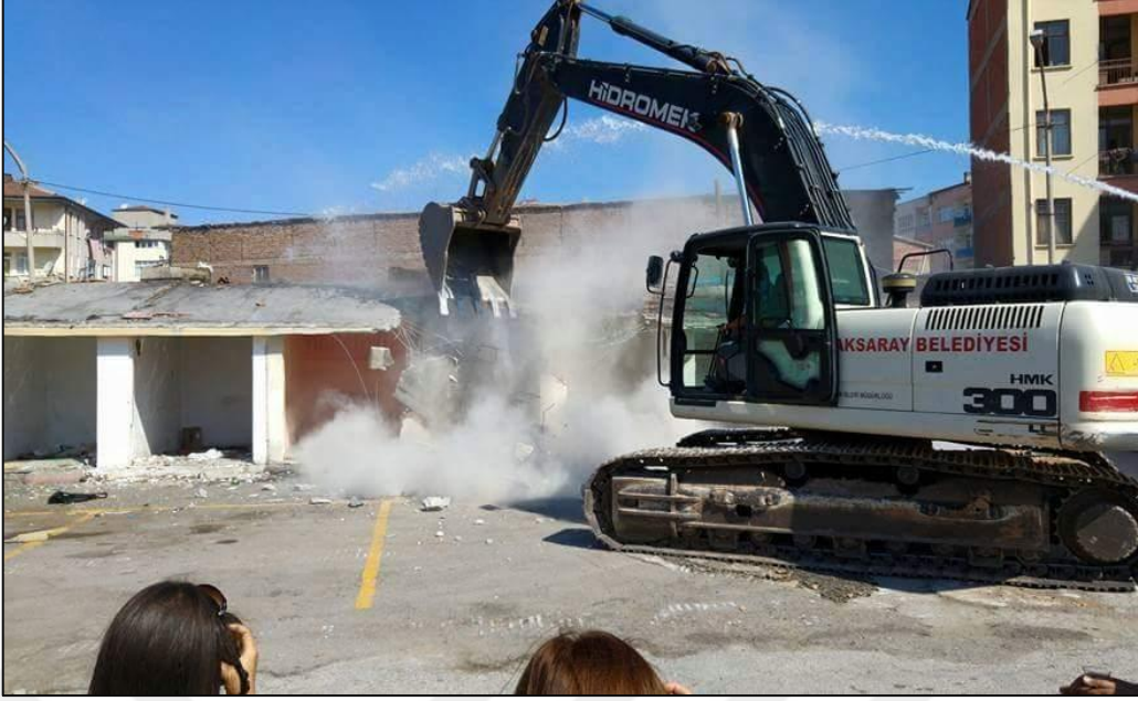
Şekil 6. 29. Dönüşüm Çalışmaları Başlatılması (Aksaray Belediye Arşivi)
