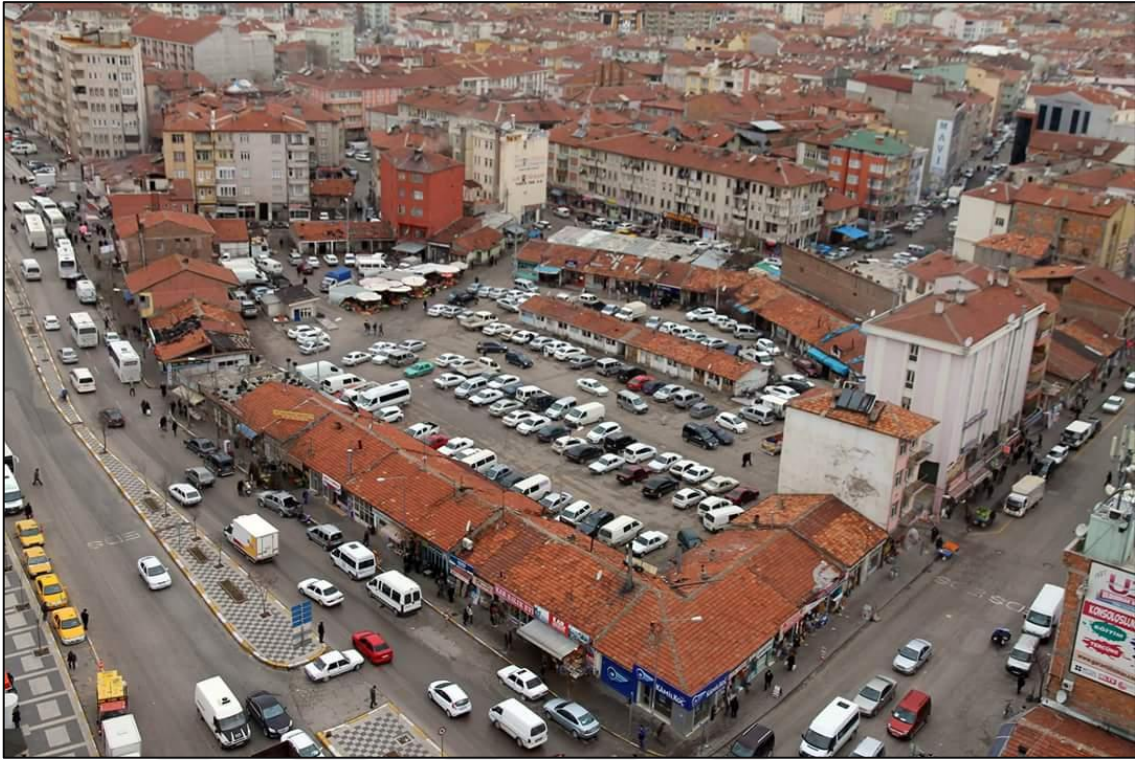
Şekil 6.12. Aksaray Eski Terminal Yapısı (Aksaray Belediye Arşivi)
