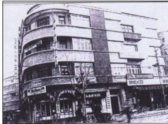
Şekil 2.3 Hayat Apartmanı Giriş Cephesi (Ulusoy, 2014)
