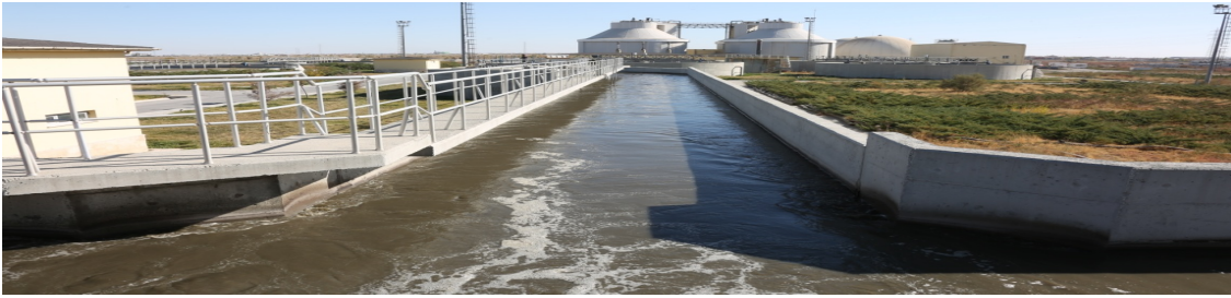
Şekil 3.6. Debi ölçüm kanalı
