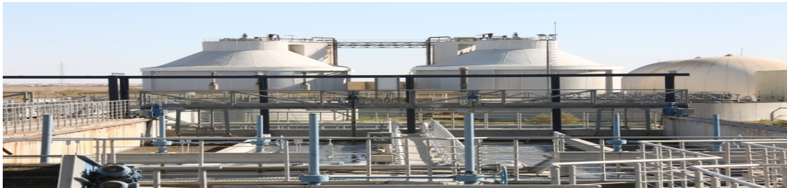
Şekil 3.5. Kum yağ tutucu
