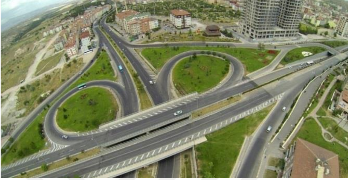
Şekil EK-1.27. Avanos Kavşağı Alt Geçidi (Veri-29)
