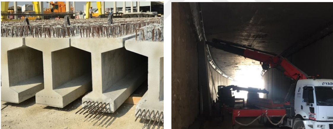
Şekil 5.4. Örnek prefabrik kirişler ve köprülü kavşakta prefabrik panel montajı
