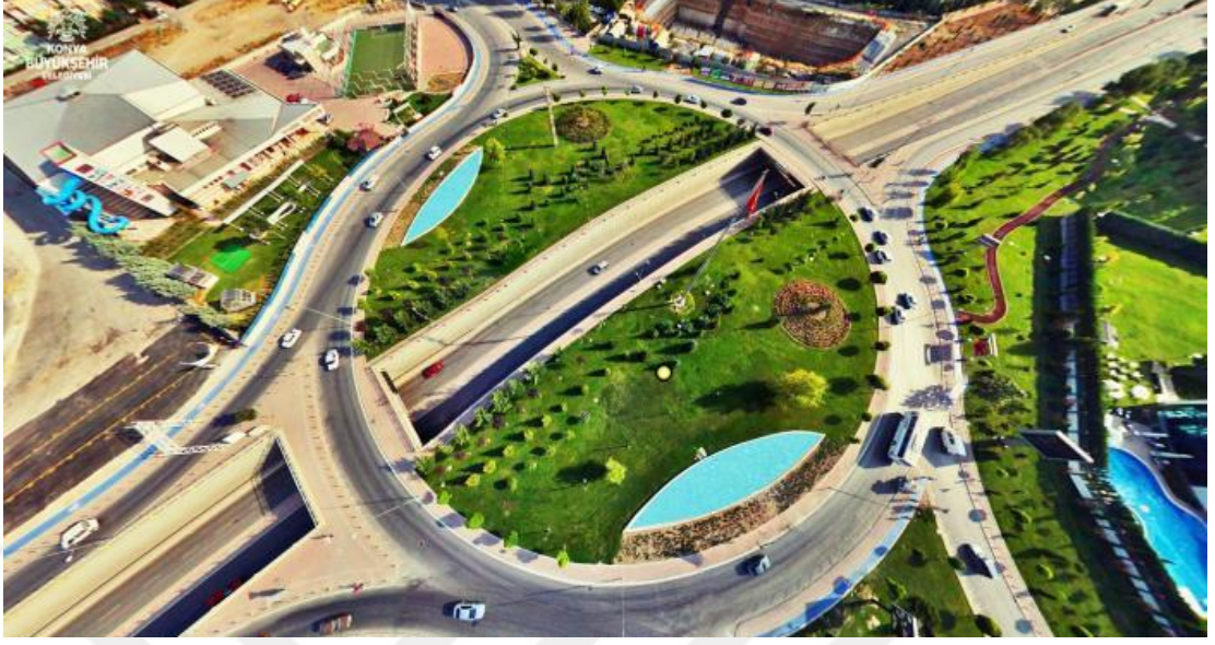
Şekil EK-1.17. Sille Kavşağı (Veri-17)
