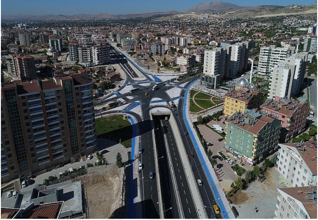
Şekil EK-1.9. Konya Beyşehir Çevre Yolu Fatih Caddesi Köprülü Kavşağı (Veri-9)
