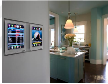
Şekil 3.22. Akıllı Ev Sistemi Kontrol Merkezi-Akıllı Kumanda (URL-20)
