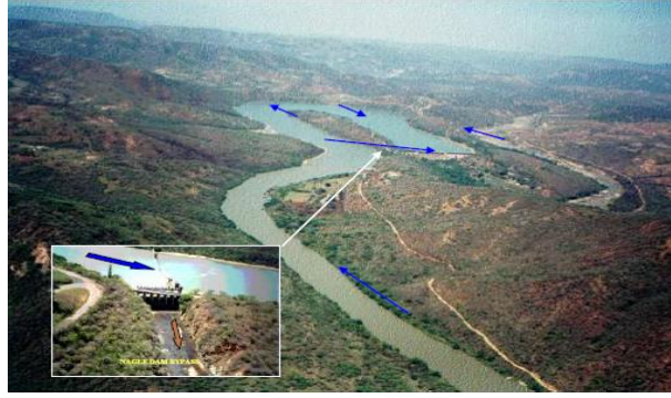
Şekil 4.6. 1950 yılında Nagle Baraj rezervuarında yapılan çevirme kanalı (ICOLD, 2009)
