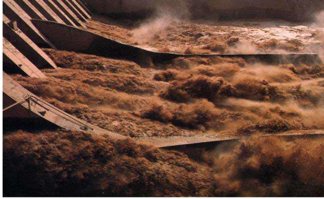
Şekil 4.7. Sanmenxia Barajında biriken sedimentin yıkama yöntemiyle uzaklaştırılması (ICOLD, 2009)
