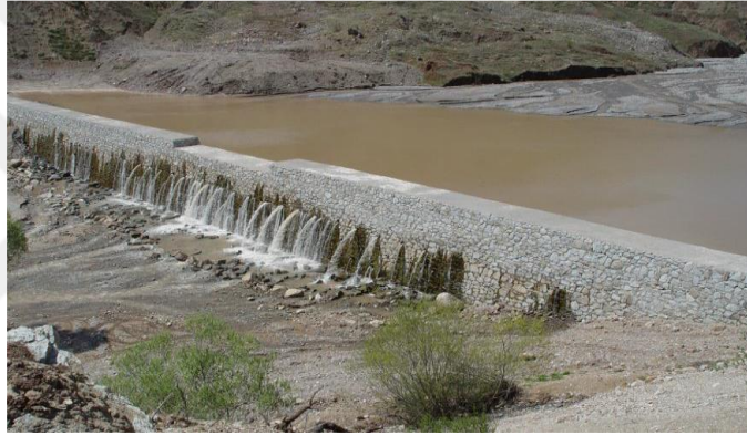
Şekil 4.4. Heyelandan kaynaklanan rusubatı depolamak ve kontrol etmek için inşa edilen tersip bendi, Çamlığöze Barajı Havzası, Uludere, Suşehri/Sivas (Dinçsoy, 2013)
