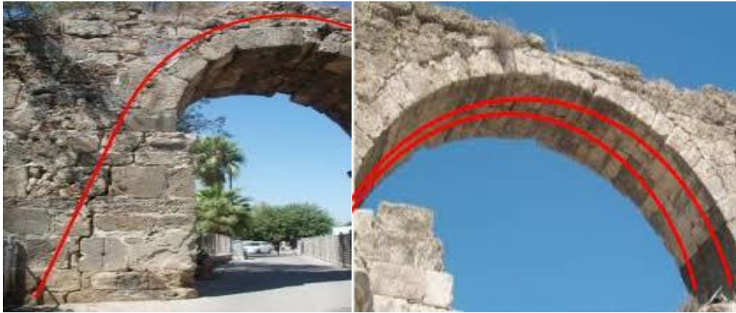
Şekil 4.8. Yerçekimin kemerlerde oluşturduğu çatlak tipleri
