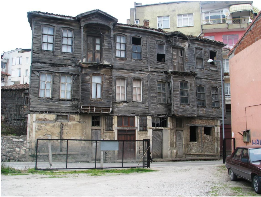
Şekil 3.9. Sinop-Merkez (Sivil yapı)
