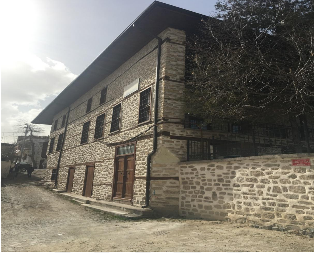
Şekil 6.4. Güney cepheden görünüş
