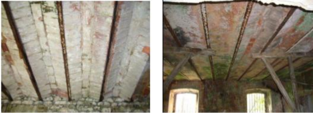
Şekil 3.30. Adi volta döşeme gösterimi
