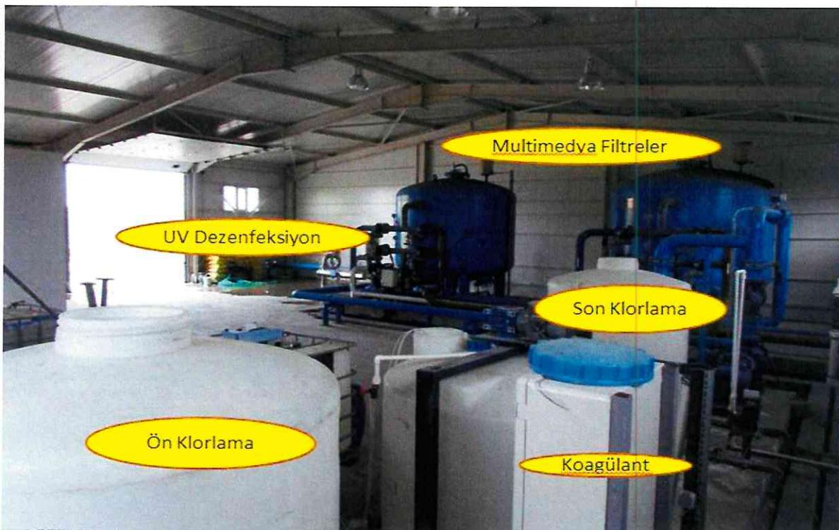
Şekil 3.4. Atıksu geri kazanım tesisi iç görünüm
