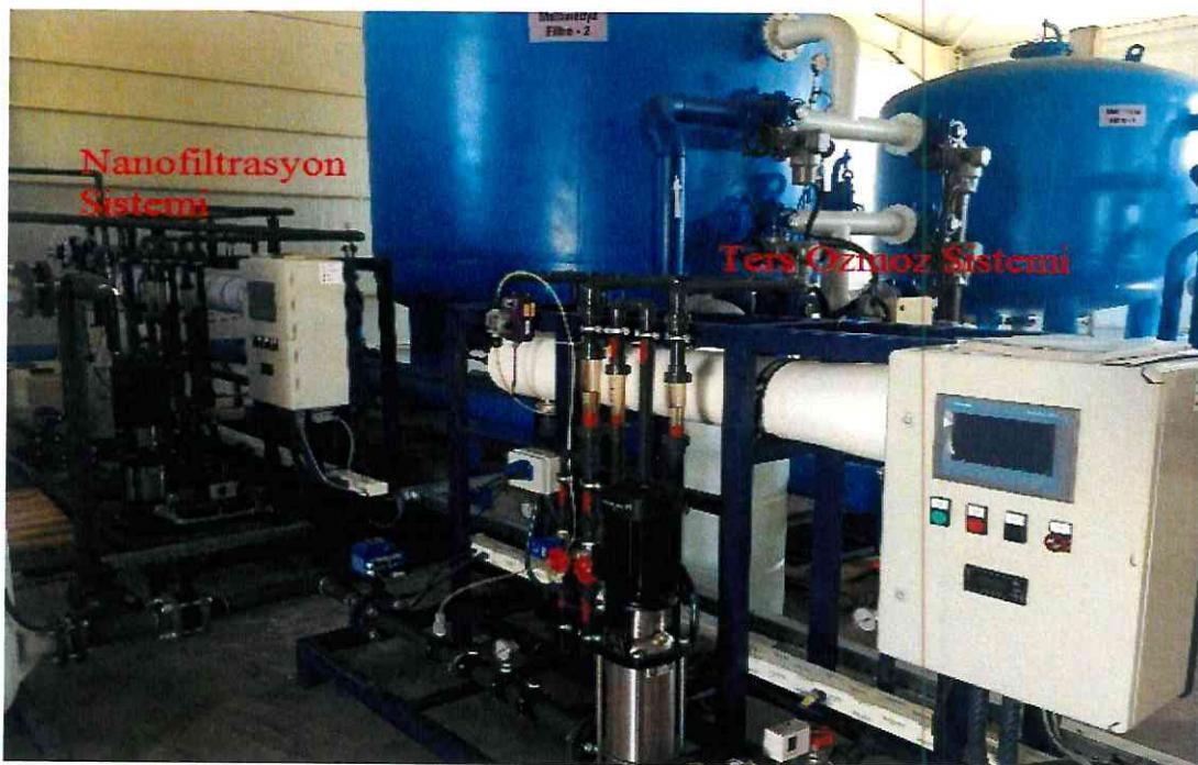
Şekil 3.14.NF ve RO sistemi
