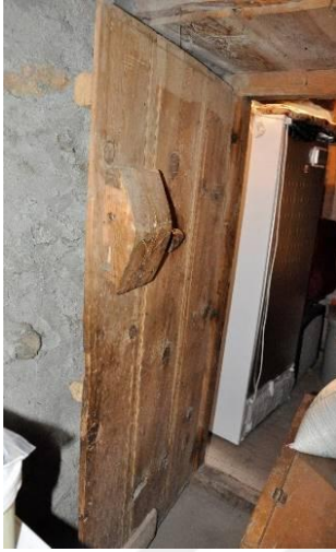
Şekil 5.1.10. Oda (Z 02) kapısı
