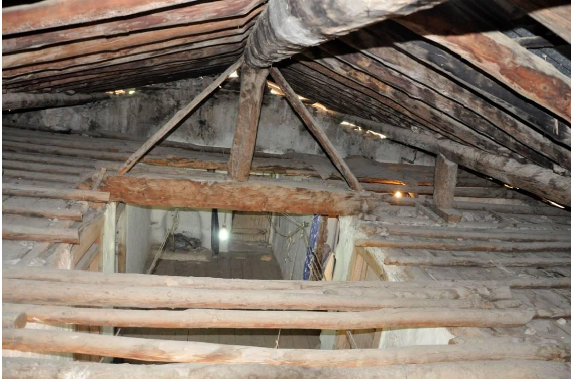
Şekil 5.3.26. Çatı arasından sofanın görünüşü
