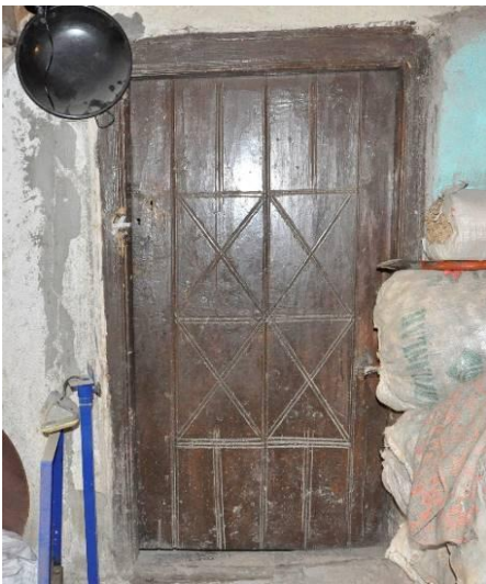
Şekil 5.2.13. Oda (Z03) kapısı
