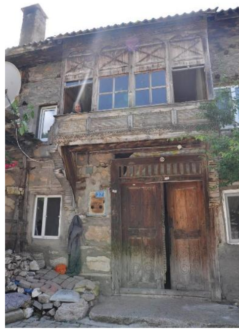
Şekil 6.1.67. Ahşap çıkma ve giriş kapısı
