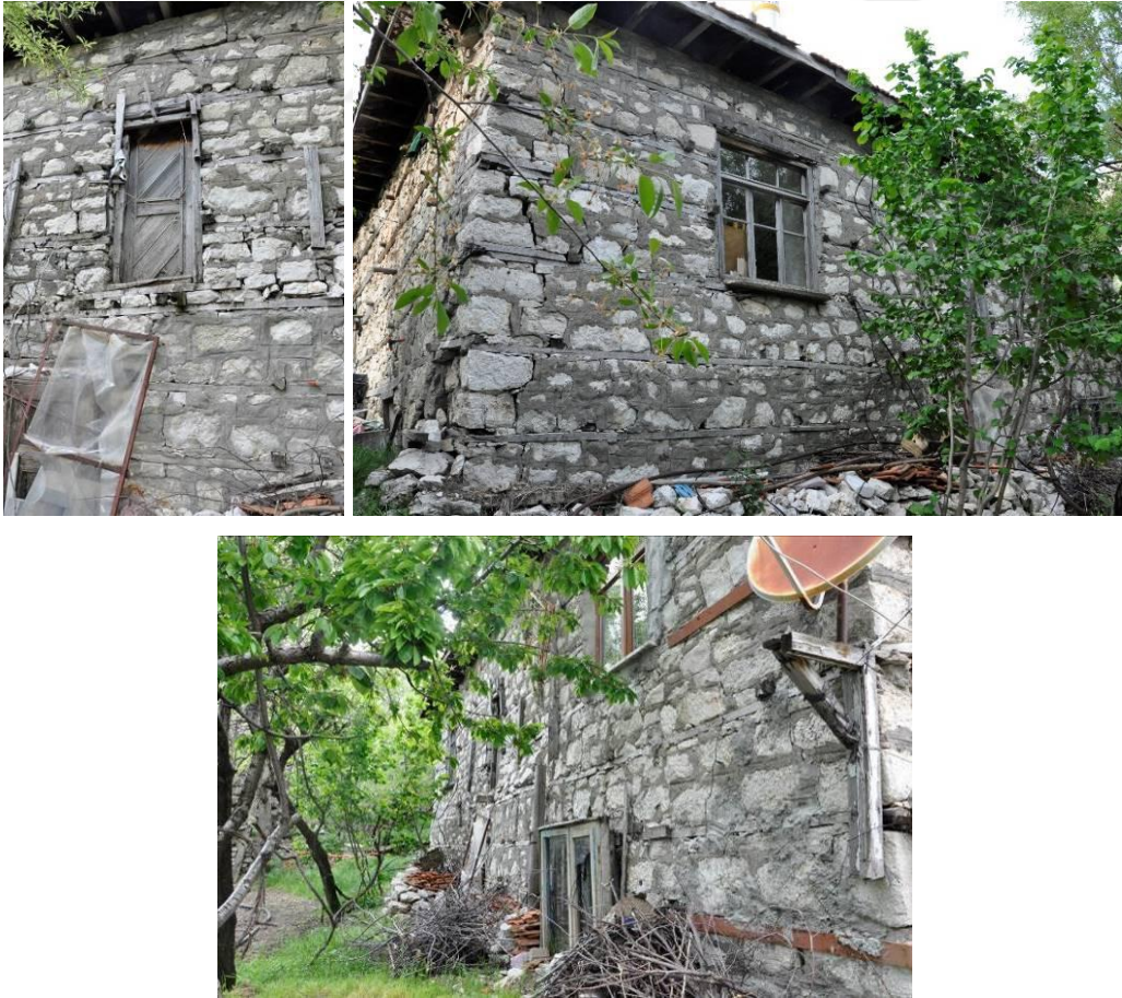
Şekil 5.5.42. D. Kırıcı evi güney cephesi
