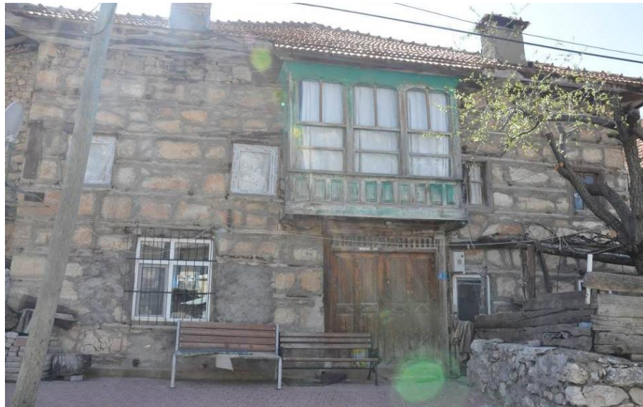
Şekil 6.1.69. 122 ada 5 parseldeki konut
