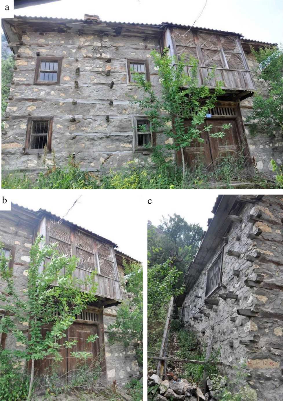
Şekil 6.1.5. 104 ada 45 parseldeki konut a) kuzeybatı (giriş) cephesi, b) kafesli cumbası, c) kuzeydoğu cephesi.
