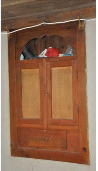
Şekil 5.1.8. Kuzey duvarındaki dolap
