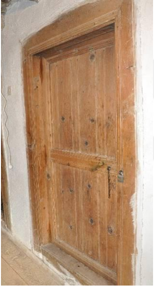
Şekil 5.1.6. Oda (Z 01) kapısı
