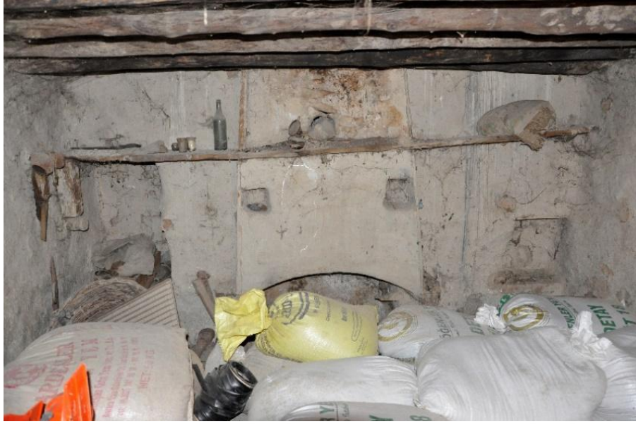
Şekil 5.4.12. odanın (Z 02) güneydoğu duvarı
