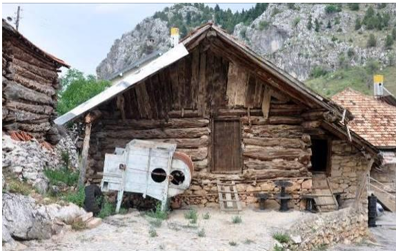
Şekil 4.38.114 ada 47 parseldeki samanlık
