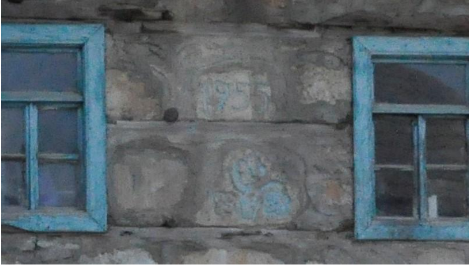
Şekil 5.2.3. Giriş cephesinde bulunan yapının kitabesi
