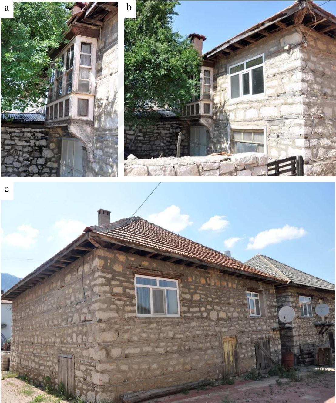
Şekil 6.2.4. 170 ada 2 parseldeki konut; a) ahşap çıkması, b) batı (giriş) cephesi, c) doğu cephesi.
