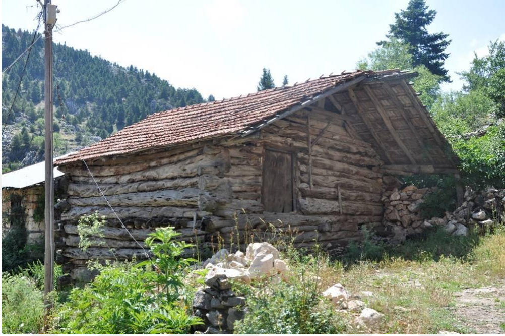
Şekil 4.9. Çandı tekniđi ile yapılmıř samanlık örneđi, Pınarbaşı
