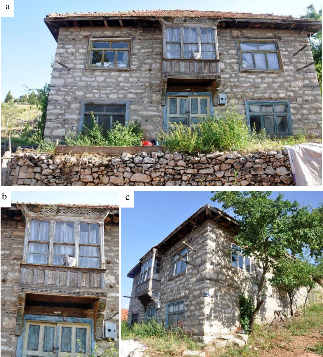
Şekil 6.2.38. 208 ada 2 parseldeki konut; a) Kuzey (giriş) cephesi, b) Süslemeli ahşap cumbası, c) Genel görünümü.
