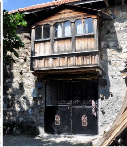
Şekil 5.7.4. Giriş Kapısı(mevcut hali)
