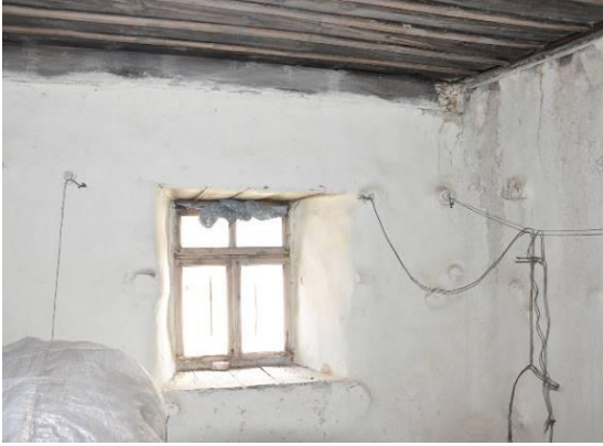
Şekil 5.3.29. 101 nolu oda penceresi
