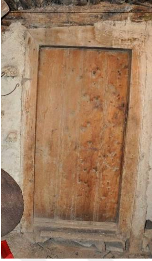
Şekil 5.3.11. Z 02 nolu oda kapısı
