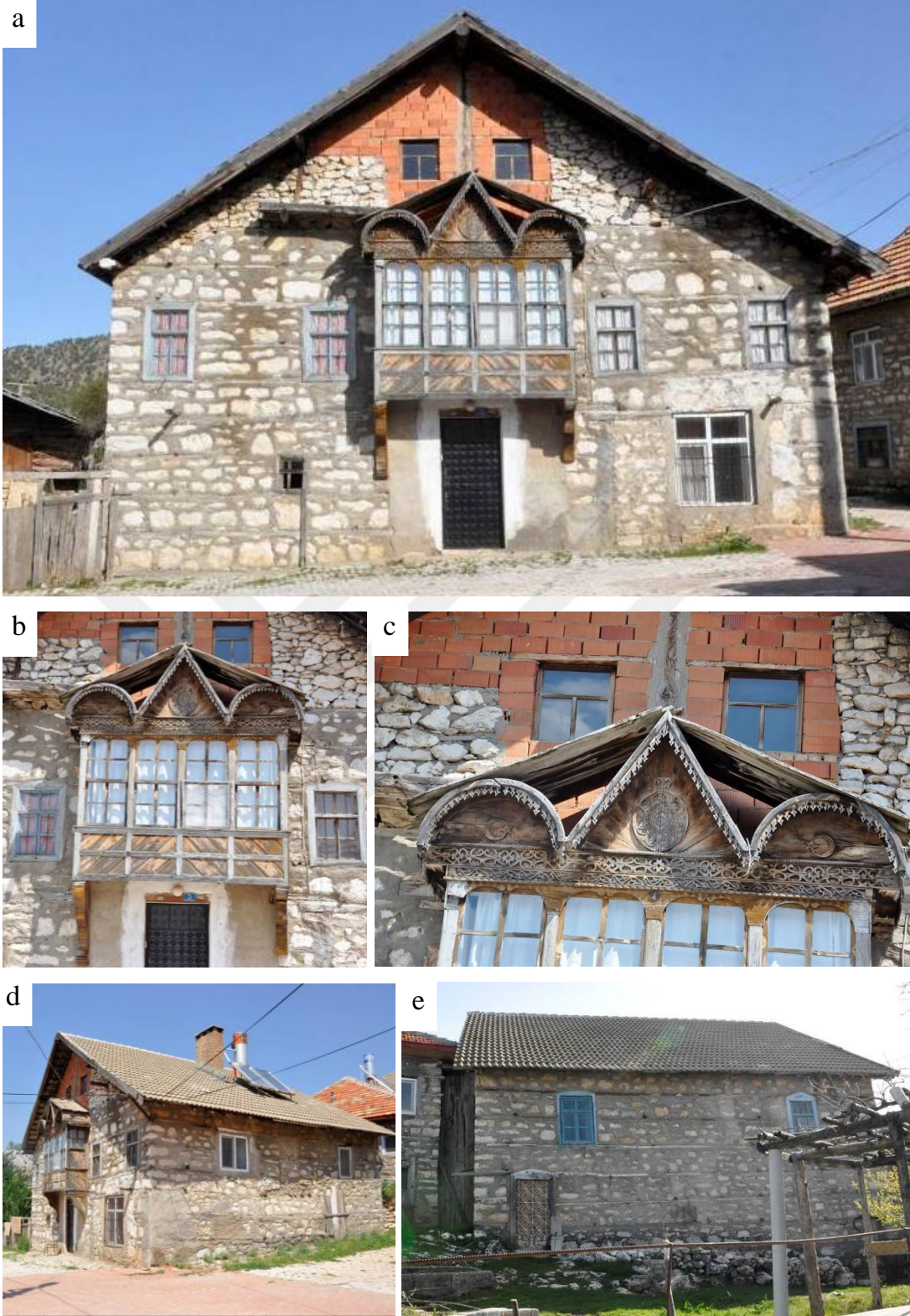
Şekil 6.2.13. 185 ada 1 parseldeki konut a) kuzeybatı (giriş) cephesi, b) ahşap cumbası, c) cumbanın süslemeli alınlığı d) genel görünümü, e) kuzeydoğu cephesi.
