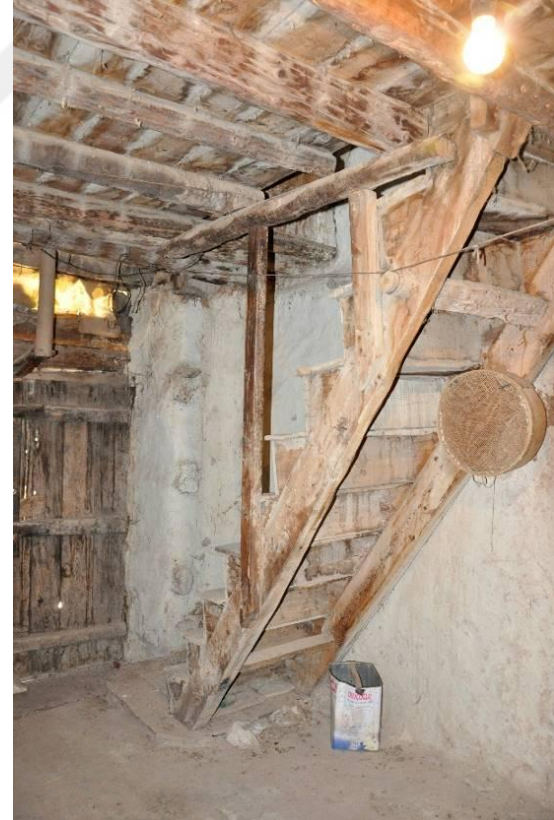
Şekil 5.3.6. Ahşap merdiven ve ana giriş kapısı
