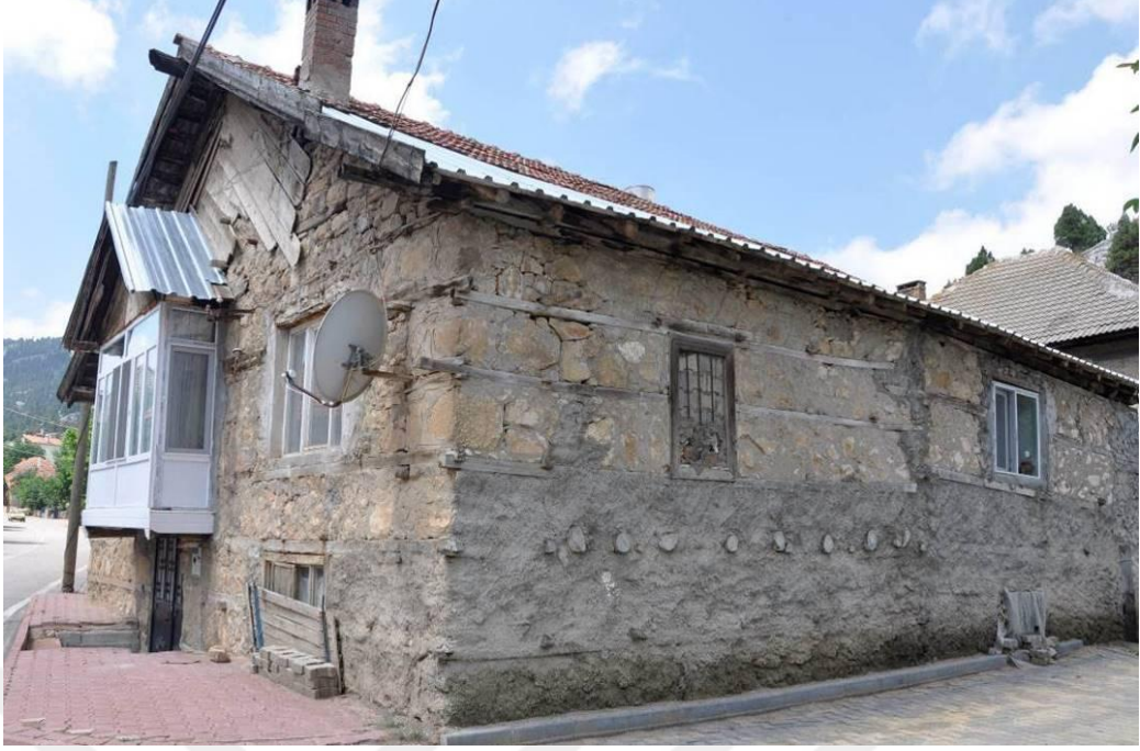
Şekil 6.1.20. 114 ada 22 parseldeki konut genel görünümü
