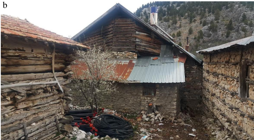
Şekil 6.1.40. 119 ada 2 parseldeki konut; a) doğu (giriş) cephesi, b) batı cephesi.
