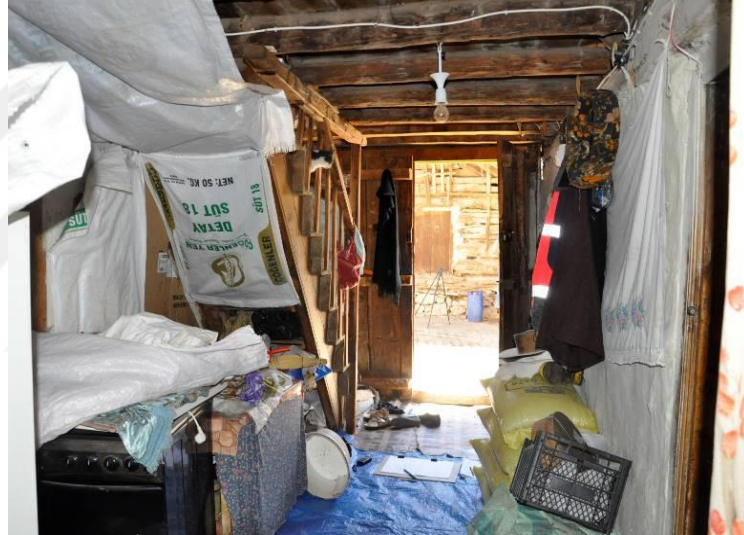
Şekil 5.7.6. Zemin kat sofası
