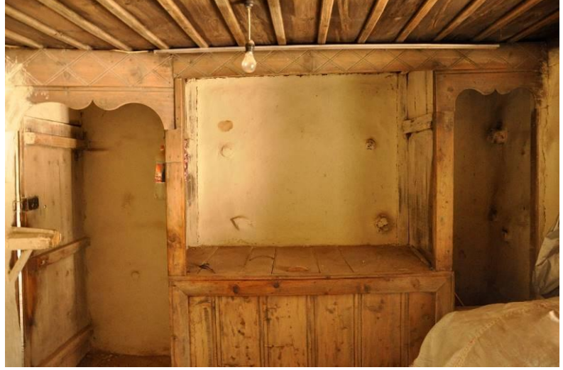
Şekil 5.3.28. 101 nolu odadaki yüklük-çağlık
