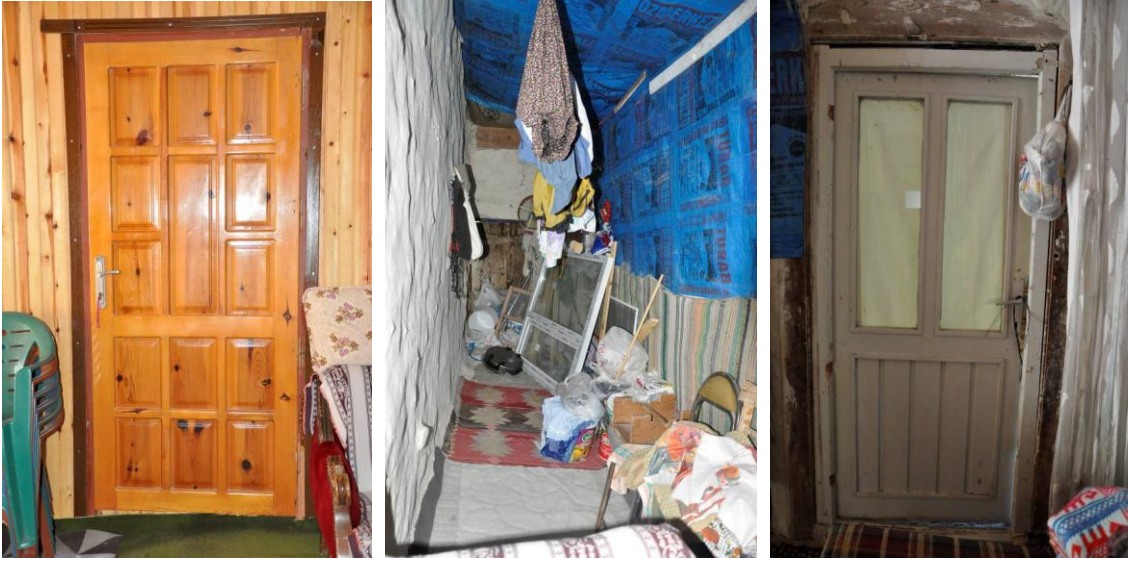
Şekil 5.5.21. Oda (1 01) kapısı Şekil 5.5.22. 1 01 ve 1 02 arası boşluk Şekil 5.5.23. Oda (1 02) kapısı
