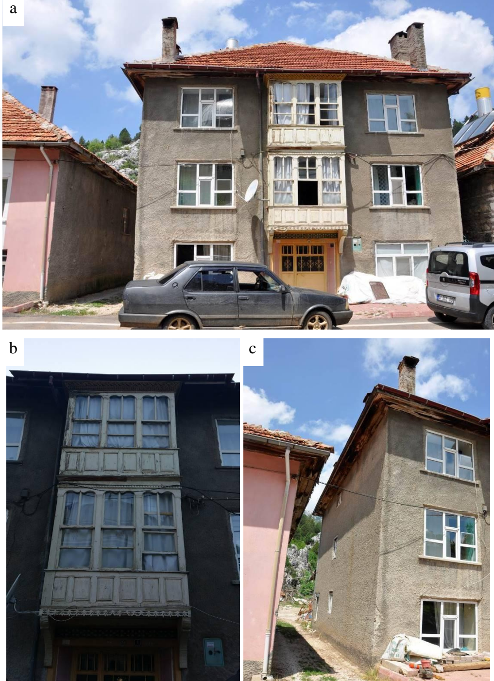
Şekil 6.1.31. 114 ada 93 parseldeki konut; a) doğu (giriş) cephesi, b) ahşap cumbası, c) güney cephesi.
