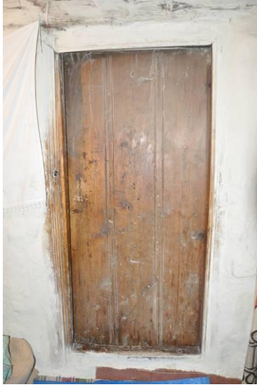
Şekil 5.7.7. Z 01 Oda kapısı
