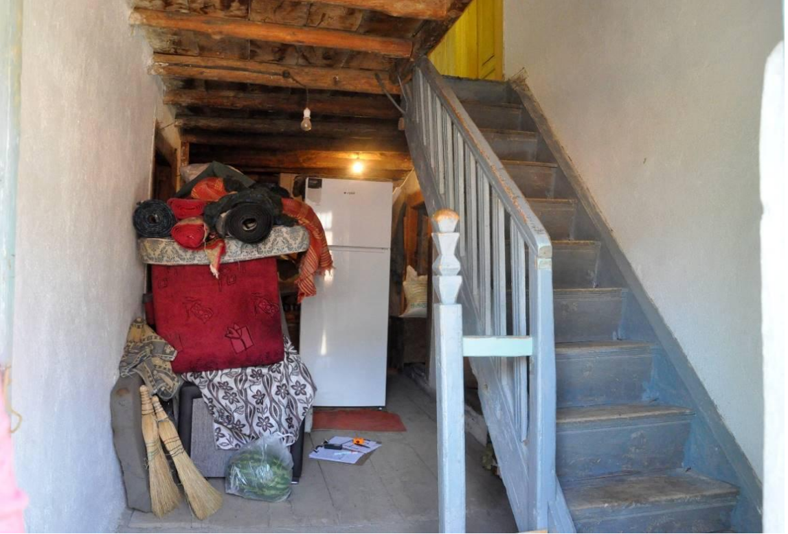
Şekil 5.1.5. Zemin kat sofası ve merdiveni
