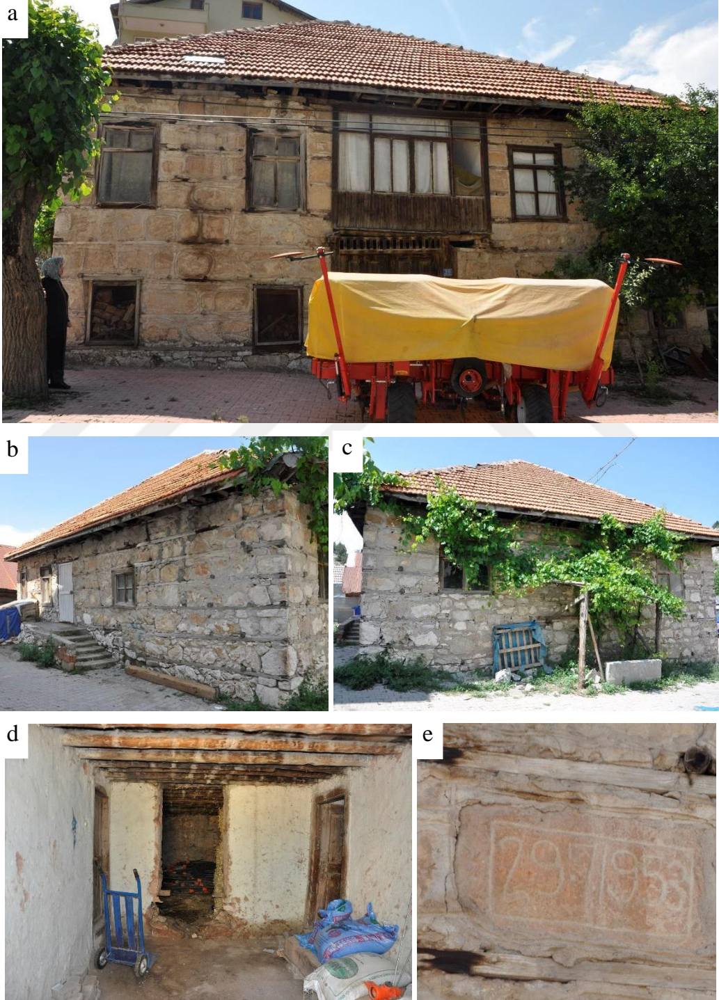
Şekil 6.1.39. 118 ada 6 parseldeki konut; a) kuzeydoğu (giriş) cephesi, b) güneybatı cephesi, c) güneydoğu cephesi, d) zemin kat sofası, e) kitabesi.
