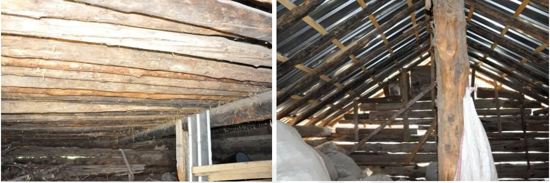
Şekil 4.26.114 ada 49 parseldeki samanlık iç mekânı
