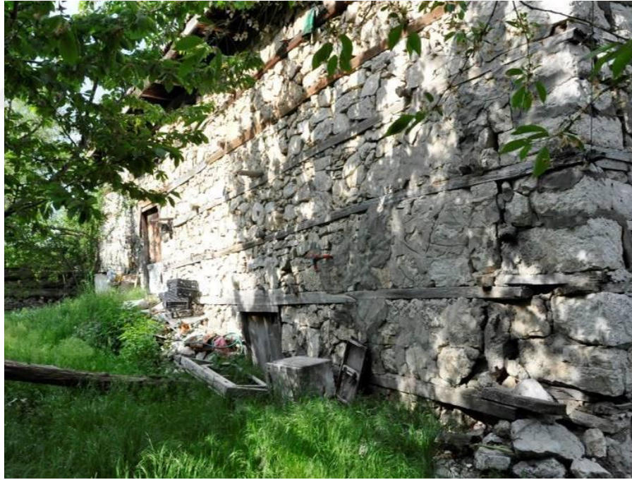
Şekil 5.5.40. D. Kırıcı evi batı cephesi
