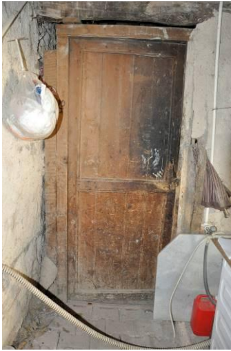
Şekil 5.5.7. Z 01 oda kapısı
