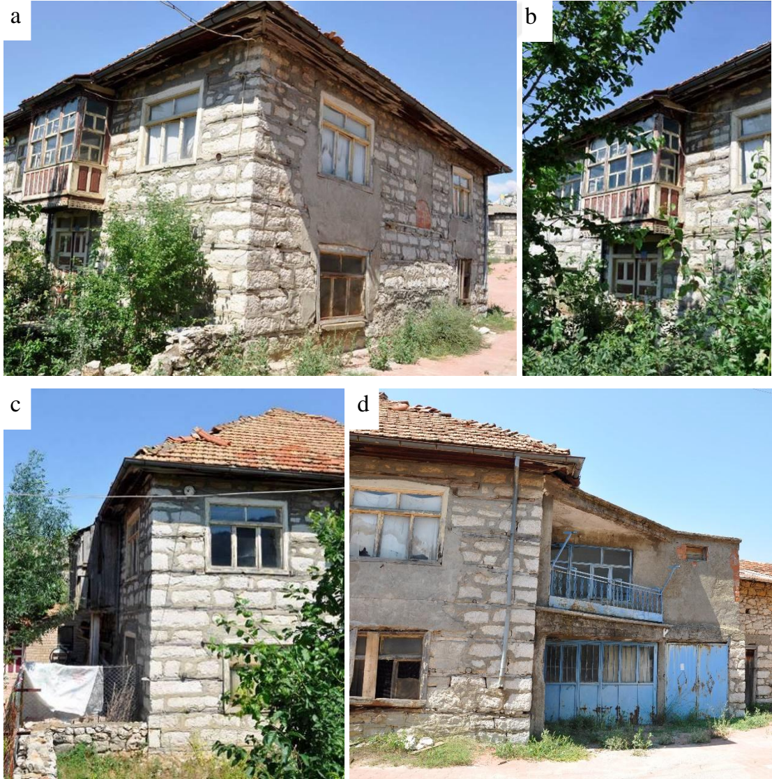
Şekil 6.2.2. 169 ada 1 parseldeki konut; a) genel görünümü, b) cumbası, c) ahşap hela, d) Doğu (arka) cephesi.
