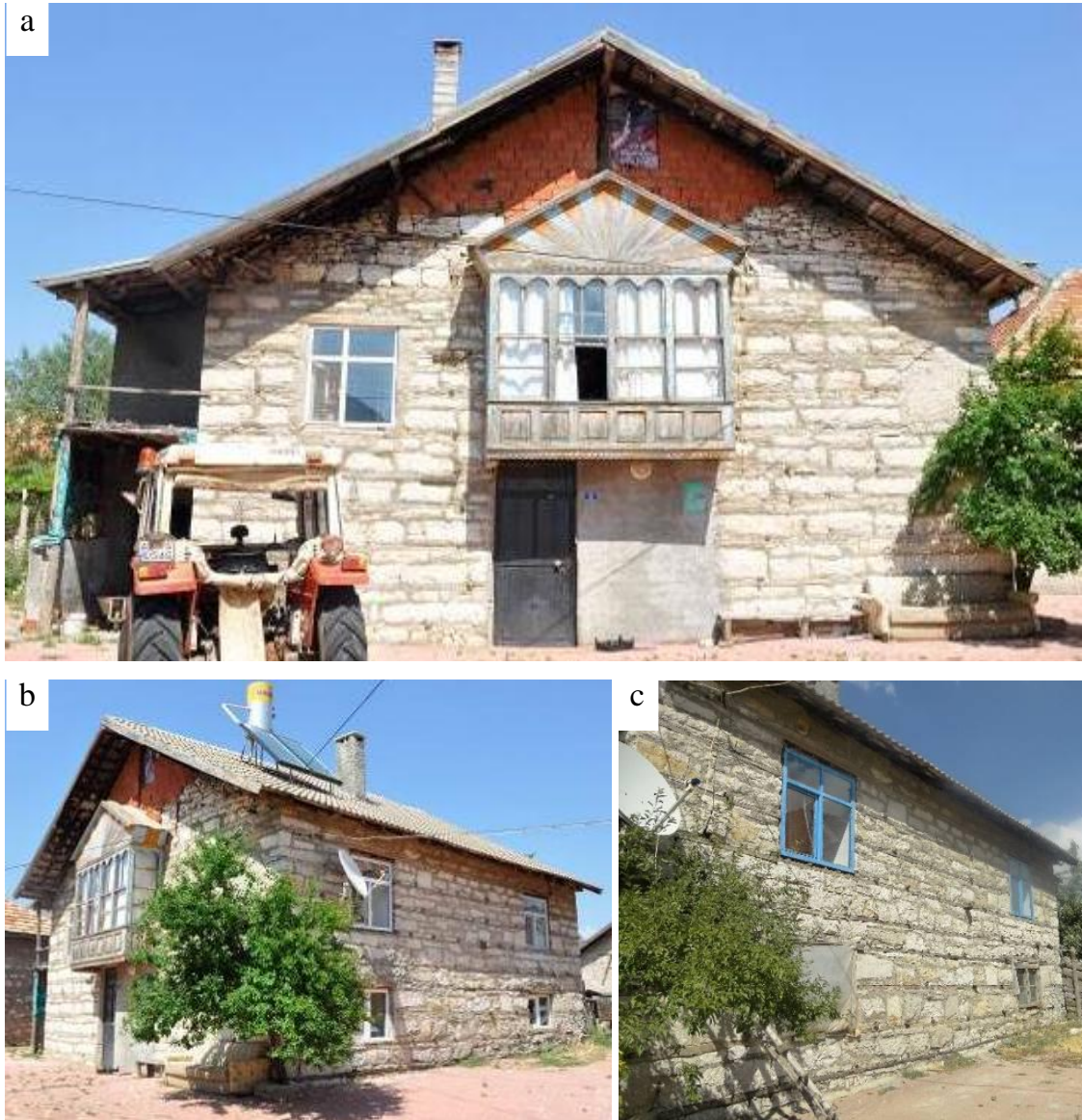
Şekil 6.2.5. 172 ada 1 parseldeki konut; a) batı (giriş) cephesi, b) genel görünümü, c) güney cephesi.
