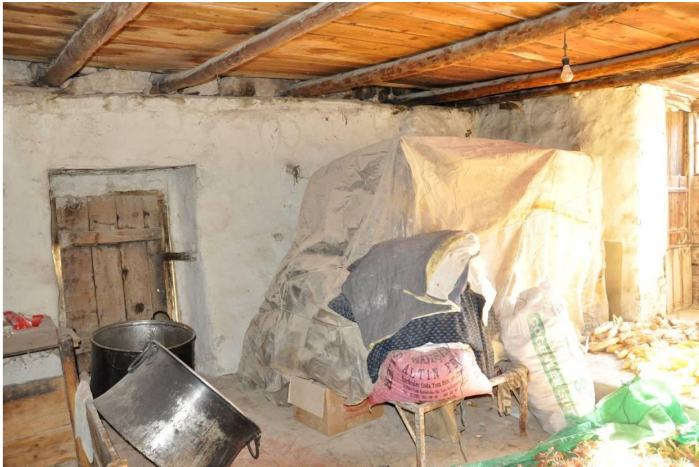
Şekil 5.4.16. Sofanın (1 04) güneybatı duvarı
