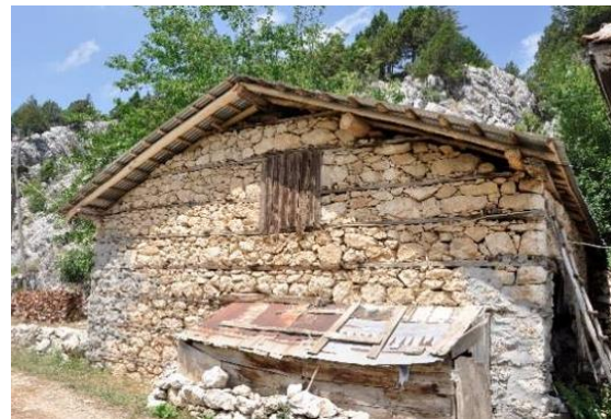
Şekil 4.41.114 ada 2 parseldeki taş ahır-samanlık
