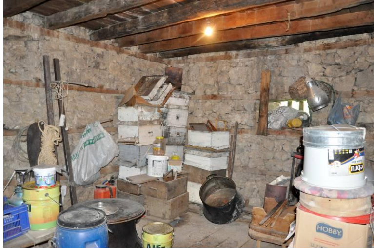
Şekil 5.5.8. Z 01 oda genel görünüşü ve penceresi
