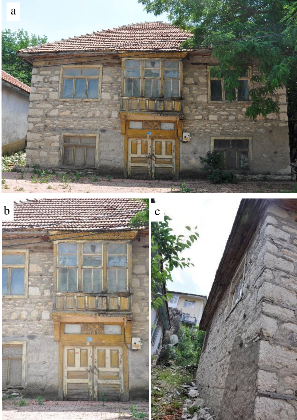
Şekil 6.2.39. 209 ada 1 parseldeki konut a) Kuzeybatı (giriş) cephesi, b) Ahşap cumbası, c) Kuzeydoğu cephesi
