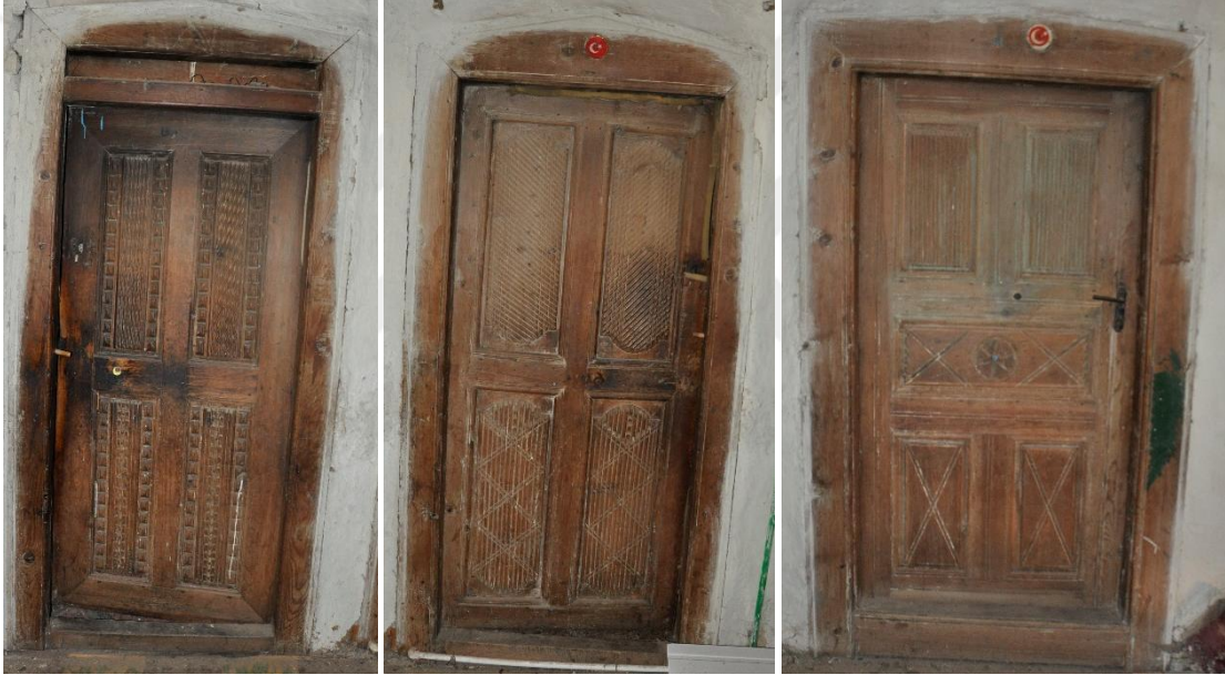
Şekil 6.2.31. Oda kapıları; a) 1 01 nolu oda kapısı, b) 1 02 nolu oda kapısı, c) 1 04 nolu oda kapısı.
