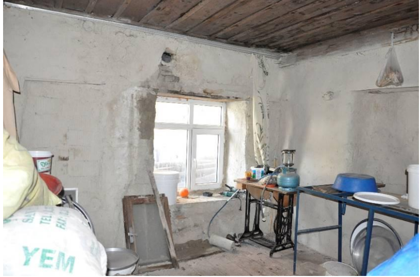
Şekil 5.2.21. Oda (1-02) pencere ve duvar nişi
