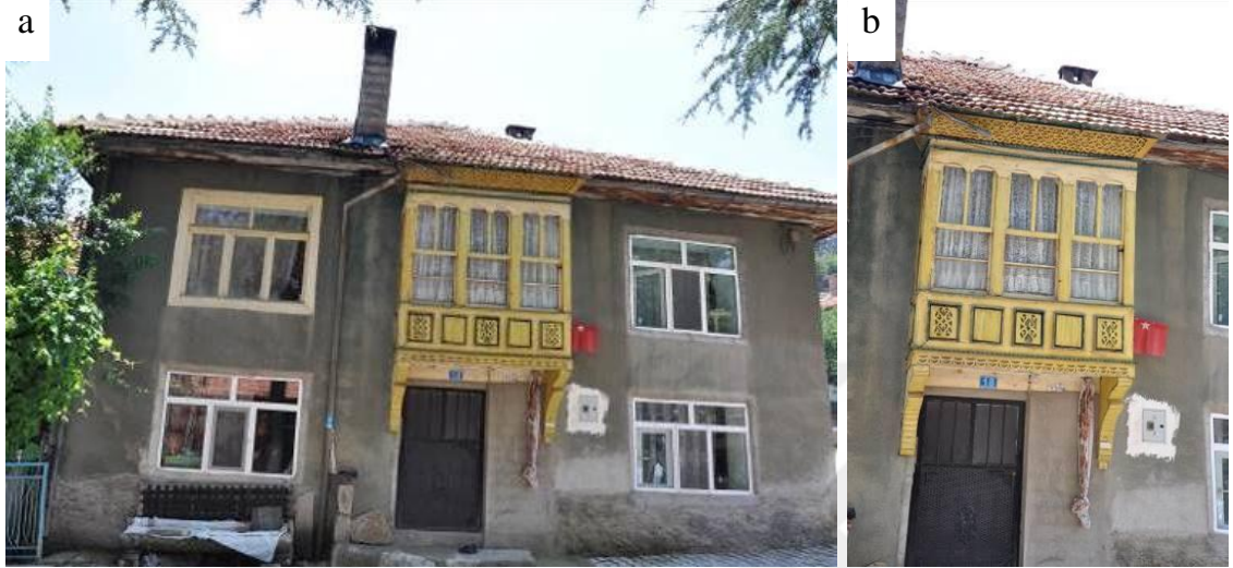
Şekil 6.2.14. 191 ada 2 parseldeki konut; a) kuzey (giriş) cephesi, b) ahşap cumbası.
