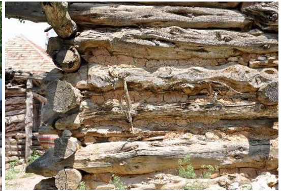
Şekil 4.30. Kütükler arası çamur sıva
