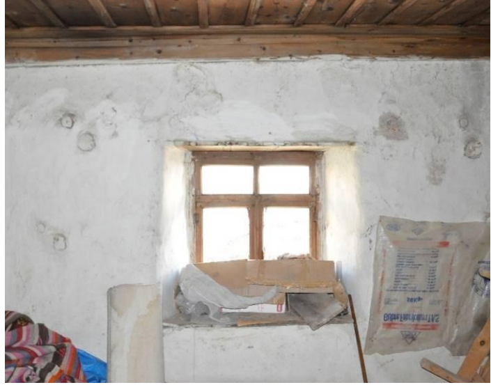
Şekil 5.3.32. 1 02 nolu oda penceresi
