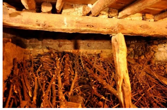
Şekil 5.2.11. Odunluk (Z02) ahşap giriş ve dikme
