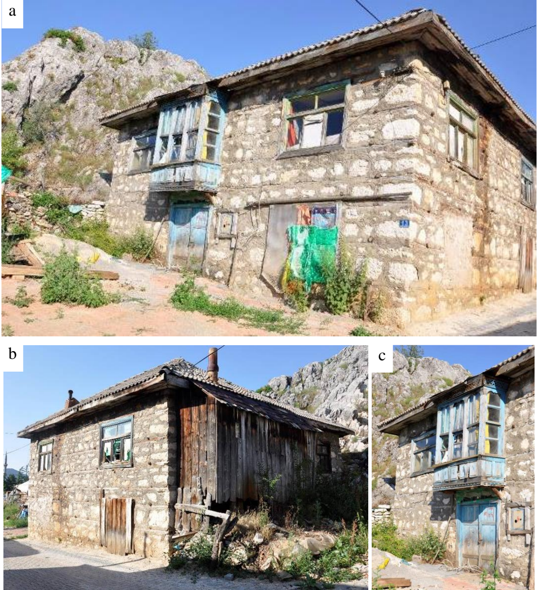
Şekil 6.2.37. 207 ada 1 parseldeki konut; a) Genel görünümü, b) Arka cephesi, c) Ahşap cumbası.
