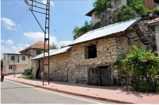
Şekil 4.44.209 ada 3 parseldeki taş ahır-samanlığın iç ve dış cephesi
