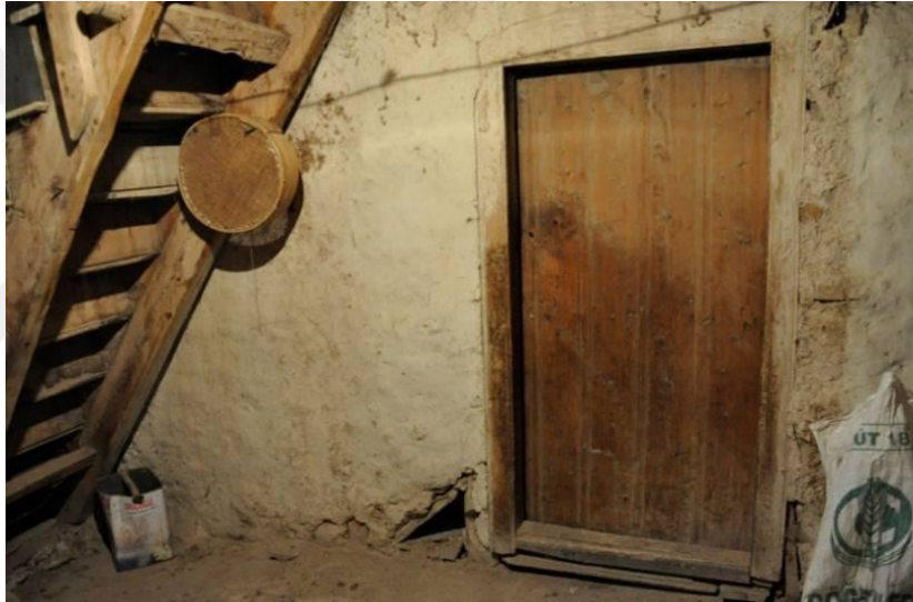
Şekil 5.3.7. Oda (Z 01) kapısı
