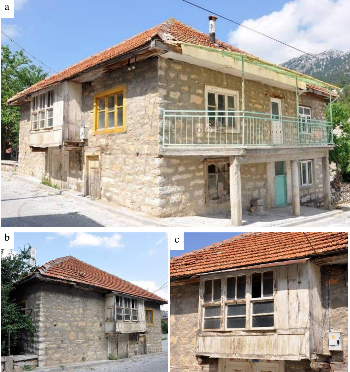
Şekil 6.1.8. 108 ada 3 parseldeki konut a) genel görünümü, b) güneydoğu cephesi, c) cumbası.
