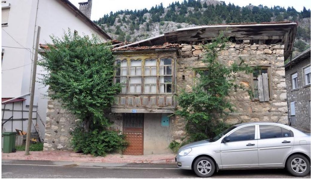
Şekil 6.1.11. Yapının günümüzdeki durumu
