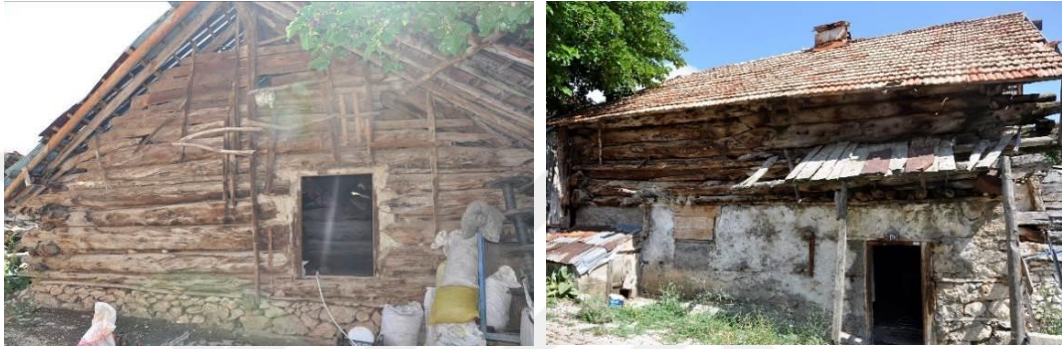
Şekil 4.32. 114 ada 80 parseldeki ahır-samanlık girişleri
