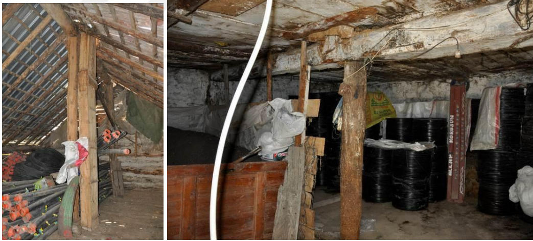
Şekil 4.33. 114 ada 80 parselde ahır-samanlık iç mekânı
