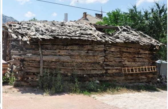
Şekil 4.28.183-4 parseldeki hartamalı ahşap samanlık
