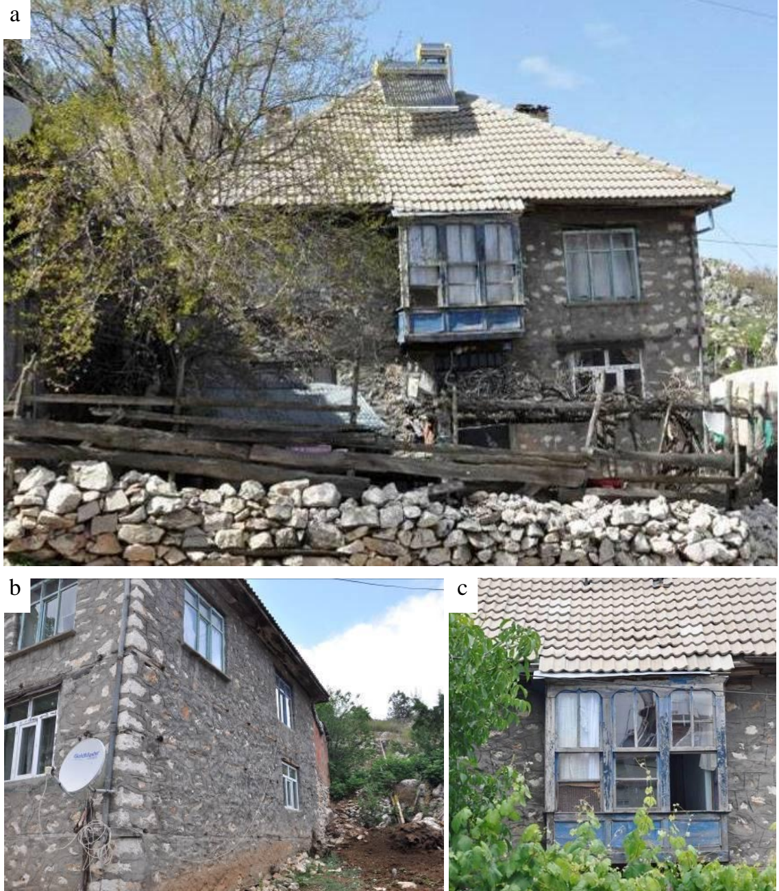
Şekil 6.1.30. 114 ada 83 parseldeki konut a) kuzey (giriş) cephesi, b) doğu cephesi, c) ahşap cumbası.
