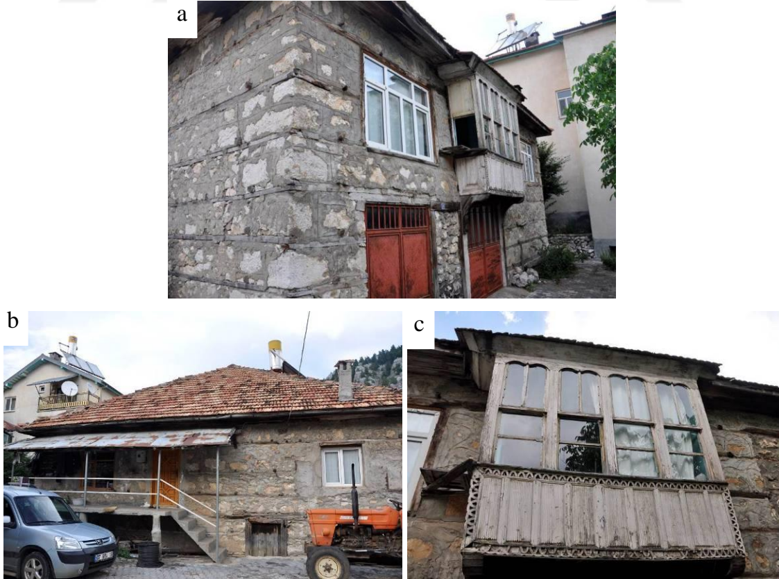
Şekil 6.1.25. 114 ada 48 parseldeki konut; a) kuzeydoğu cephesi, b) güneybatı cephesi, c) ahşap cumbası.
