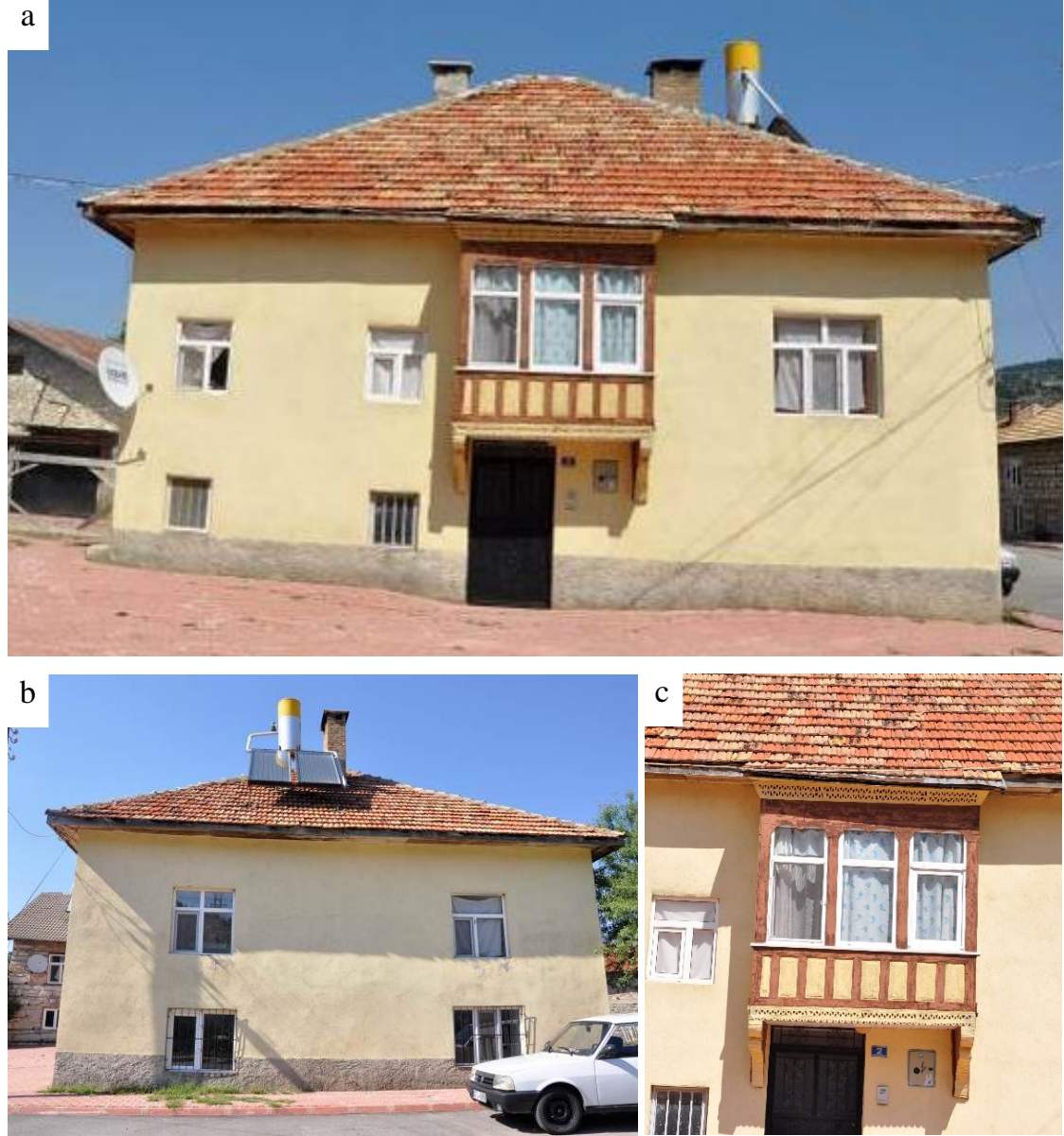
Şekil 6.2.6. 172 ada 2 parseldeki konut; a) batı (giriş) cephesi, b) güney cephesi, c) ahşap cumbası.
