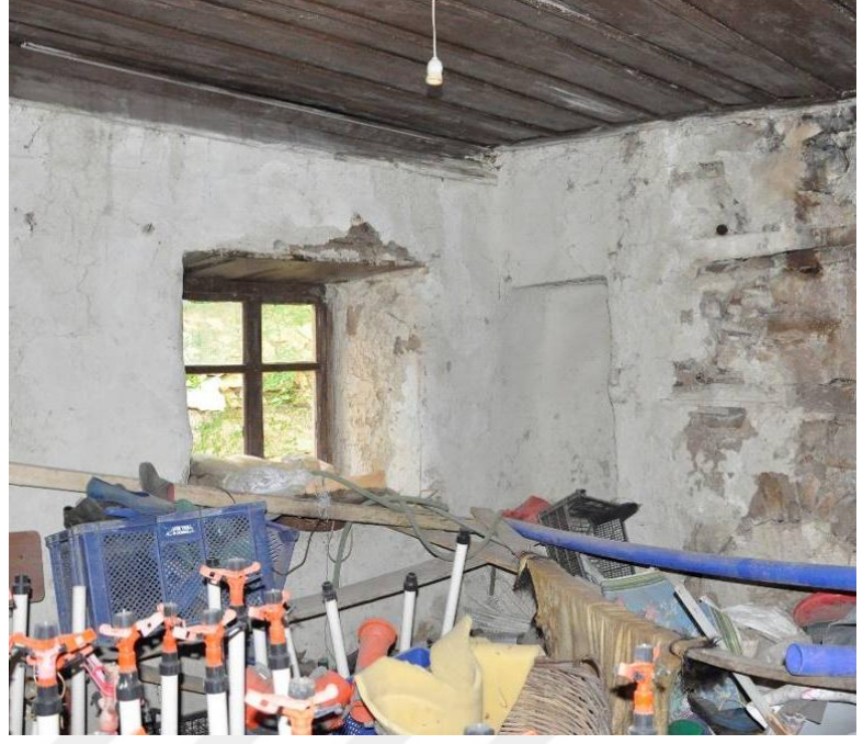
Şekil 5.2.23. Oda (1-03) pencere ve duvar nişi
