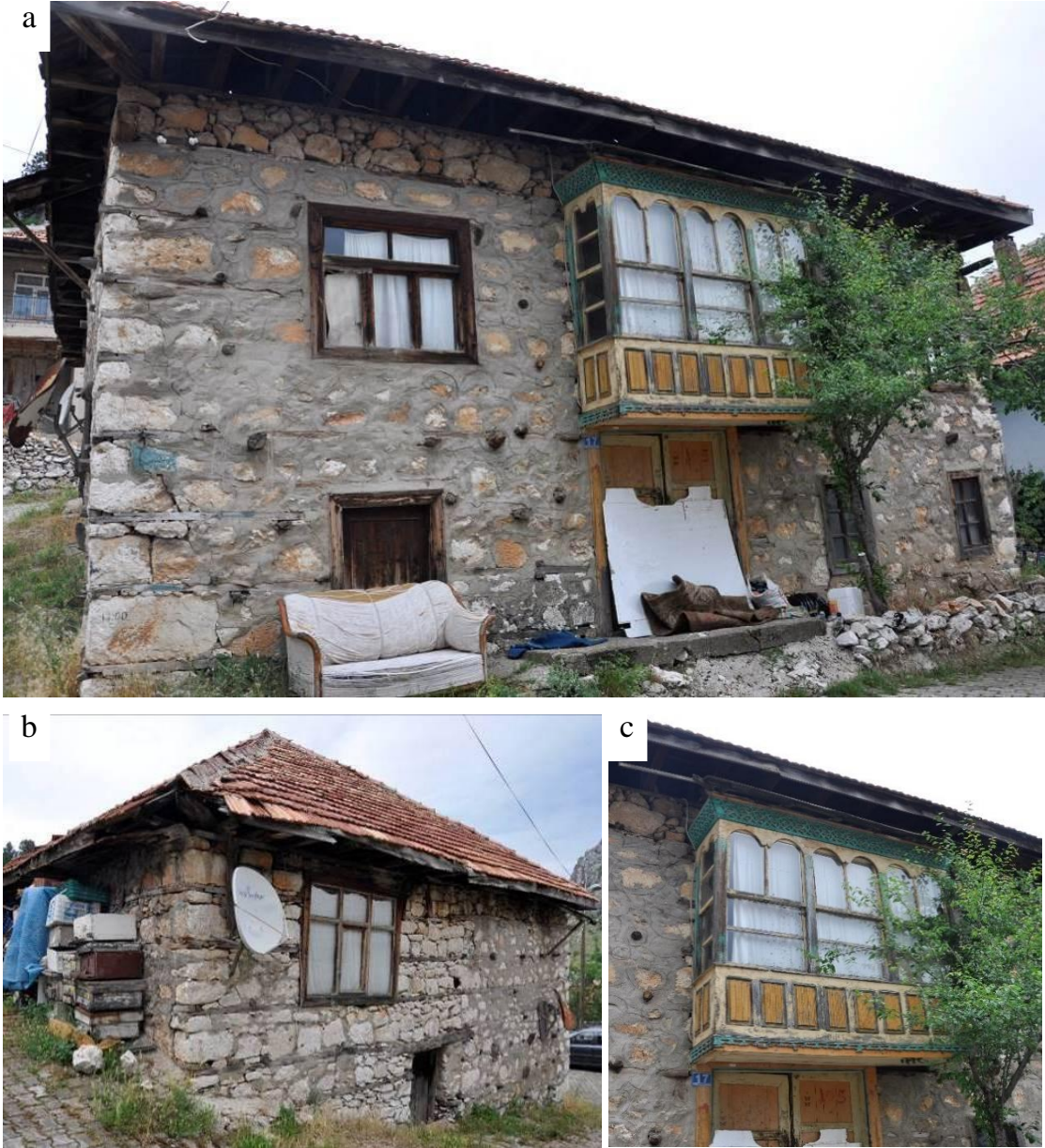
Şekil 6.1.27. 114 ada 56 parseldeki konut; a) kuzeydoğu (giriş) cephesi, b) güneydoğu cephesi, c) ahşap cumbası.
