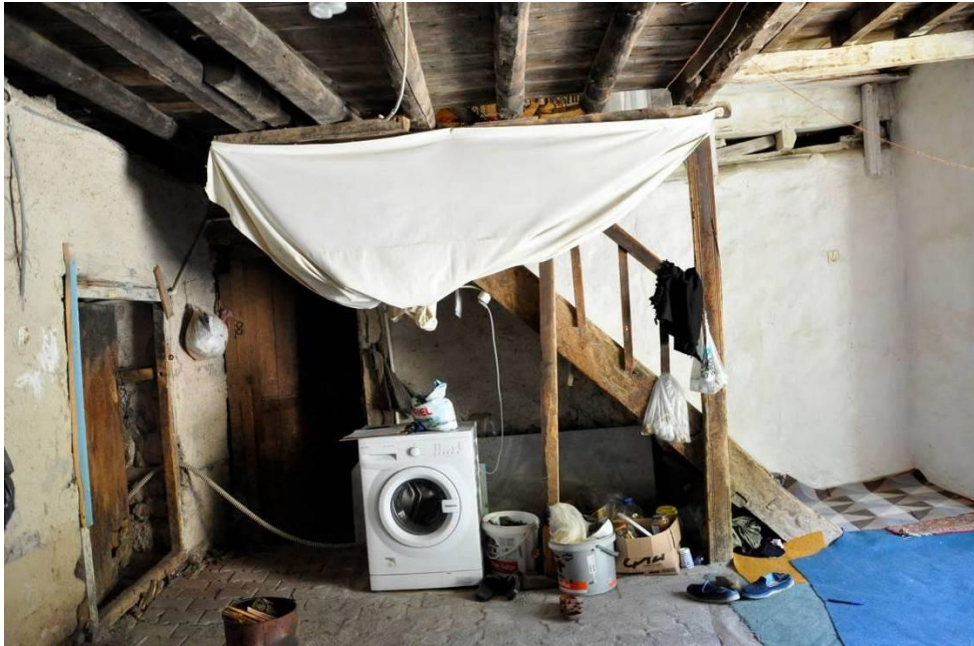
Şekil 5.5.5. Taşlığın kuzey duvarı
