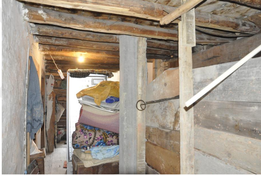
Şekil 5.1.13. Odunlukta bulunan betonarme kolon ve ahşap ayırıcılar
