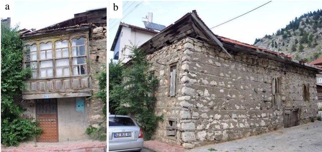
Şekil 6.1.12. 111 ada 2 parseldeki konut; a) ahşap cumbası, b) güney cephesi.
