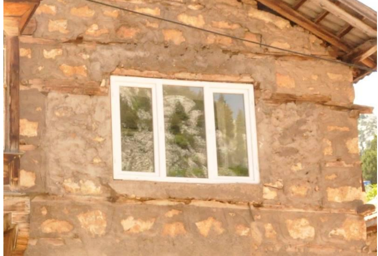
Şekil 5.6.17. Oda ( 1 04) Kapatılan pencere izleri
