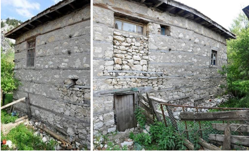
Şekil 5.5.41. D. Kırıcı evi kuzey cephesi
