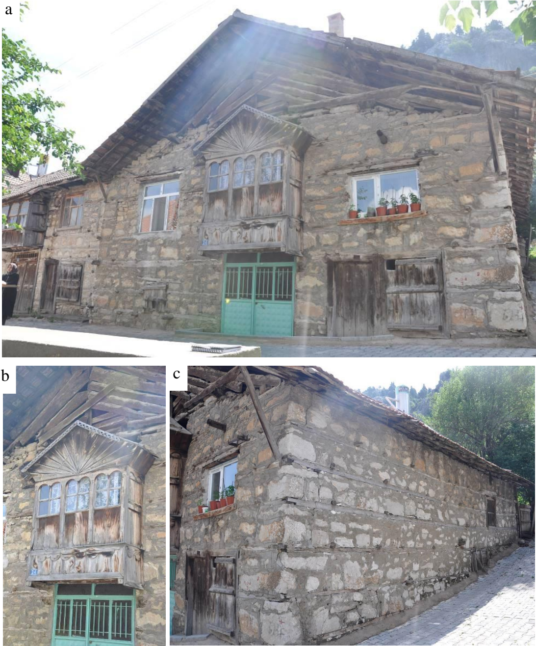
Şekil 6.1.4. 104 ada 38 parseldeki konut; a) kuzeybatı (giriş) cephesi, b) ahşap cumbası ve giriş kapısı, c) güneybatı cephesi.
