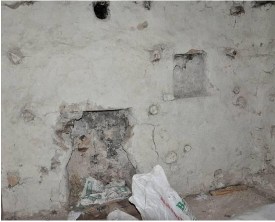
Şekil 5.3.13. Ocaklık ve duvar nişi
