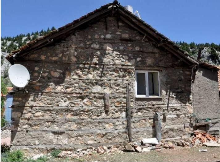
Şekil 5.6.25. Batı (arka) Cephesi
