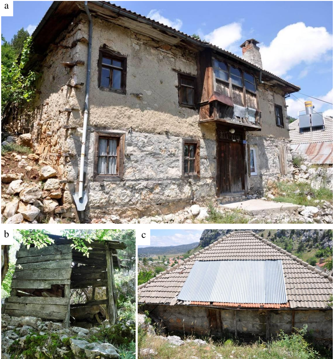
Şekil 6.1.47. 120 ada 6 parseldeki konut; a) kuzeydoğu (giriş) cephesi, b) ahşap hela, c) güneybatı cephesi.
