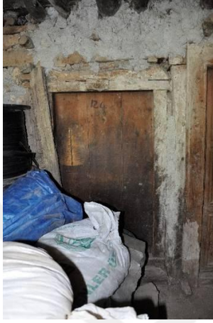
Şekil 5.4.8. Oda (Z 01) kapısı
