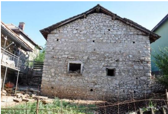
Şekil 4.40.208 ada 5 parseldeki taş ahır-samanlık
