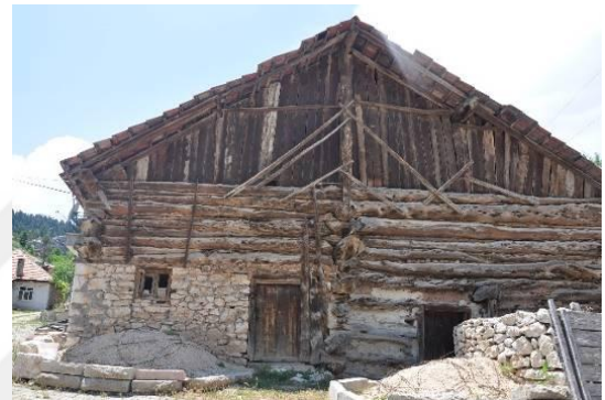
Şekil 4.39.120 ada 22 parseldeki samanlık
