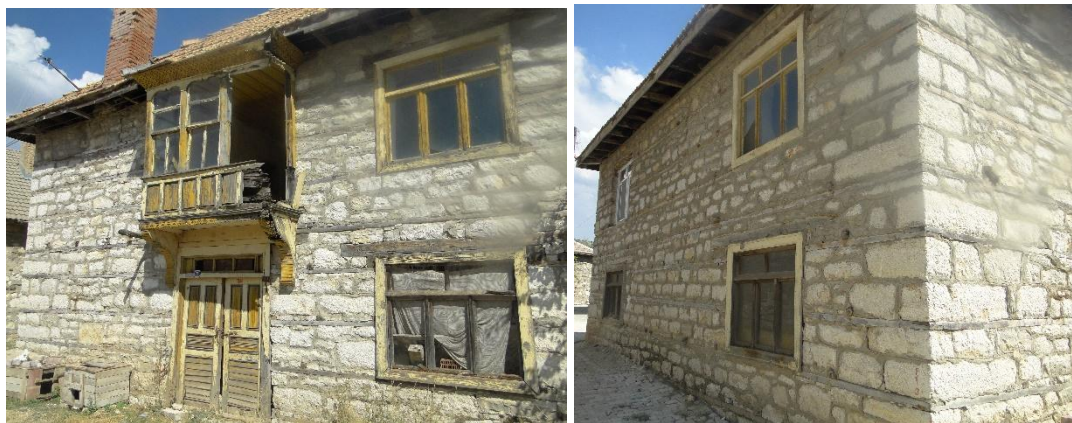
Şekil 6.2.45. Yeri tespit edilemeyen konut (Konya Büyükşehir Belediyesi,2014)
