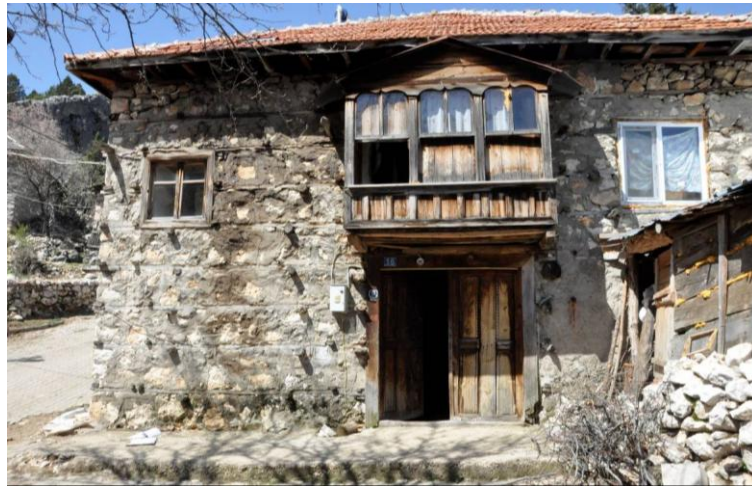
Şekil 5.7.25. H.Taşbaş evi doğu cephesi
