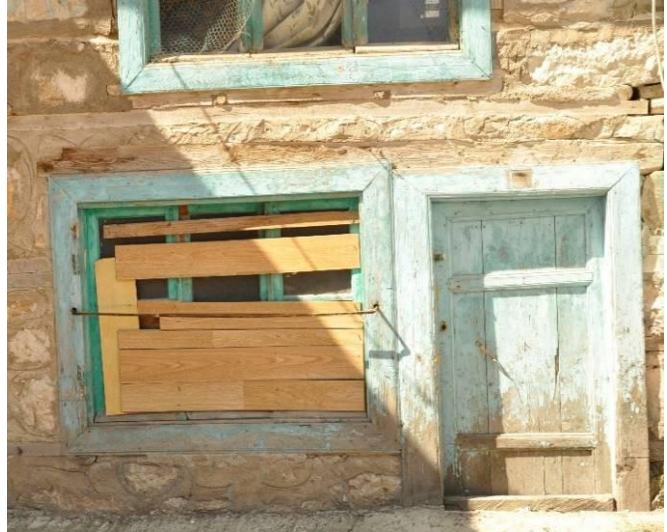
Şekil 5.2.14. Odanın (Z03) kuzeydoğudaki bağımsız girişi
