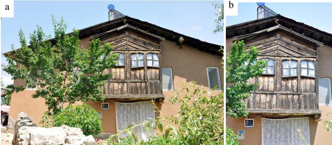
Şekil 6.2.25. 192 ada 3 parseldeki konut; a) batı (giriş) cephesi, b) ahşap rozetli cumbası.
