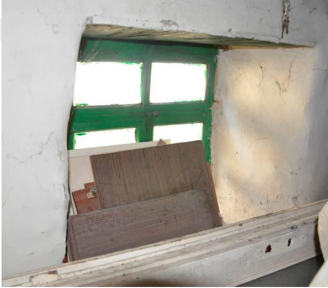
Şekil 5.4.26. Odanın kuzeydoğusundaki pencere
