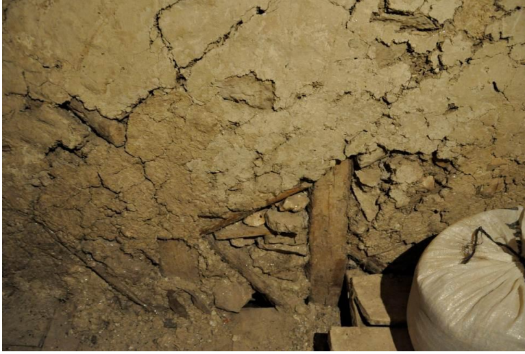
Şekil 5.4.44. Hımiş tekniği
