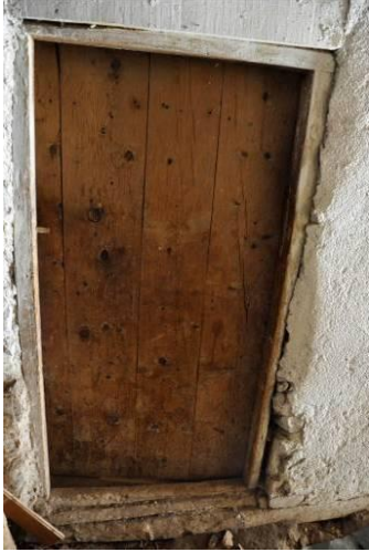
Şekil 5.6.9 Z 02 nolu oda kapısı
