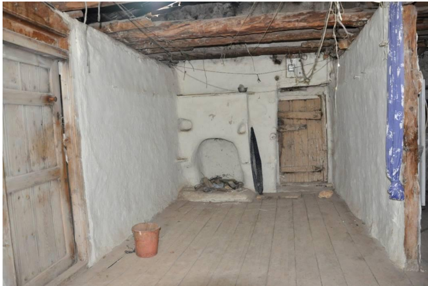
Şekil 5.3.22. Sofanın güneybatı duvarı
