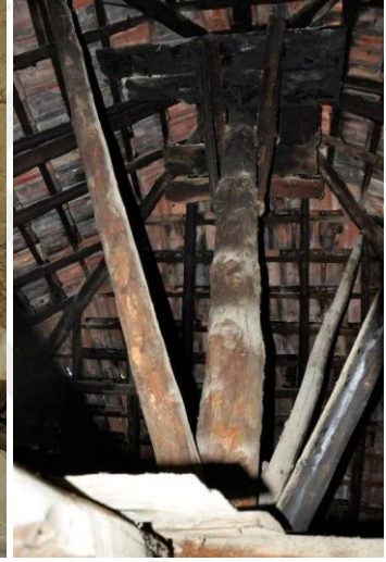
Şekil 5.4.45. Çatının ahşap taşıyıcıları
