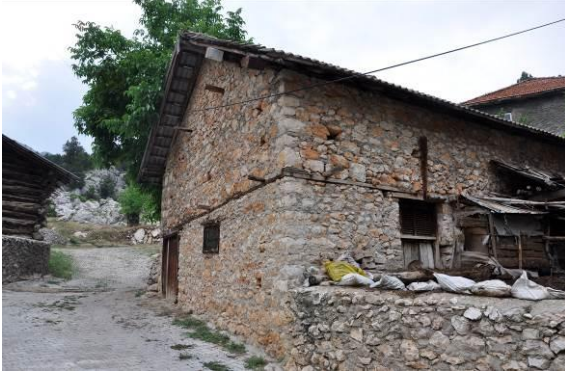
Şekil 4.42.114 ada 44 parseldeki taş ahır-samanlık
