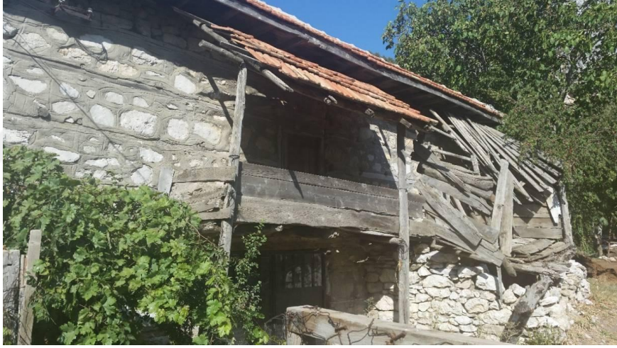
Şekil 5.4.38. Güneybatı cephesi (2014) (KBB, 2014)
