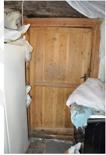
Şekil 5.7.10. Z 02 oda kapısı
