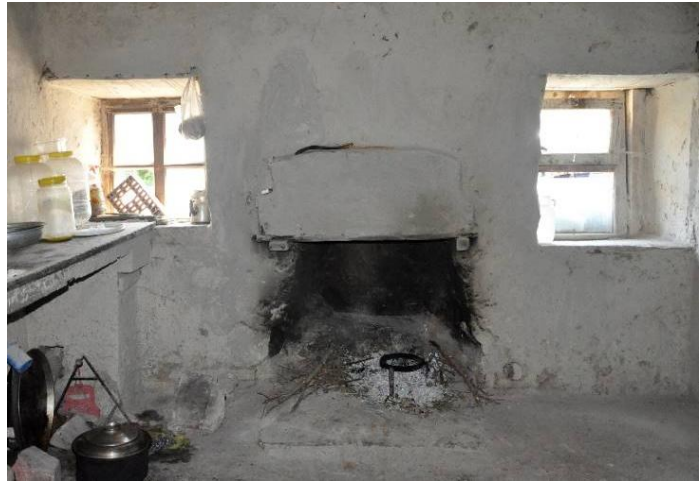
Şekil 5.2.8. Mutfak (Z01) ocaklık ve pencereleri
