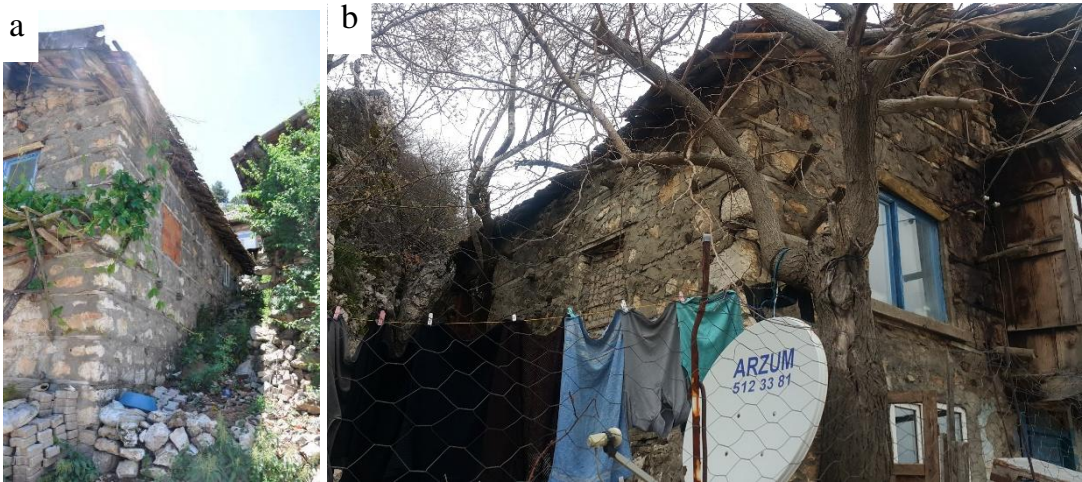
Şekil 6.1.57. Yan cepheler; a) kuzeybatı cephesi b) güneydoğu cephesi
