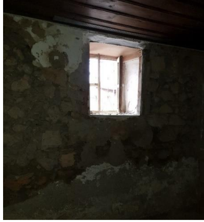
Şekil 4.4.19. Oda Z03 kuzey duvarı ve penceresi
