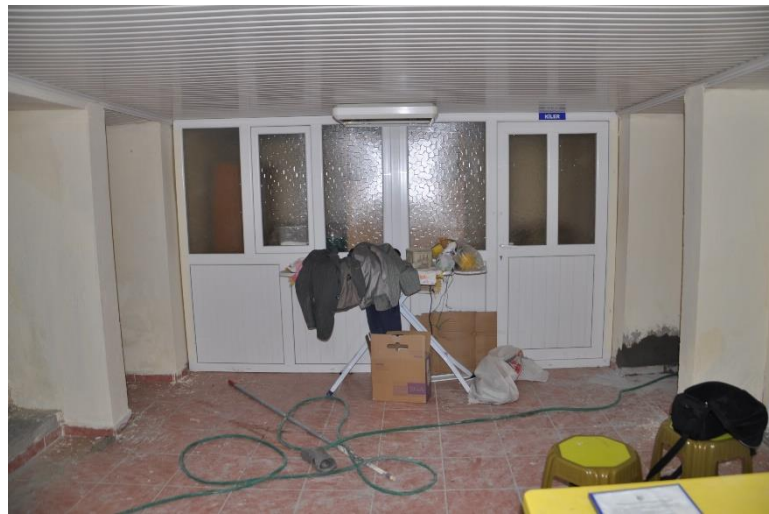
Şekil 4.8.11. Oda (B02) kiler giriş kapısı
