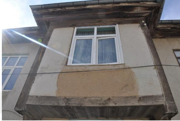
Şekil 4.7.52. Cumba altı ahşap kaplama
