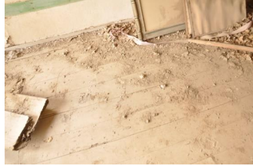
Şekil 4.5.49. Zemin ahşap döşeme
