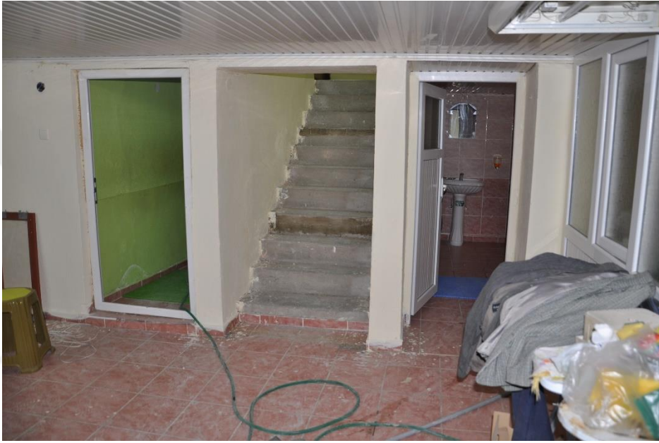
Şekil 4.8.13. Bodrum kat merdiveni
