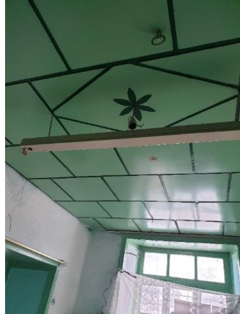
Şekil 4.7.56. Tavan kontraplak kaplaması
