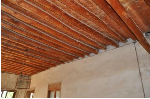
Şekil 4.5.48. Tavan ahşap kirişlemeler
