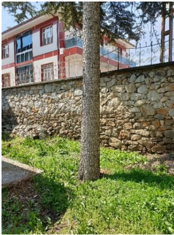
řekil 4.8.57. Yapıda tař kullanımı
