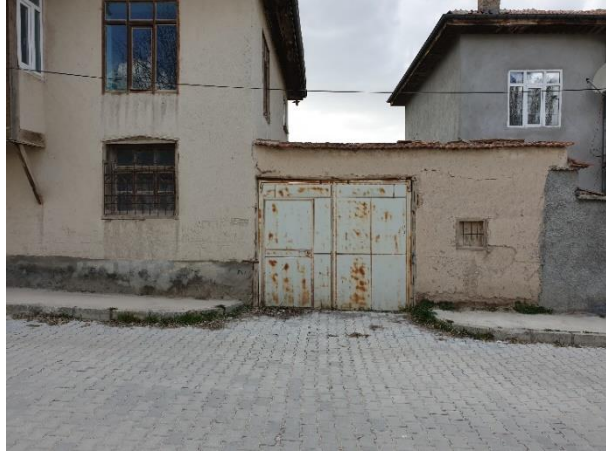
Şekil 4.7.58. Yapıda demir kullanımı
