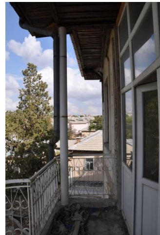
Şekil 4.8.37. Metal balkon korkuluk ve sütunlar
