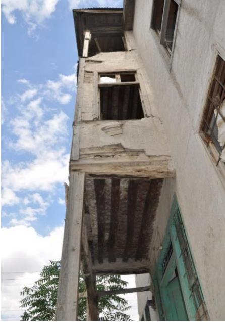
Şekil 4.5.46. Çıkma Altı Ahşap Kirişlemeler
