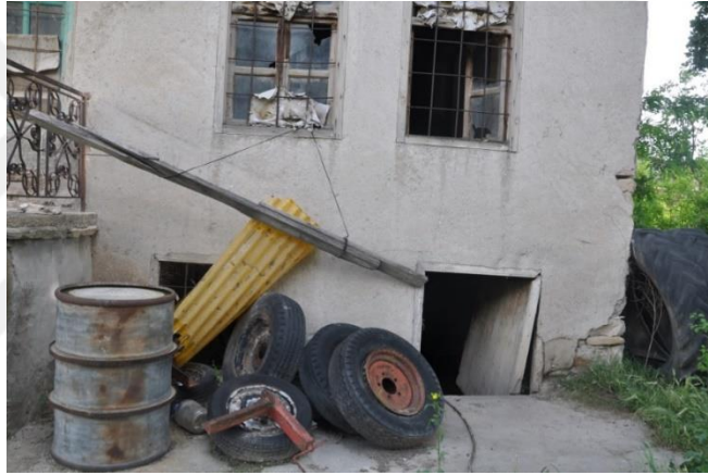
Şekil 4.5.4. Bodrum giriş kapısı ve penceresi
