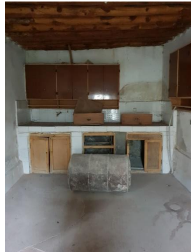
Şekil 4.4.26. Mutfak tezgah ve dolap
