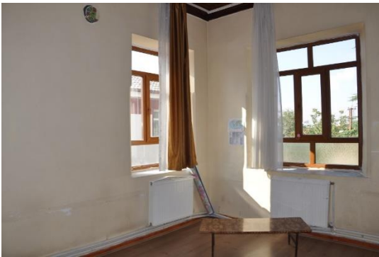
Şekil 4.8.43. Oda 104 pencereleri ve genel görünüş
