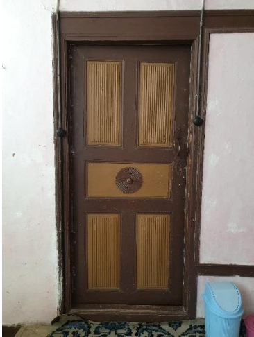
Şekil 4.6.22. Oda 102 giriş kapısı
