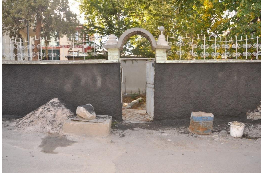
Şekil 4.8.4. Bahçe ikinci giriş kapısı
