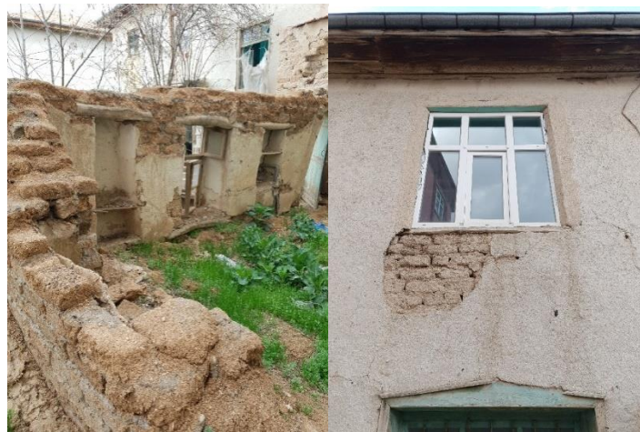
Şekil 4.7.53. Yapıda kerpiç kullanımı
