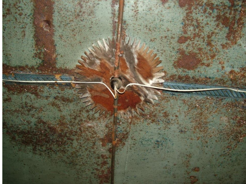
Şekil 4.3.26. Sac Tavan ve Ahşap Tavan Göbeği
