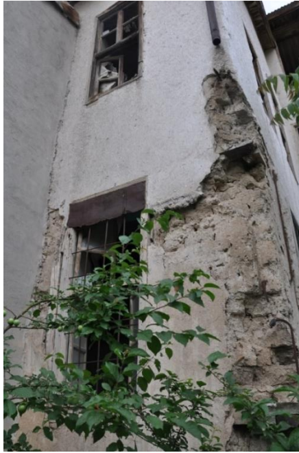
Şekil 4.5.44. Taş yığma, kerpiç yığma, ahşap hatıl
