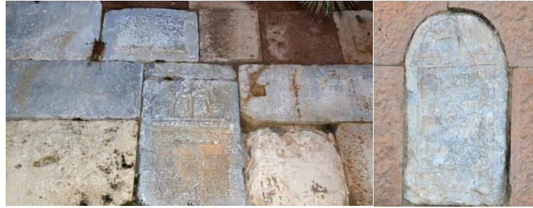
Şekil 3.2.1. Raziye Sultan Han duvarlarındaki devşirme malzemeler
