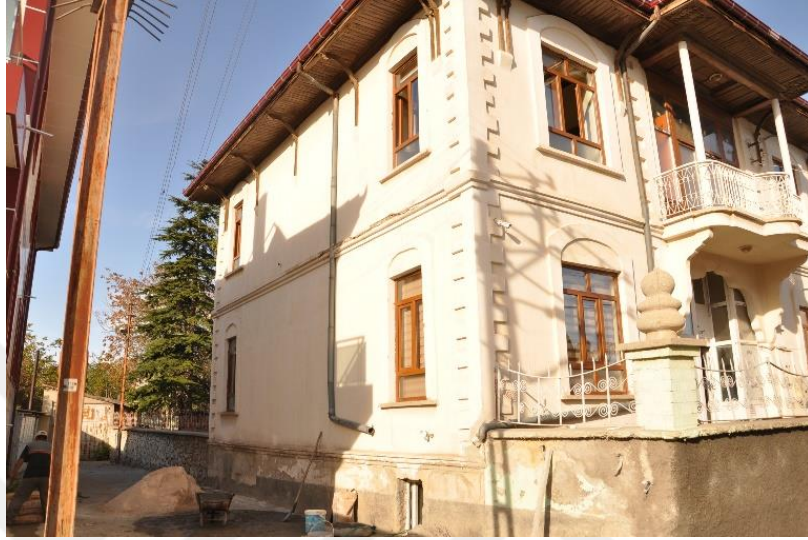
Şekil 4.8.53. Batı cephesi görünüş
