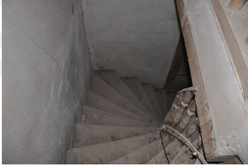
Şekil 4.5.18. Birinci kata ulaşımı sağlayan ahşap merdiven
