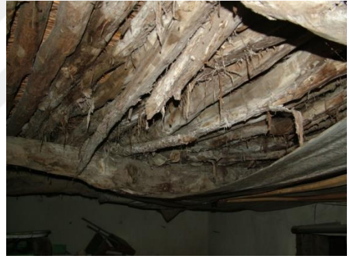
Şekil 4.3.41. Zemin kat ahşap kirişleme
