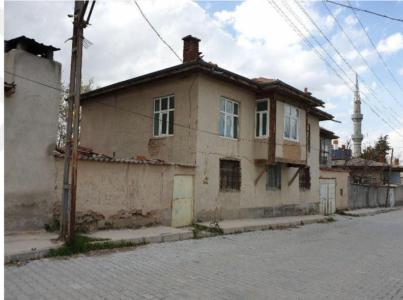
Şekil 4.7.49. Ev güney cephesi
