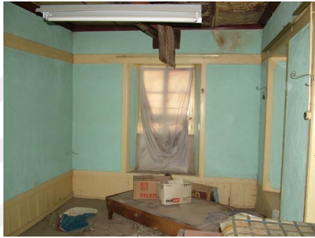
Şekil 4.3.23. Ahşap kaplama ve bordür
