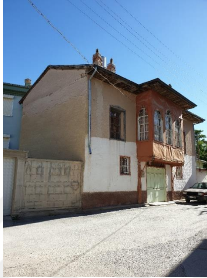
Şekil 4.6.37. Doğu cephesi görünüşü
