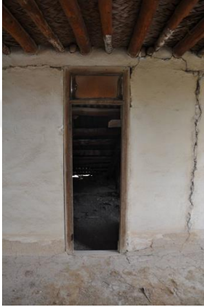
Şekil 4.5.37. Çatı arası giriş açıklığı
