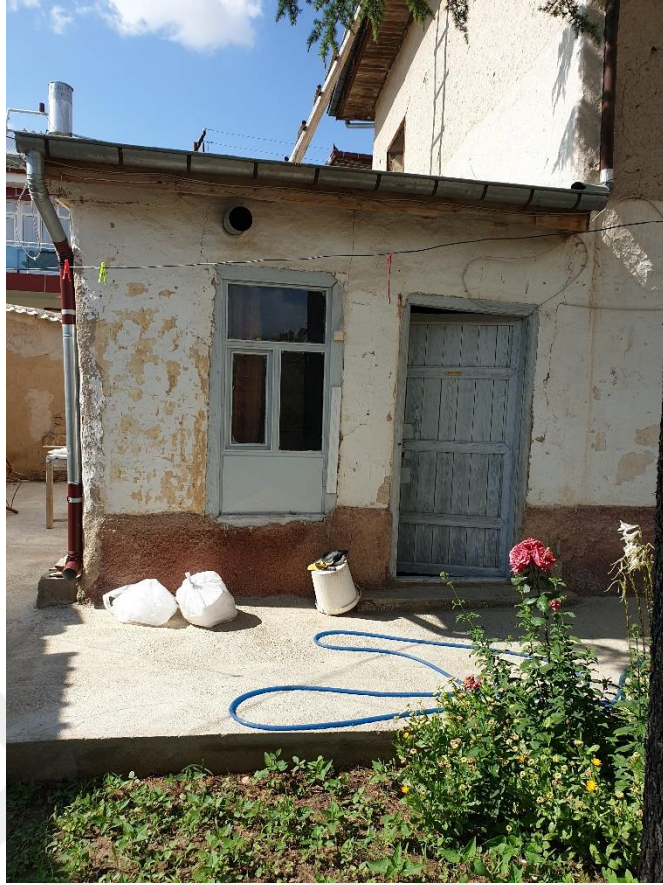
Şekil 4.6.29. Aşhane giriş kapısı
