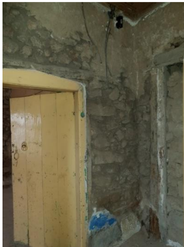
Şekil 4.4.14. Oda Z02 kapısı
