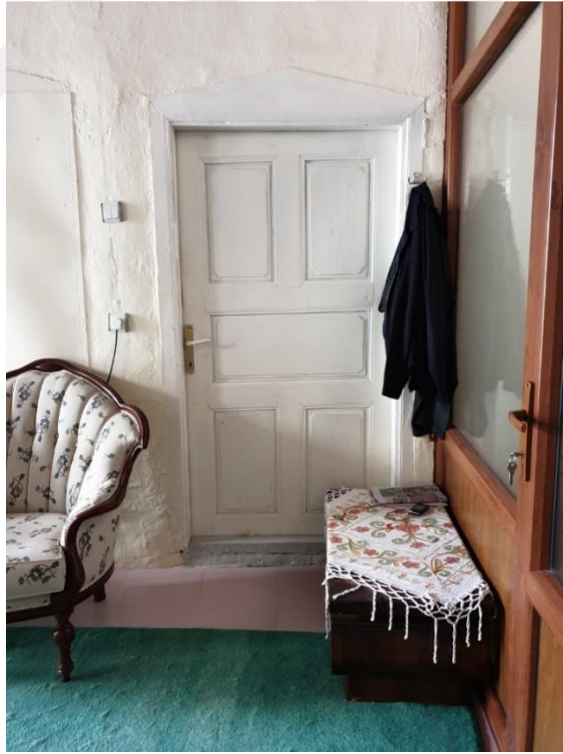
Şekil 4.6.7. Oda Z02 giriş kapısı
