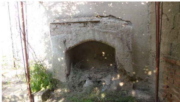
Şekil 4.3.39. Bahçede bulunan kerpiç ocak
