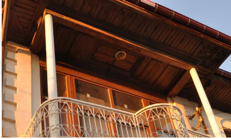
Şekil 4.8.35 Güney balkonu saçak
