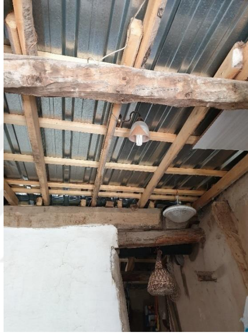
Şekil 4.6.34. Aşhane üst örtü
