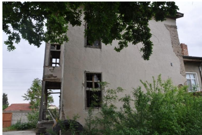
Şekil 4.5.40. Ali koçak evi batı (sağ yan) cephesi
