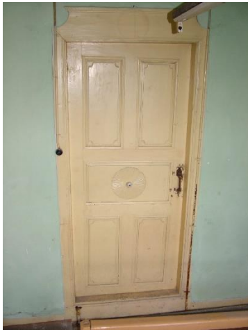
Şekil 4.3.19. Birinci kat GD oda kapısı
