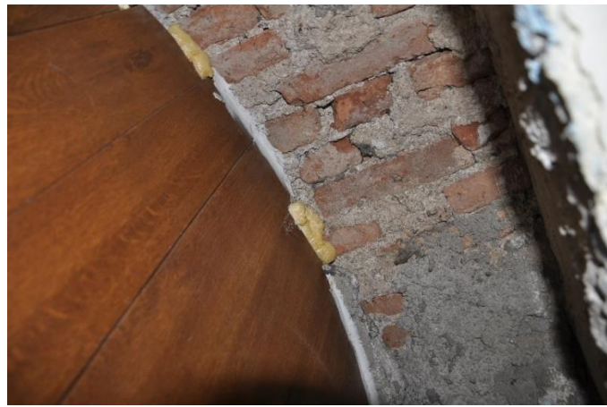
řekil 4.8.58. Yapıda ateř tuđlası kullanımı
