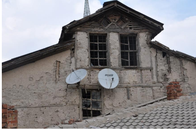
Şekil 4.5.43. Ahşap çatık tekniği ile süslenmiş üçgen çatı alınlığı
