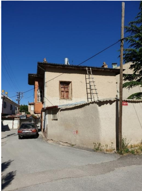
Şekil 4.6.38. Batı cephesi görünüşü
