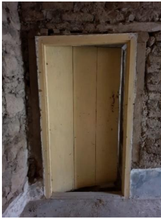
Şekil 4.4.17. Oda Z03 kapısı
