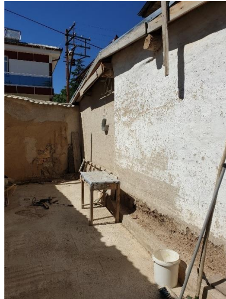
Şekil 4.6.39. Aşhane batı cephesi
