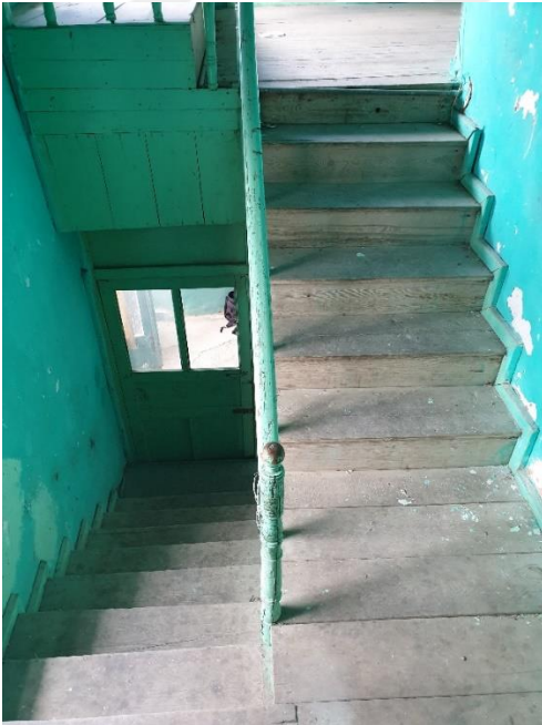
Şekil 4.7.22. Ahşap merdiven
