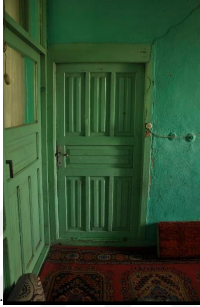
Şekil 4.7.31. Oda 104 Ahşap giriş kapısı
