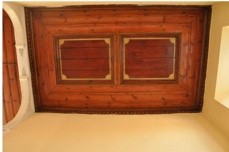
Şekil 4.8.30. Merdiven holü tavan
