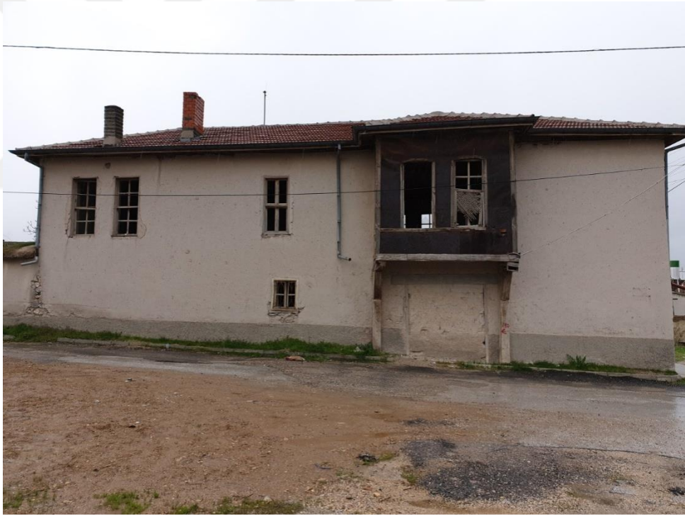
Şekil 4.4.49. Yumurtacılar evi kuzey cephesi
