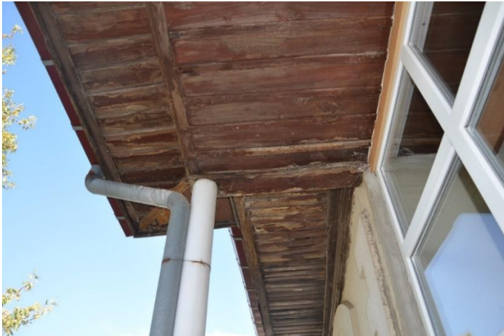
Şekil 4.8.36. Kuzey balkonu saçak
