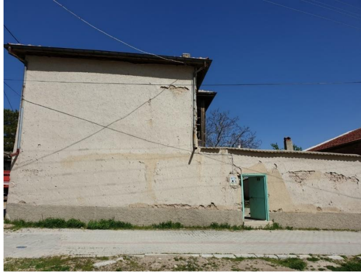
Şekil 4.4.50. Yumurtacılar evi batı cephesi
