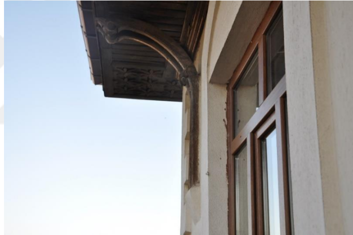
Şekil 4.8.49. Ahşap eliböğründeler
