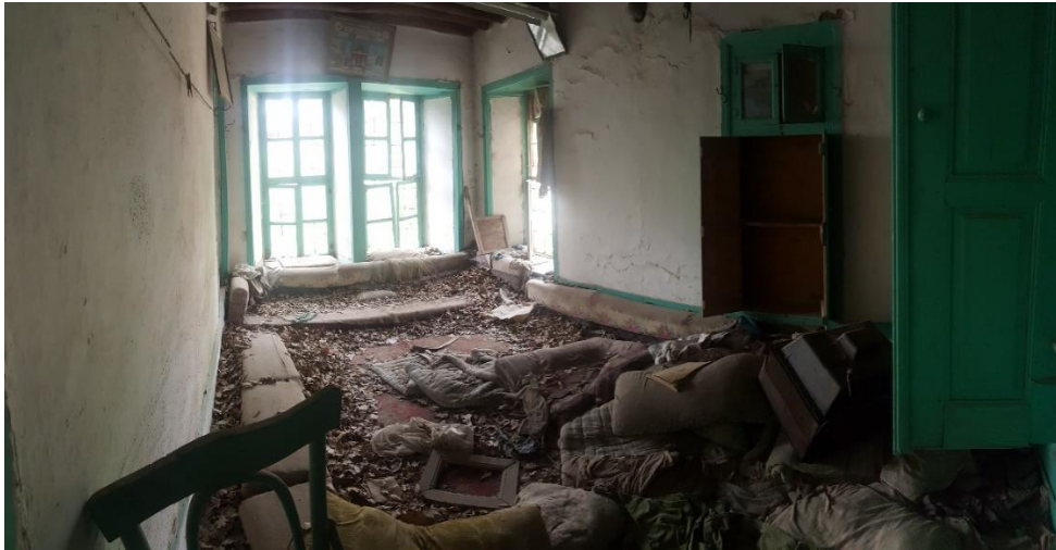
Şekil 4.5.17. Kuzeydoğu oda panoramik görünüşü
