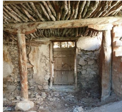
Şekil 4.4.8. Ahır dikme, kiriş ve üst örtü
