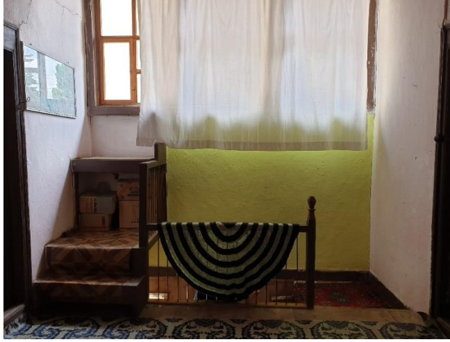
Şekil 4.6.19. Birinci kat sofa güney duvarı
