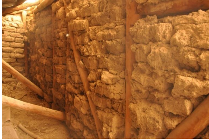
Şekil 4.5.45. Ahşap karkas arası kerpiç dolgu
