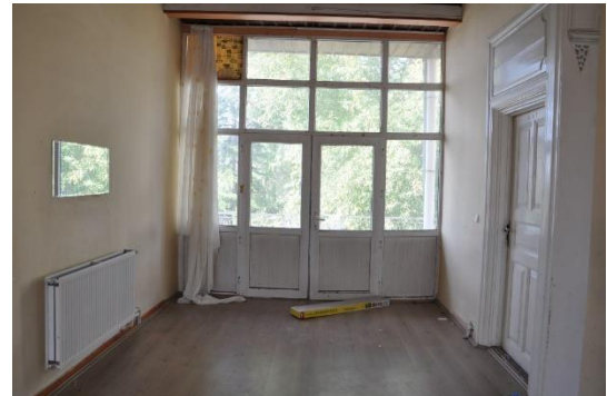
Şekil 4.8.33. Birinci kat kuzey balkonu kapısı
