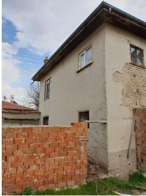
Şekil 4.7.51. Ev kuzey cephesi
