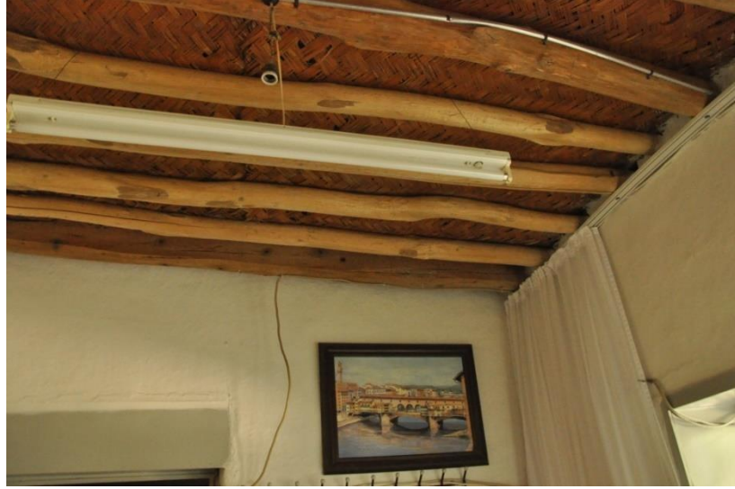
Şekil 4.2.14. Tavan ahşap kirişlemeleri
