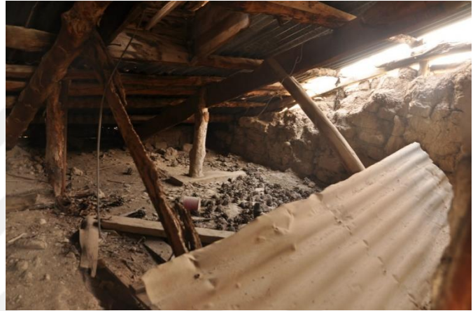
Şekil 4.5.38. Çatı aşık, mertek ve dikmeleri
