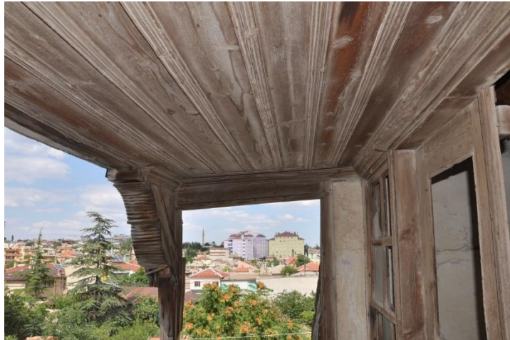
Şekil 4.5.34. Balkon tavan kaplaması, sütunlardaki perde motifi
