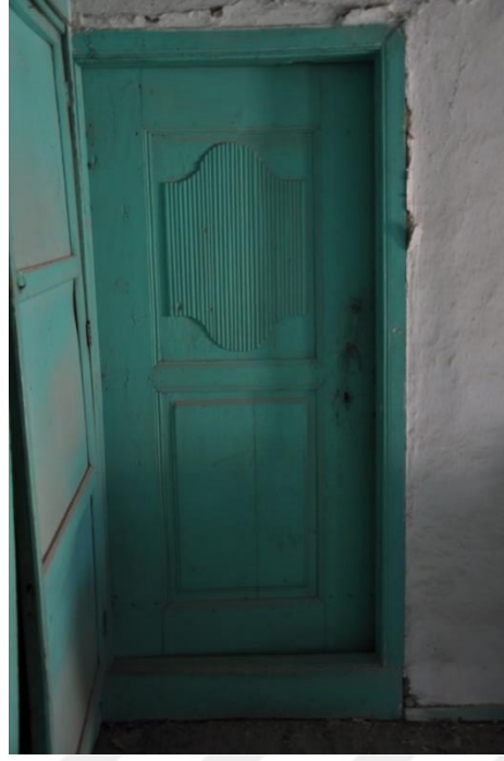
Şekil 4.5.11. Zemin kat kuzeybatı cepheli oda giriş kapısı
