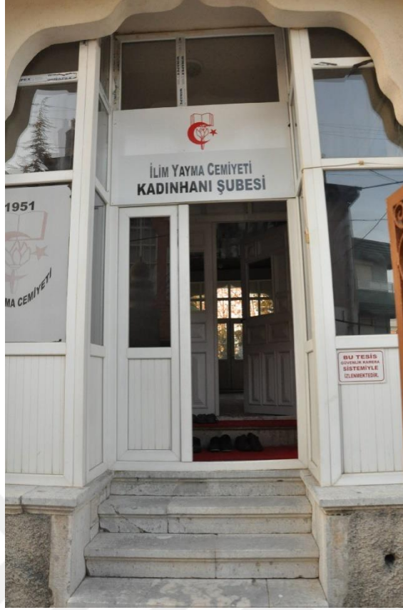
Şekil 4.8.14. Giriş sahanlığı merdiveni ve muhdes giriş kapısı
