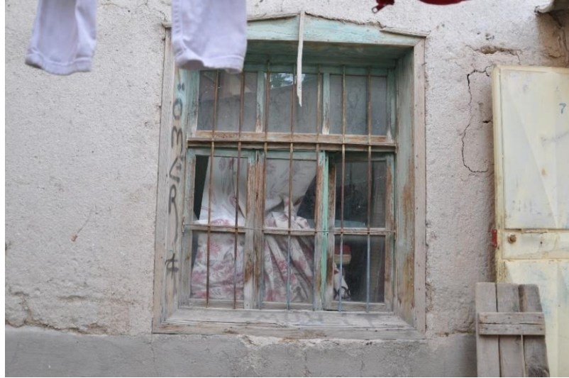
Şekil 4.7.48. Güney cephesi zemin kat penceresi
