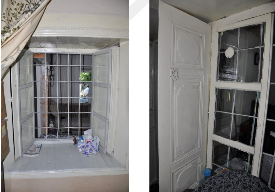
Şekil 4.2.11. Kuzeydoğu odası pencere ve kepenk
