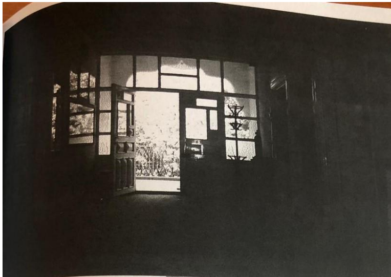
Şekil 4.8.20. Orijinal balkon kapısı (Hasan Maden Fotoğraf Arşivinden)
