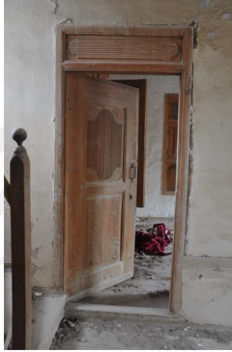
Şekil 4.5.24. Birinci kat kuzeybatı oda giriş kapısı
