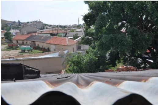
Şekil 4.5.50. Çatı kaplama malzemesi (Oluklu sac)
