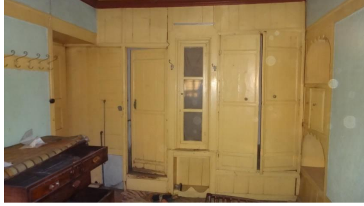
Şekil 4.3.21. Birinci kat güneydoğu odası ahşap dolap ve gusülhane
