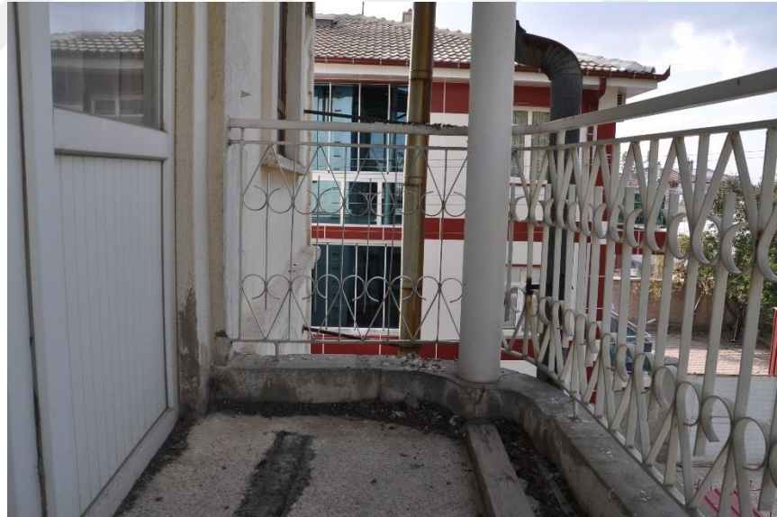
Şekil 4.8.60. Yapıda demir kullanımı
