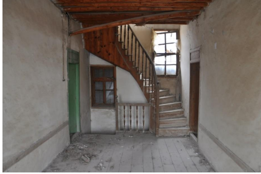
Şekil 4.5.20. İkinci kata ulaşımı sağlayan ahşap merdiven
