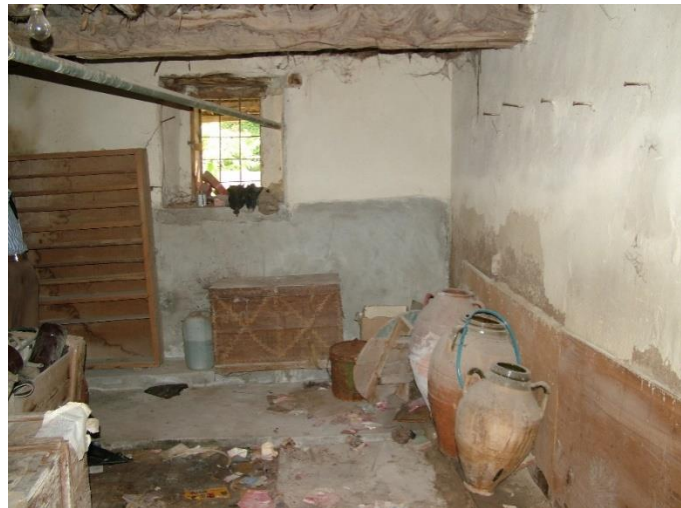
Şekil 4.3.14. Zemin kat güneybatı odası
