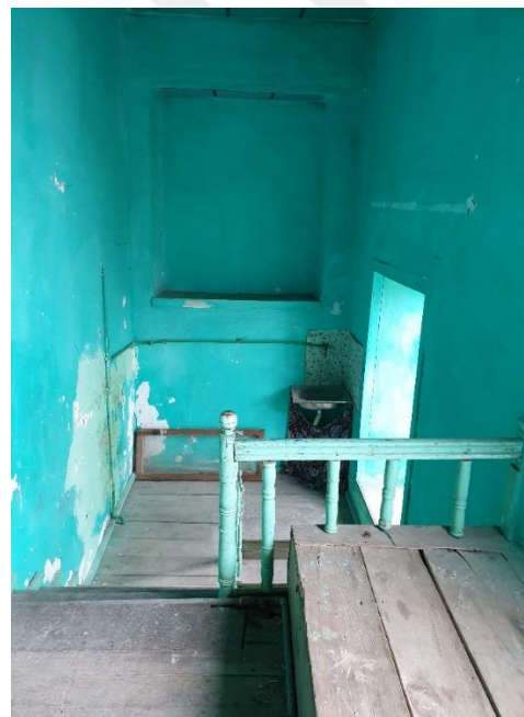
Şekil 4.7.23. Merdiven sahanlık pencereleri
