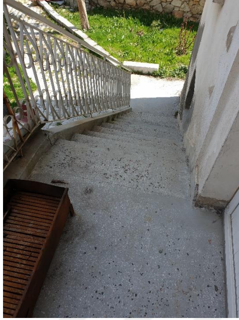
Şekil 4.8.21. Zemin kat kuzey balkon merdivenleri
