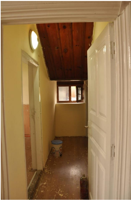
Şekil 4.8.26. Merdiven altı koridor
