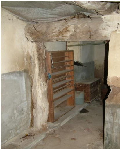
Şekil 4.3.13. Güneybatı odası giriş açıklığı
