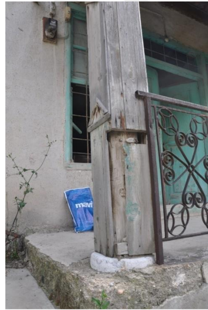
Şekil 4.5.47. Taş Kaidelere Oturan Ahşap Sütunlar
