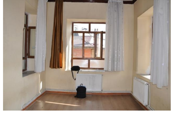
Şekil 4.8.41. Oda 103 pencereleri ve genel görünüş
