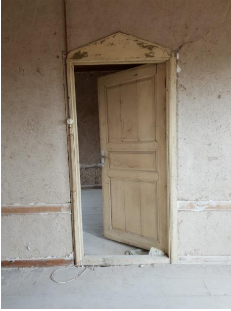
Şekil 4.4.32. Oda Z02 kapısı
