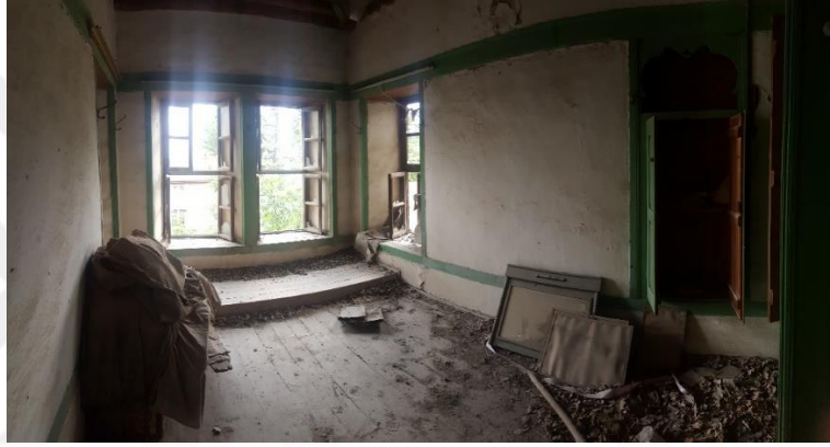
Şekil 4.5.2.31. Birinci kat kuzeydoğu oda panoramik görünüşü
