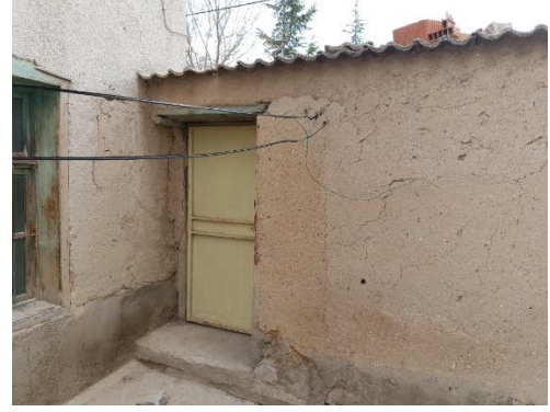
Şekil 4.7.4. Avlu-sokak kot farkı giriş kapısı
