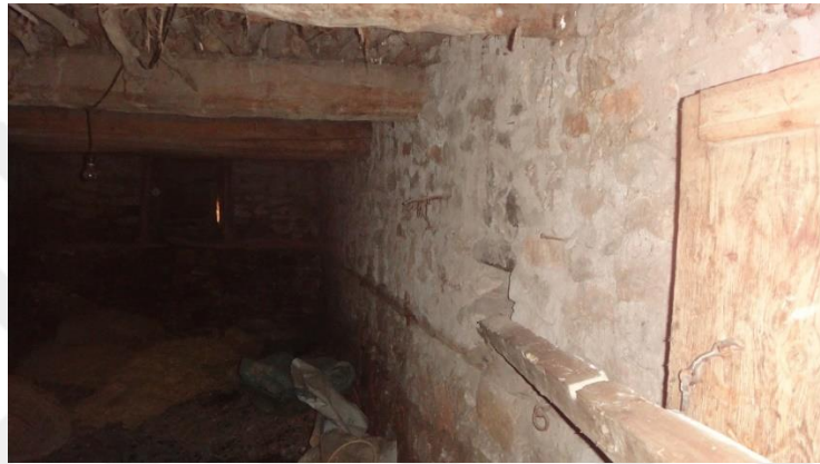
Şekil 4.3.12. Zemin kat kuzeydoğu odası
