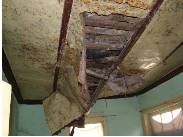
Şekil 4.3.18. Birinci kat güneydoğu odası sac tavan ve ahşap kirişler
