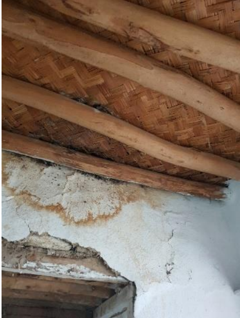
Şekil 4.7.55. Ahşap kirişlemeler
