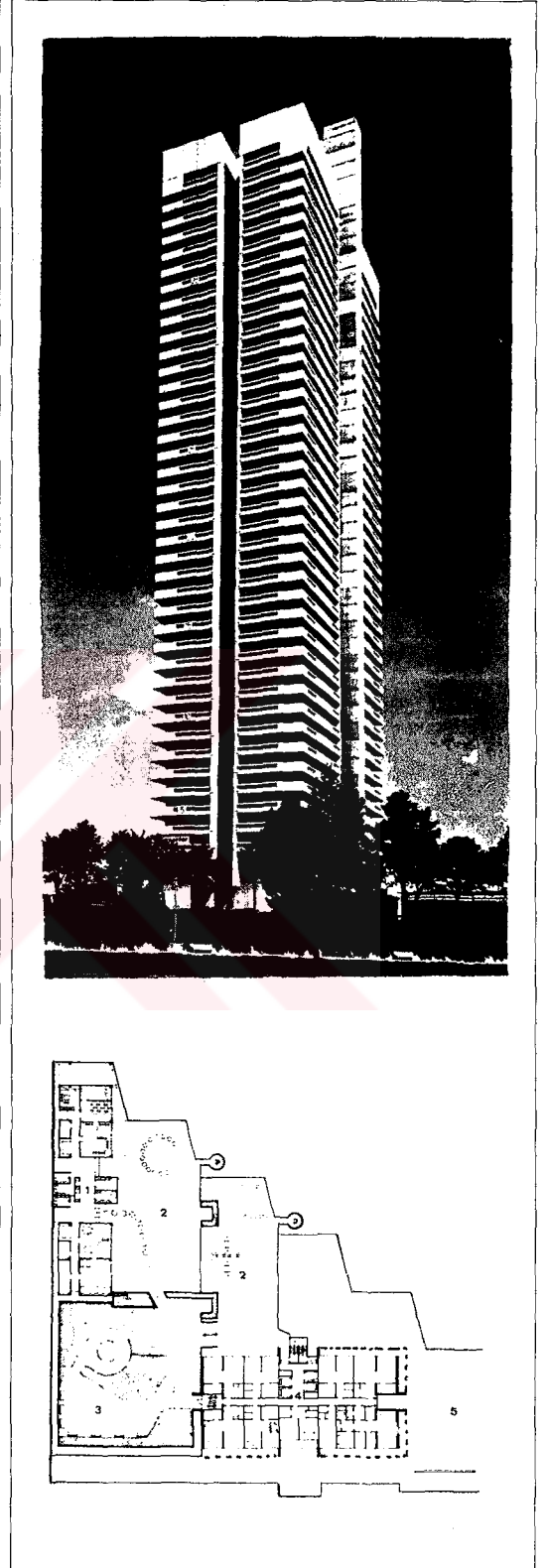
Şekil 2.36- Köln'de 42 katlı paralel taşıyıcı duvarlı komut yapısı
