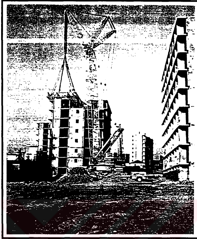
Şekil 2.107- Katlanmış betonarme plak kaldırma sisteminde kullanılan özel vinç
