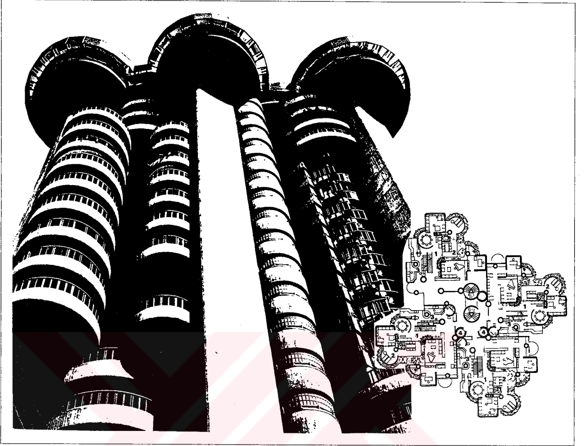
Şekil 2.41- Madrid'te taşıyıcı duvarlı ve çekirdekli komut bloğu
