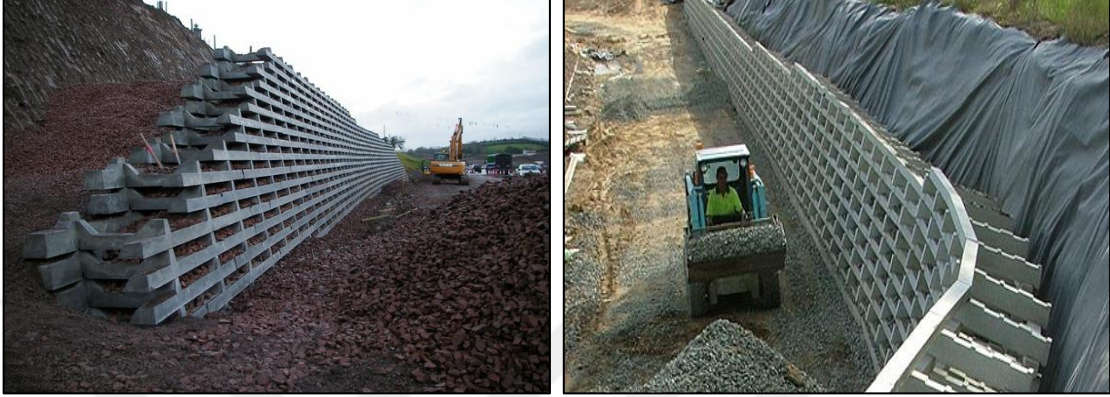
Şekil 3.6 Kafes duvarın yapısı ( https://quadrangularisms.wordpress.com )
