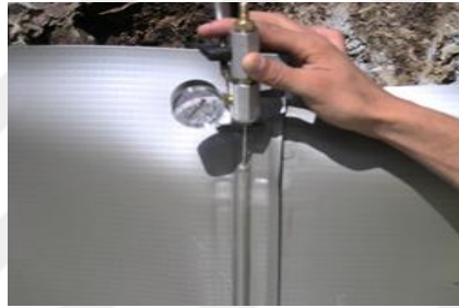
Şekil 3.50 Geomembran birleşimlerinin basınçlı hava ile test edilmesi
