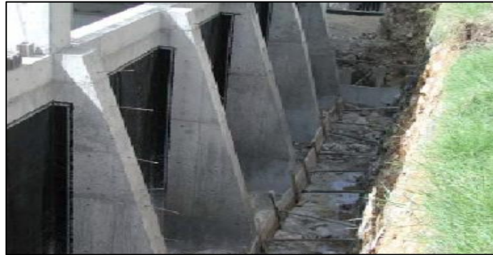
Şekil 3.14 Betonarme nervürlü istinat duvarı (www.istinatduvari.com, https://quadrangularisms.wordpress.com ).
