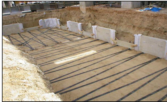
Şekil 3.9 Mekanik şerit donatılı toprakarme istinat duvarı http://www.linearcomposites.com/ap_reinforce_soil.htm
