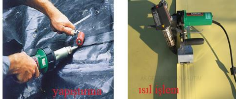
Şekil 3.49 Geomembranın ısıl işlem ve yapıştırma ile birleşimi (www.pvcgeomembranyalitimi.com)
