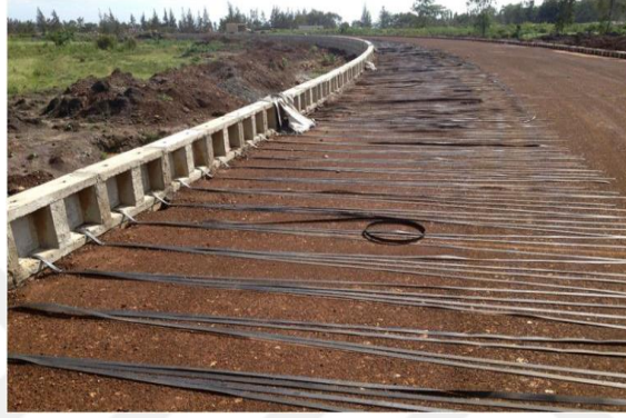
Şekil 3.60 Kenya'da inşa halinde olan modüler bir beton blok duvar sistemi ( https://constructionreviewonline.com/2015/08/mechanically-stabilised-earth/ )
