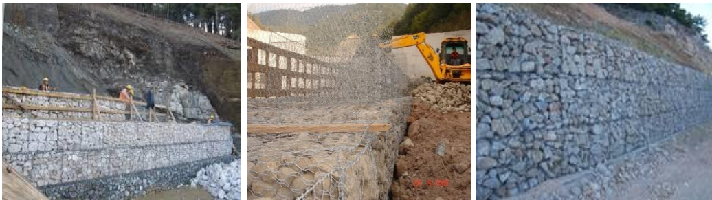
Şekil 3.5 Gabion duvar uygulaması, http://www.cinarinsaat.com.tr/project-122-gabion-wall.html , http://www.kiciman.com/uploads/icerikresim/6.jpg
