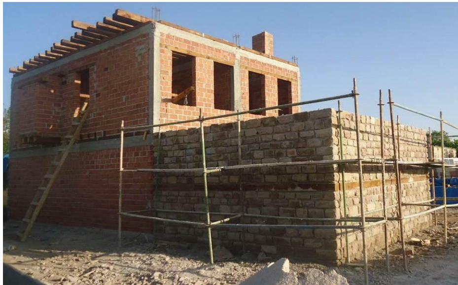
Şekil 5.7.6.4. Yapıda yeni malzeme kullanımı (KUDEB arşivi)
