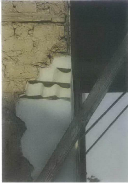
Şekil 5.1.5.2. Güneybatı köşedeki perdah (Rölöve raporu- DKN Mimarlık)
