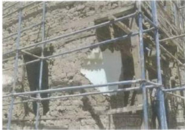
Şekil 5.1.6.5. Yapının raspa sonrası durumu
