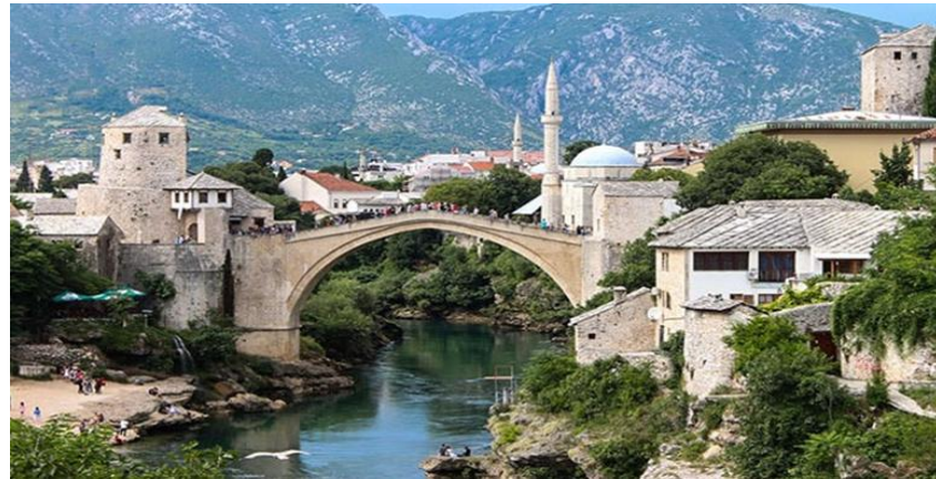
Şekil 3.2.1.7. Rekonstrüksiyon sonrası Mostar Köprüsü (Anonim, 2018)
