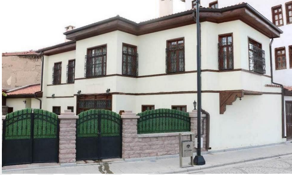
Şekil 5.4.7.1. Yapının güncel hali
