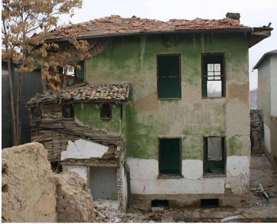
Şekil 5.2.4.5. Yapının batı cephesi ve muhdes mekânlar (KBB arşivi)
