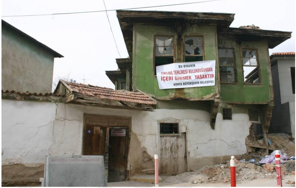
Şekil 5.2.2.3. Yapının doğu cephesi (KBB arşivi)
