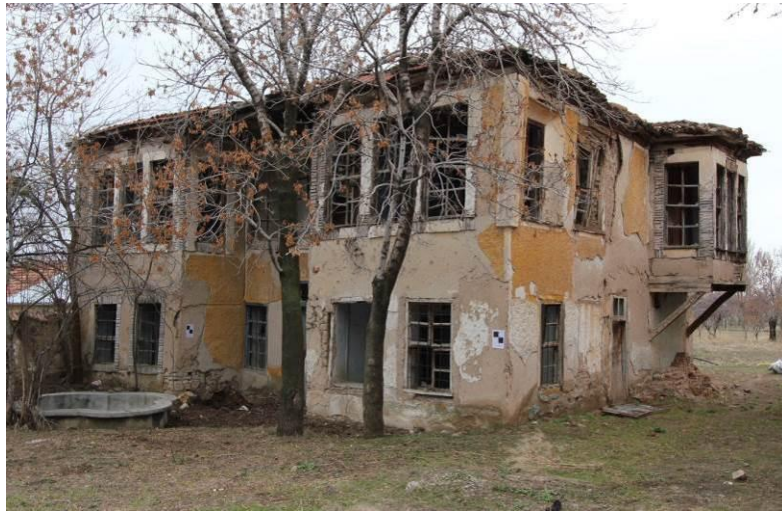
Şekil 5.8.2.2. Yapının eski hali (Rölöve raporu-Mostar Mimarlık)
