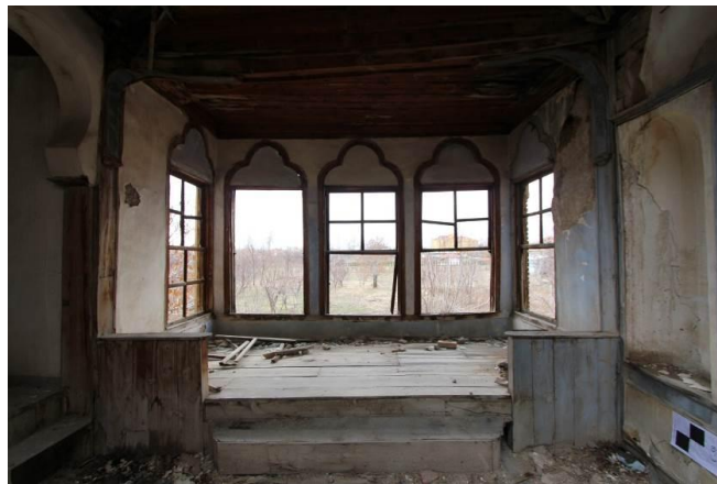
Şekil 5.8.5.2. Yapının birinci kat sofasında bulunan şahnişin (Rölöve raporu- Mostar Mimarlık)
