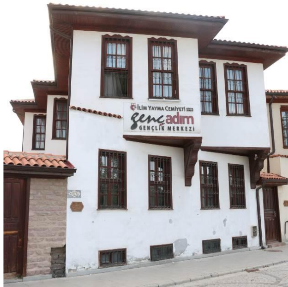
Şekil 5.2.7.1. Yapının güncel hali
