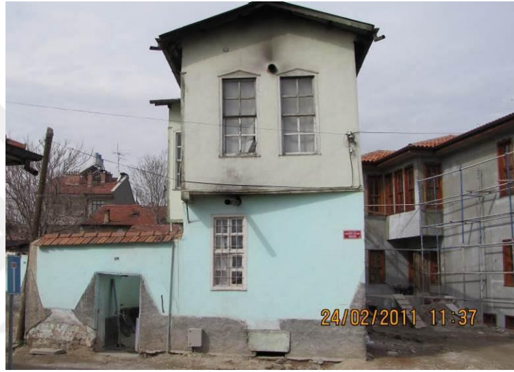
Şekil 5.1.2.1. Yapının doğu cephesinden eski fotoğrafında görülen avlu girişi (KUDEB arşivi)
