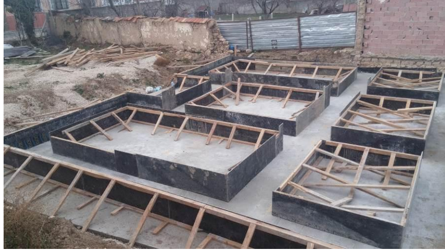
Şekil 5.8.6.6. Yapının temelinde betonarme kullanımı (KBB arşivi)
