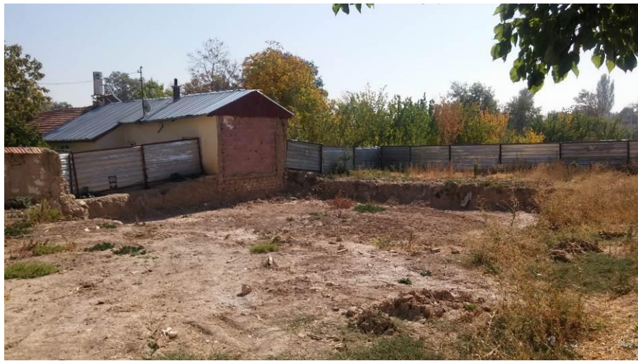
Şekil 5.8.6.5. Yapının yıkılmış hali (KBB arşivi)
