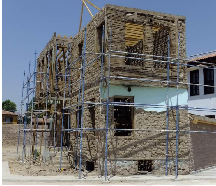
Şekil 5.1.3.2. Yapının söküm aşamasında görülen özgün strüktürel sistemi (KBB arşivi)
