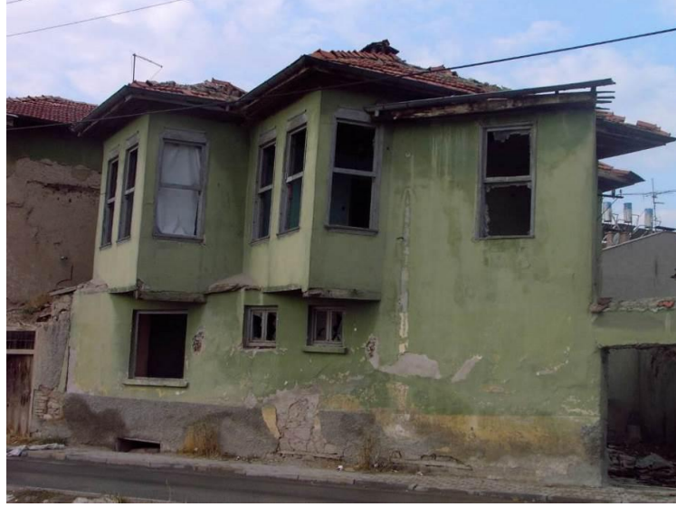
Şekil 5.5.3.1. Yapının eski hali (Rölöve raporu-Ramazan Demir Mimarlık)
