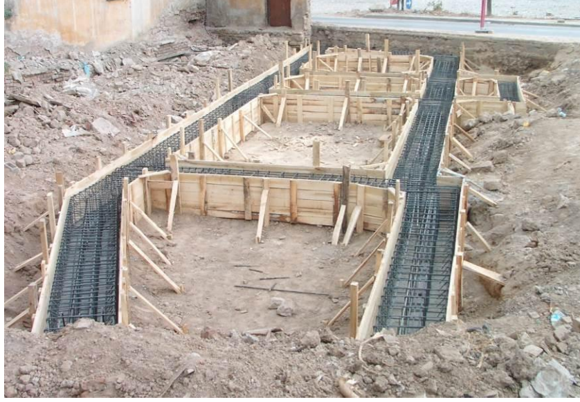
Şekil 5.4.6.8. Yapının betonarme temeli (KBB arşivi)
