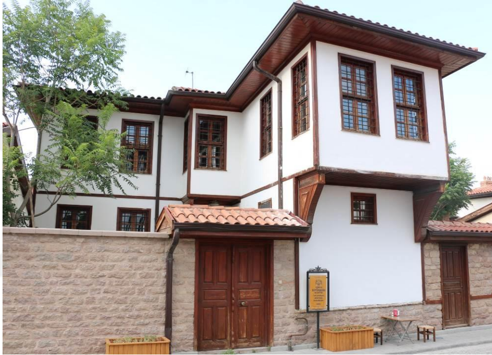
Şekil 5.3.7.1. Yapının güncel hali
