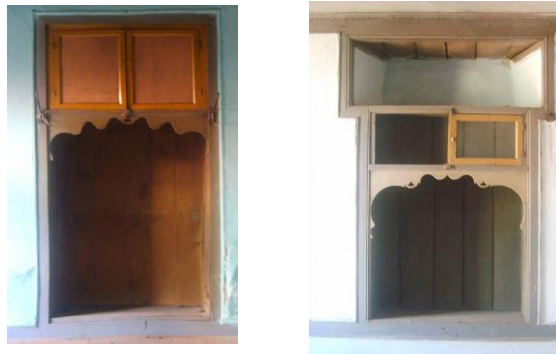
Şekil 5.4.5.1. Odalarda bulunan ahşap ağızlı açıklar (Rölöve raporu-Ramazan Demir Mimarlık)
