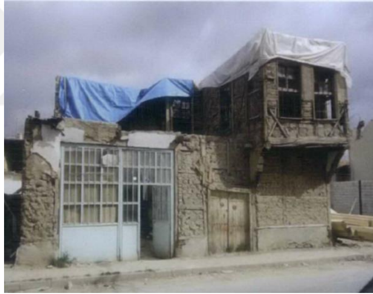
Şekil 5.3.2.1. Yapının güney cephesinden eski fotoğrafı (Rölöve raporu)
