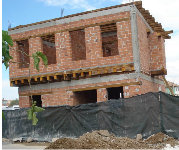
Şekil 5.7.6.3. Yapıda yeni malzeme kullanımı (KUDEB arşivi)
