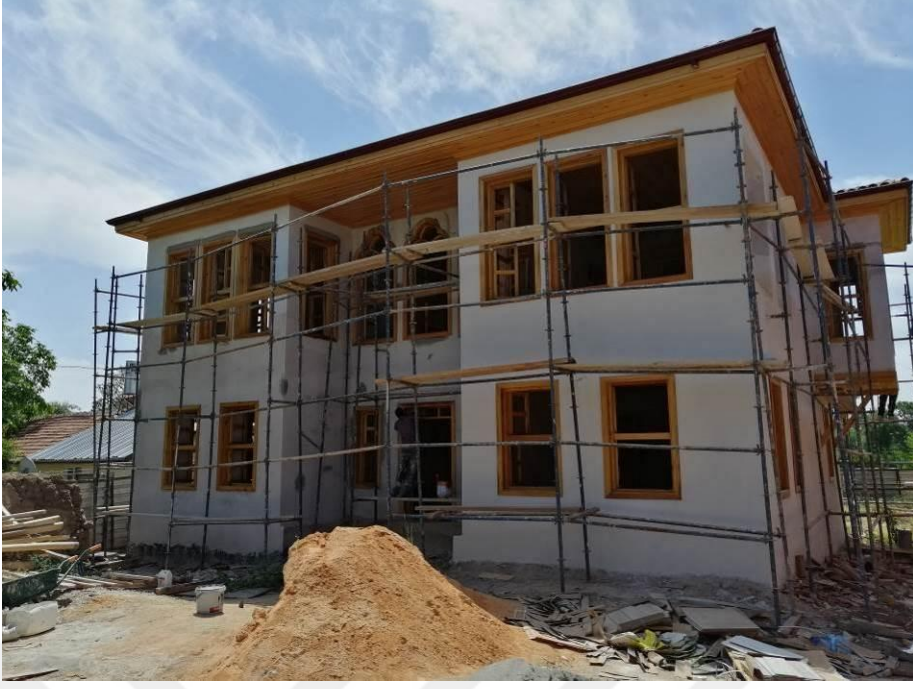
Şekil 5.8.7.1. Yapının yeni malzeme kullanımı (KBB arşivi)
