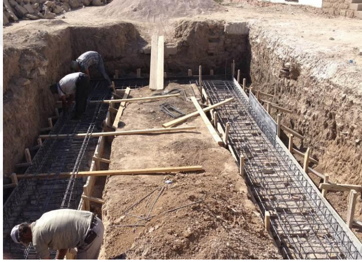
Şekil 5.1.6.10. Yapının rekonstrüksiyonu esnasında temel inşası (KBB arşivi)
