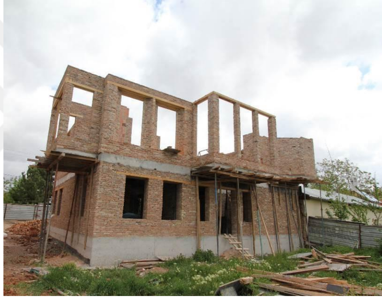
Şekil 5.8.6.7. Yapının yeni malzeme kullanımı (KBB arşivi)
