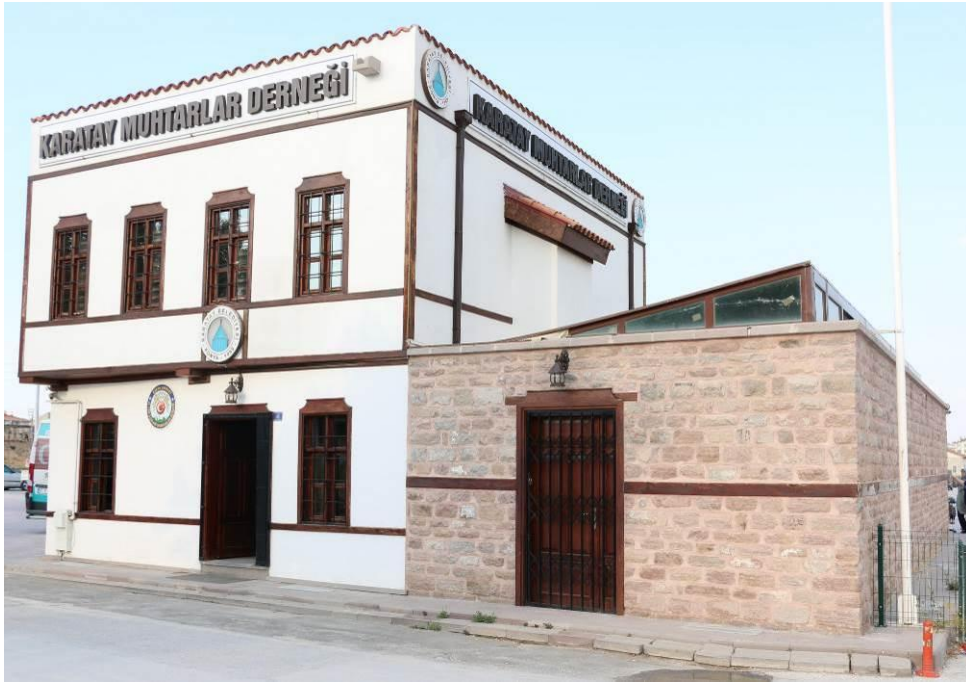
Şekil 5.7.7.2. Yapının güncel hali
