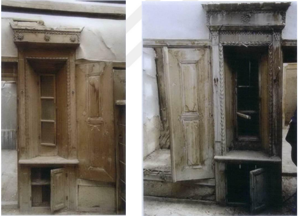
Şekil 5.3.5.1. Odalarda bulunan benzer karakterde ahşap dolap ve yüklükler ( Rölöve raporu- DKN Mimarlık )
