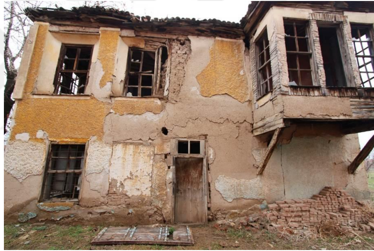
Şekil 5.8.3.1. Yapının özgün malzemesi (Rölöve raporu- Mostar Mimarlık)
