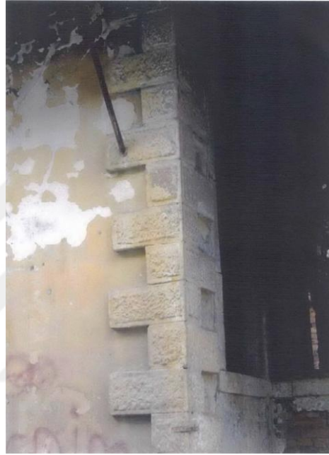
Şekil 5.6.5.1. Yapının duvarlarında köşe taşı birleşimi
