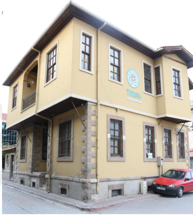
Şekil 5.6.7.1. Yapının güncel hali
