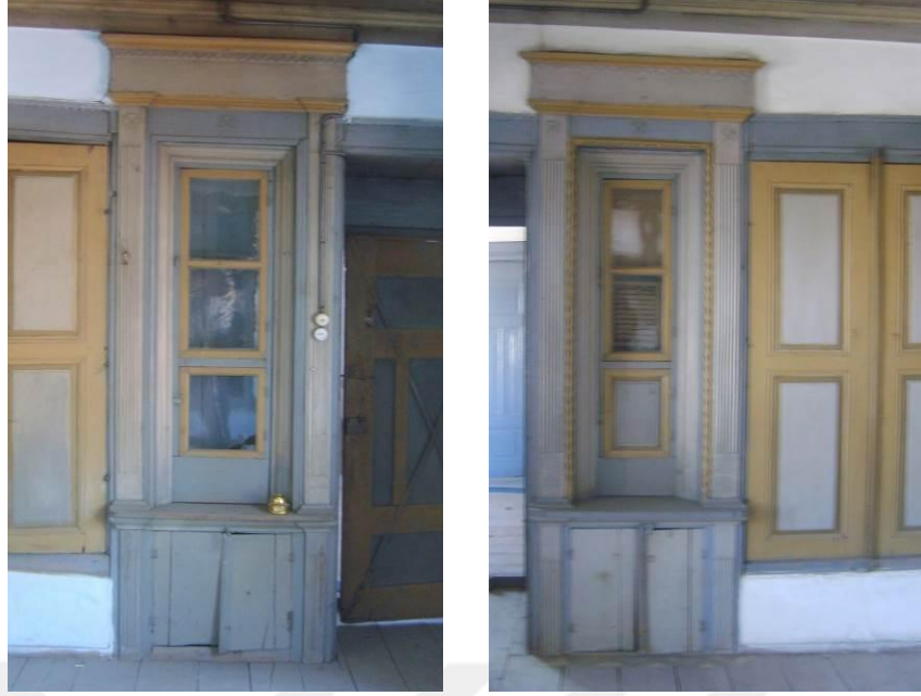
Şekil 5.4.5.2. Odalarda bulunan ahşap dolap ve yüklükler (Rölöve raporu -Ramazan Demir Mimarlık)
