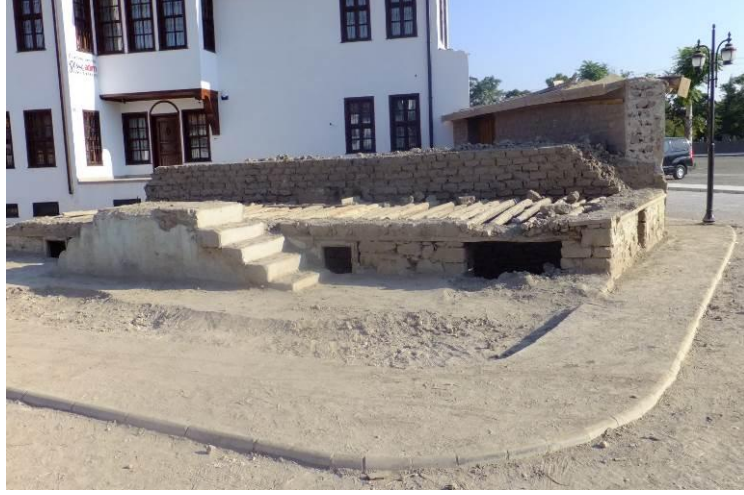
Şekil 5.1.6.9. Yapının yıkımı (KBB arşivi)
