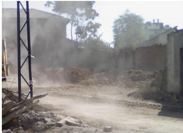
Şekil 5.4.6.7. Yapının yıkımı (KBB arşivi)
