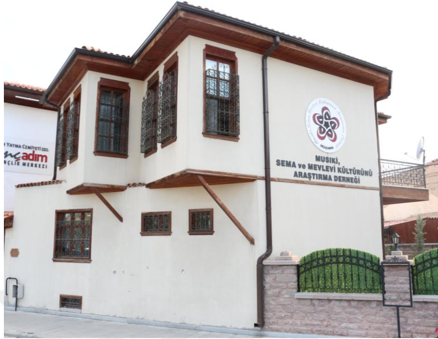
Şekil 5.5.7.1. Yapının güncel hali
