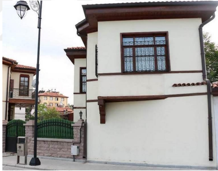
Şekil 5.4.7.2. Yapının güncel hali
