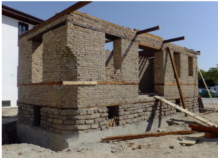
Şekil 5.1.6.11. Yapının rekonstrüksiyonu esnasında bodrum ve zemin kat inşası (KBB arşivi)
