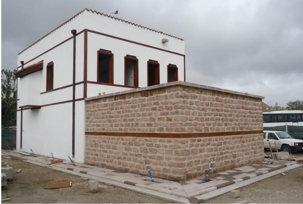
Şekil 5.7.6.5. Yapıda yeni malzeme kullanımı (KUDEB arşivi)
