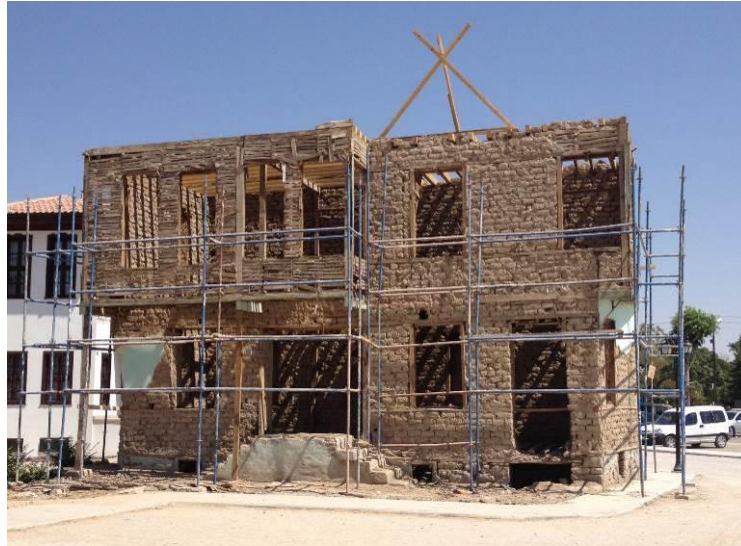
Şekil 5.1.3.1. Yapının söküm aşamasında görülen özgün strüktürel sistemi (KBB arşivi)
