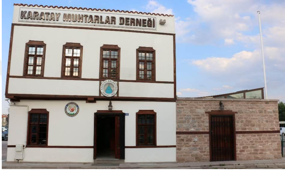
Şekil 5.7.7.1. Yapının güncel hali
