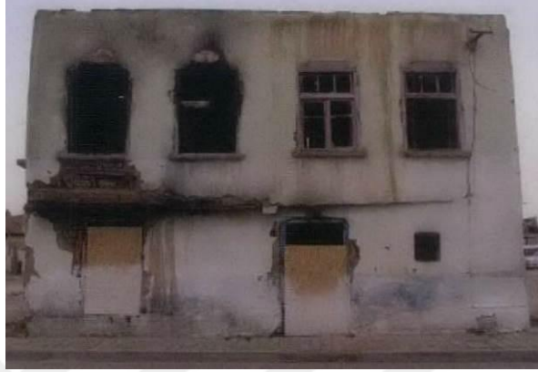
Şekil 5.7.5.1. Yapının batı cephesi pencereleri (KKVKBK arşivi)
