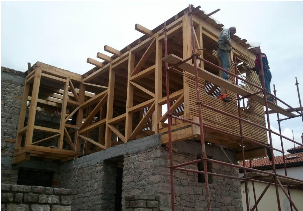
Şekil 5.3.6.3. Yapının inşası esnasında yeni malzeme kullanımı (KBB arşivi)
