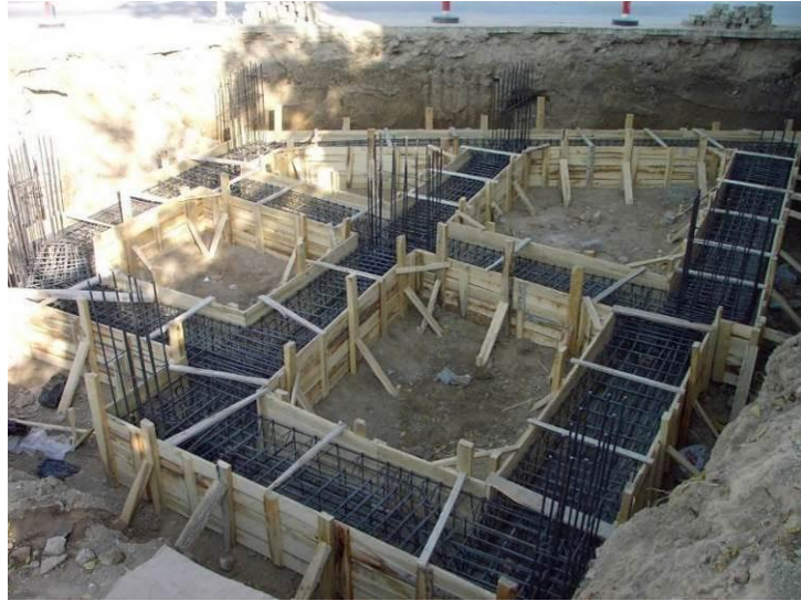
Şekil 5.5.6.6. Yapının yeniden yapımında betonarme temeli (KBB arşivi)
