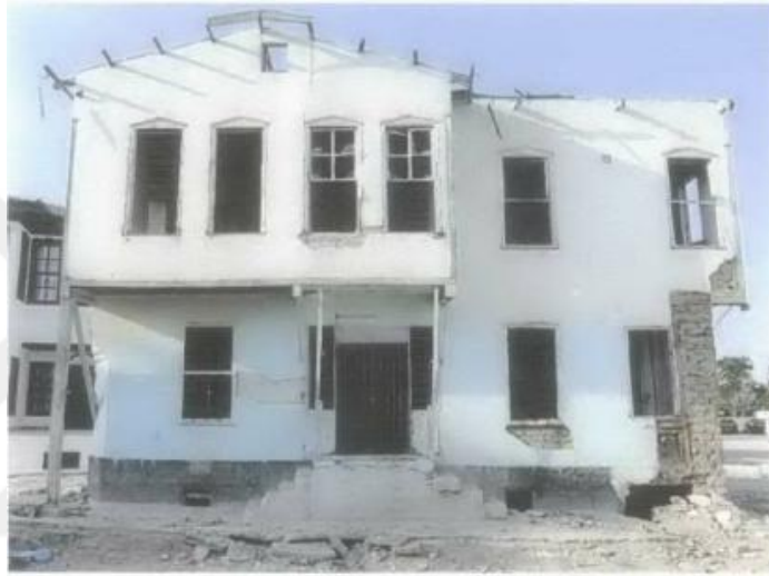
Şekil 5.1.6.1. Yapının projelendirilme aşamasından önceki durumu (DKN Mimarlık)
