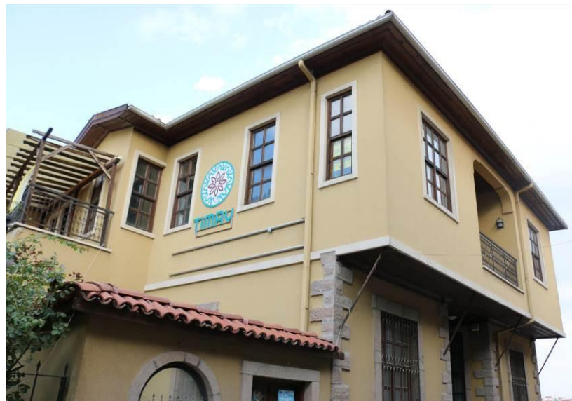
Şekil 5.6.7.2. Yapının güncel hali
