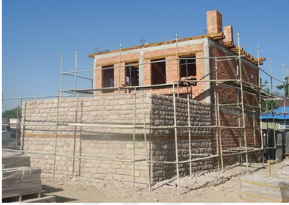
Şekil 5.7.6.4. Yapıda yeni malzeme kullanımı (KUDEB arşivi)
