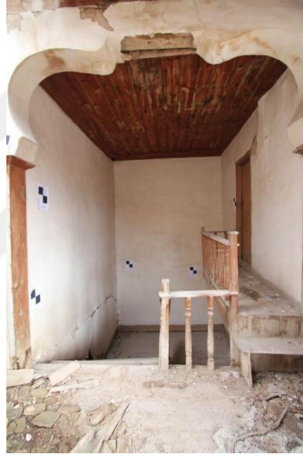
Şekil 5.8.5.1. Yapının merdiven evinden birinci kat sofasına çıkışında bulunan kemer (Rölöve raporu - Mostar Mimarlık)
