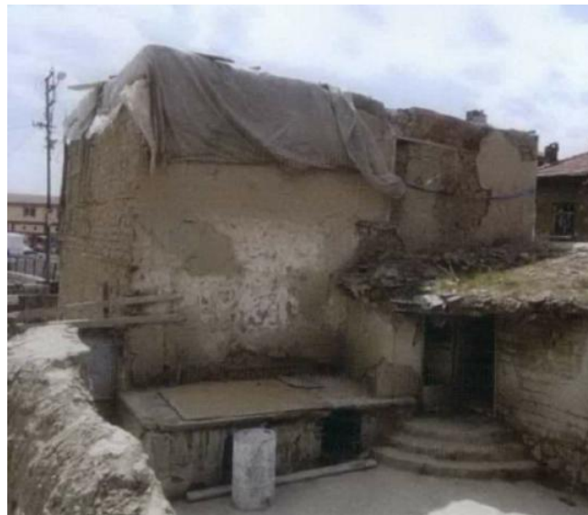
Şekil 5.3.3.2. Yapının kuzey cephesi eski fotoğrafı (Rölöve raporu-DKN Mimarlık)
