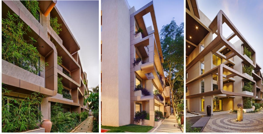
Şekil 2.24. Doğal gölgeleme elemanları kullanılarak yapılan yapılar (URL-5, 2018)
