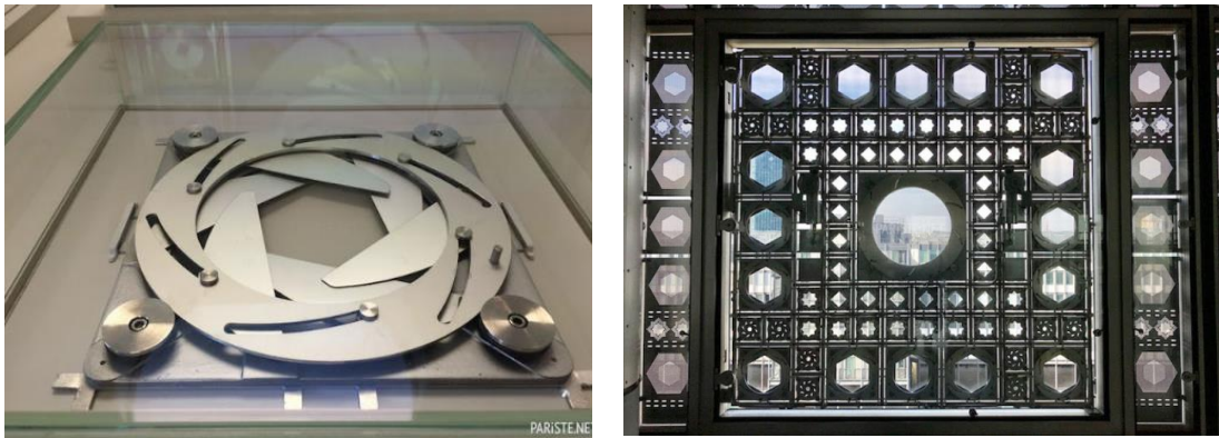
Şekil 2.40. Dünya Arap Enstitüsü binası cephe modülleri (URL-15, 2018)
