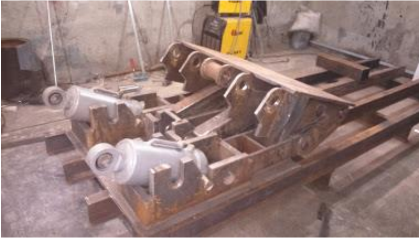
Şekil 3.15. İlk Tahkimatın İmalatı
