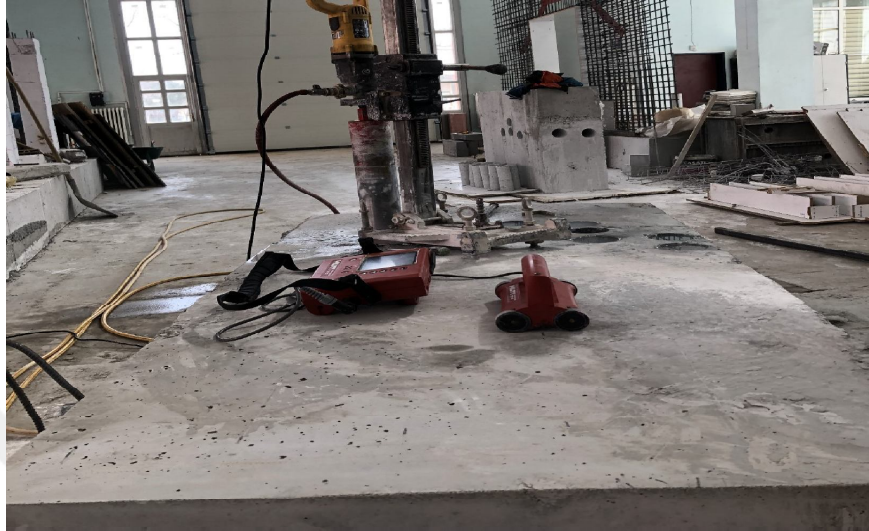
Şekil 4.1. Karot numunelerinin alınması için kullanılan karot makinesi ve röntgen cihazı
