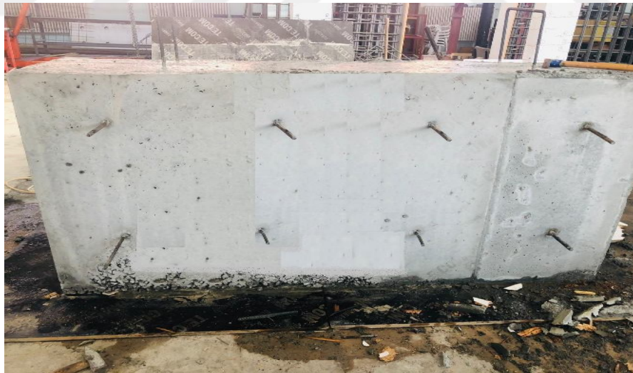
Şekil 3.13. donatılı karot numunelerinin alınması için üretilen betonarme blok.
