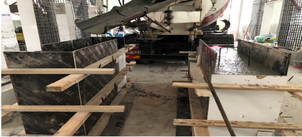
Şekil 3.10. Betonarme ve salt beton blokların beton dökümü
