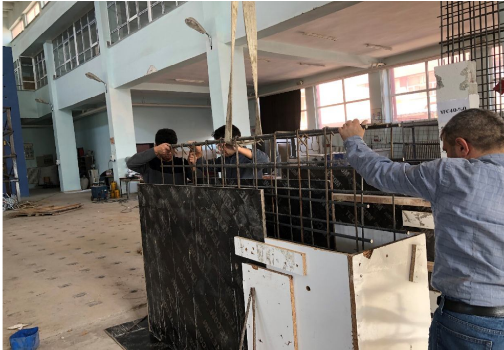
Şekil 3.9. Betonarme bloğun donatısının yerleştirilmesi
