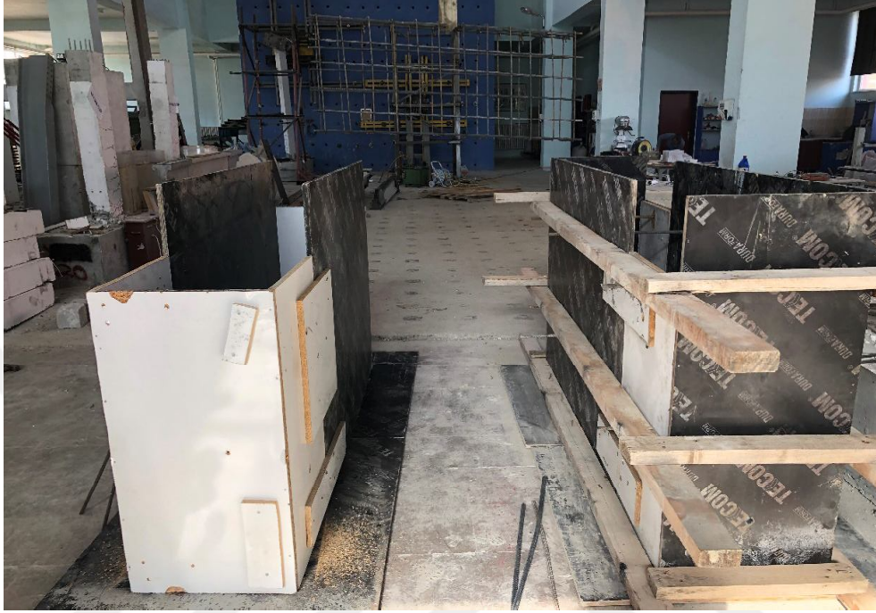
Şekil 3.8. Betonarme ve salt beton blok kalıbının üretimi
