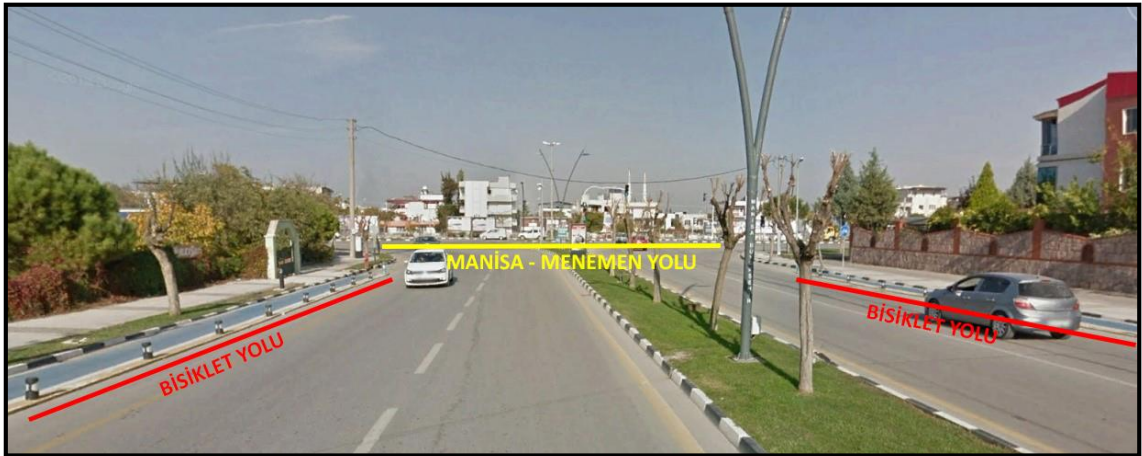
Şekil 4.13. Ingolstadt Bulvarından Menemen yolu çıkışında biten bisiklet yolu
