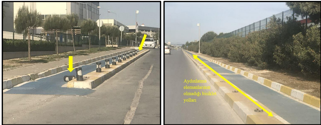
Şekil 4.32. Manisa mevcut bisiklet yollarında aydınlatma elemanlarının durumu -1
