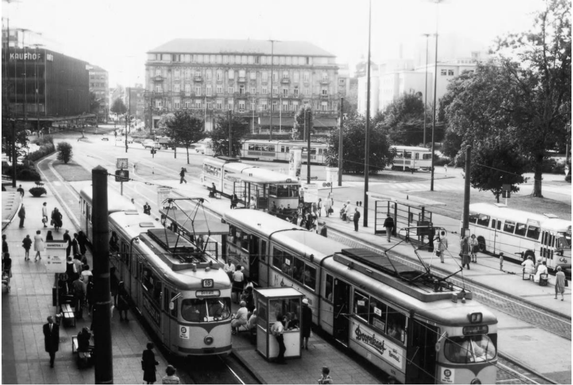
Şekil 2.18. DUEWAG şirketin ilk eklemli tramvaylar modeli. 1956-1970 yıllar arası birçok farklı ülkeler için de üretilmişlerdi (Vuchic 2007).
